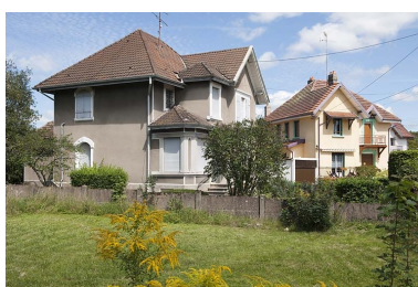
Maisons situées autour de la place semi-circulaire. Phot. Jérôme Mongreville IVR43_20112502261NUC4A
