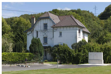
Maison individuelle. Phot. Jérôme Mongreville IVR43_20112502266NUC4A
