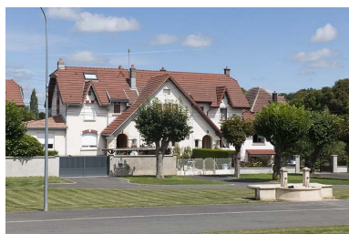
Maison à trois logements. Phot. Jérôme Mongreville IVR43_20112502253NUC4A
