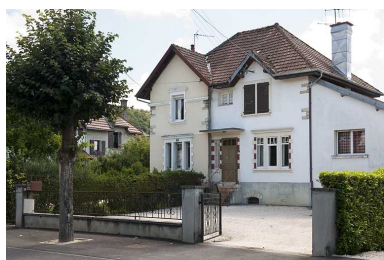
Maison mitoyenne. Phot. Jérôme Mongreville IVR43_20112502263NUC4A
