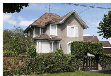
Maison individuelle. Phot. Jérôme Mongreville IVR43_20112502262NUC4A
