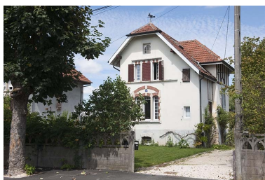
Maison individuelle. Phot. Jérôme Mongreville IVR43_20112502254NUC4A
