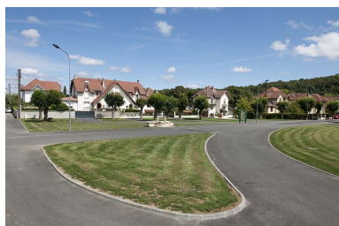
Vue d'ensemble depuis l'avenue Frédéric Bataille. Phot. Jérôme Mongreville IVR43_20112502252NUC4A
