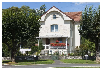
Maison individuelle. Phot. Jérôme Mongreville IVR43_20112502265NUC4A
