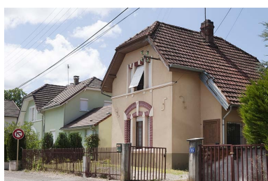
Maisons rue des Lilas. Phot. Jérôme Mongreville IVR43_20112502260NUC4A
