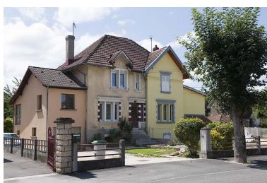
Maison mitoyenne. Phot. Jérôme Mongreville IVR43_20112502257NUC4A
