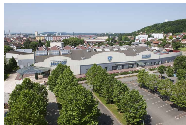
Vue plongeante sur le bâtiment du musée. Phot. Jérôme Mongreville IVR43_20122501821NUC4A
