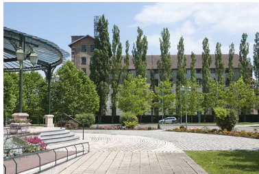
La malterie vue depuis l'ouest. Phot. Jérôme Mongreville IVR43_20122501824NUC4A
