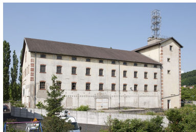
Façade est la malterie. Phot. Jérôme Mongreville IVR43_20122501818NUC4A
