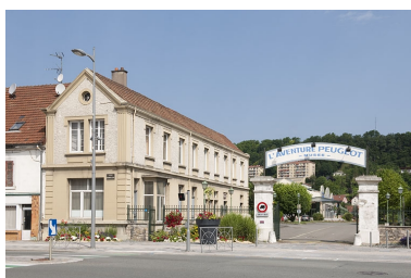
Entrée de l'établissement. Phot. Jérôme Mongreville IVR43_20122501817NUC4A
