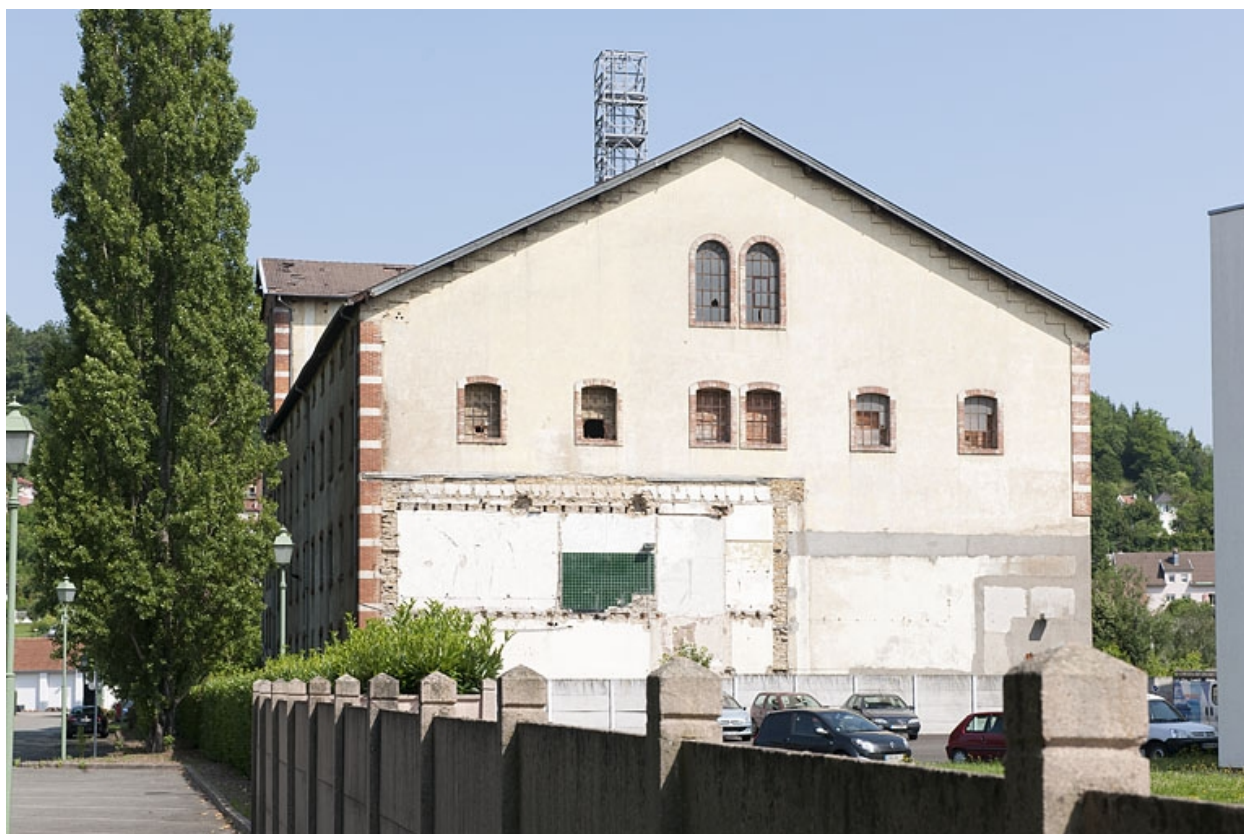
Pignon sud de la malterie.
