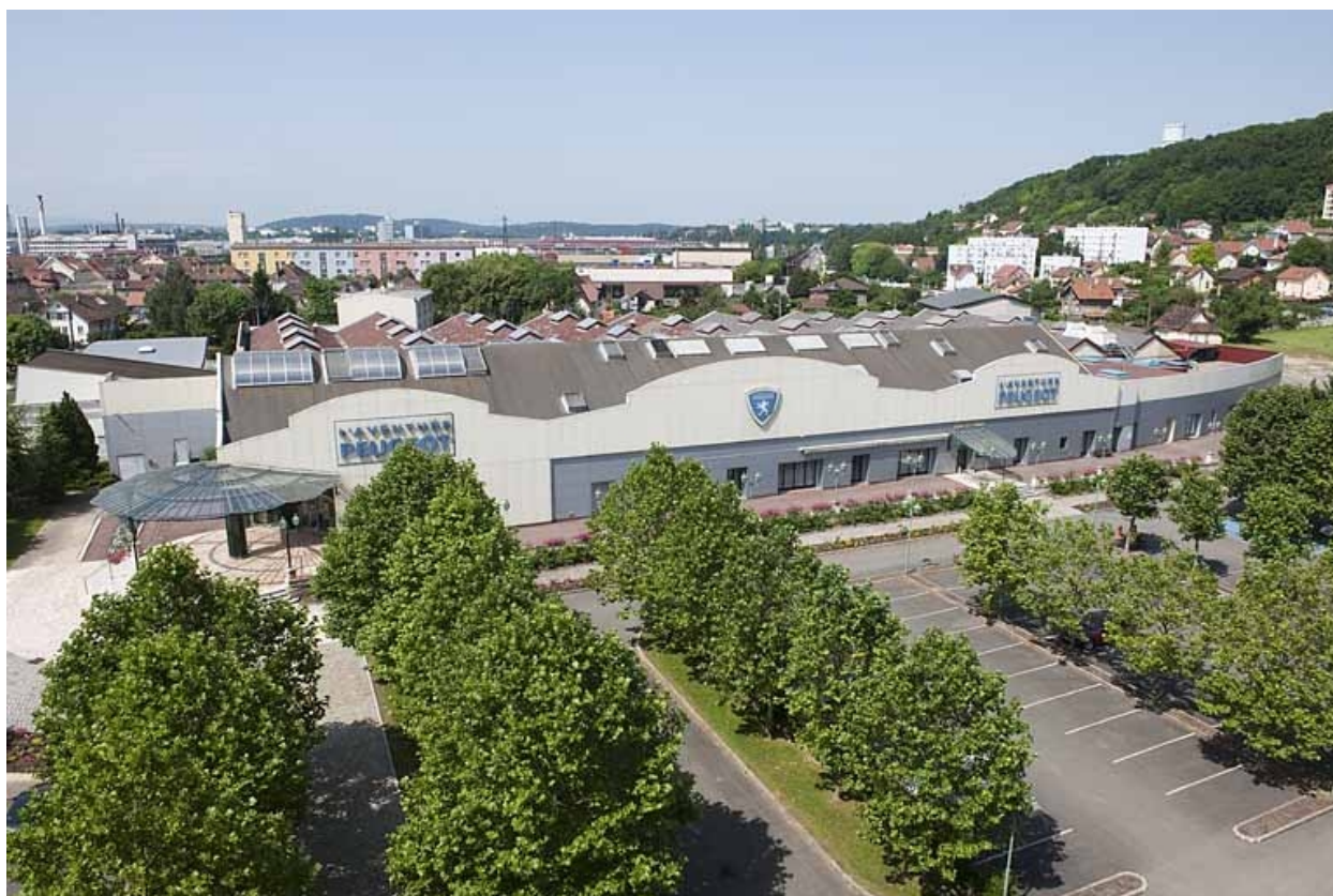
Vue plongeante sur le bâtiment du musée.
