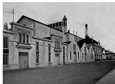
Ateliers et magasins. Phot. Raphaël Favereaux, Autr. IVR43_20122501319NUC2A
