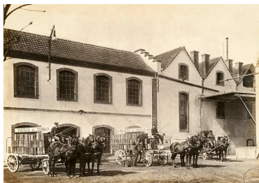
Chargement des bouteilles. Phot. Jérôme Mongreville IVR43_20132500477NUC4A
