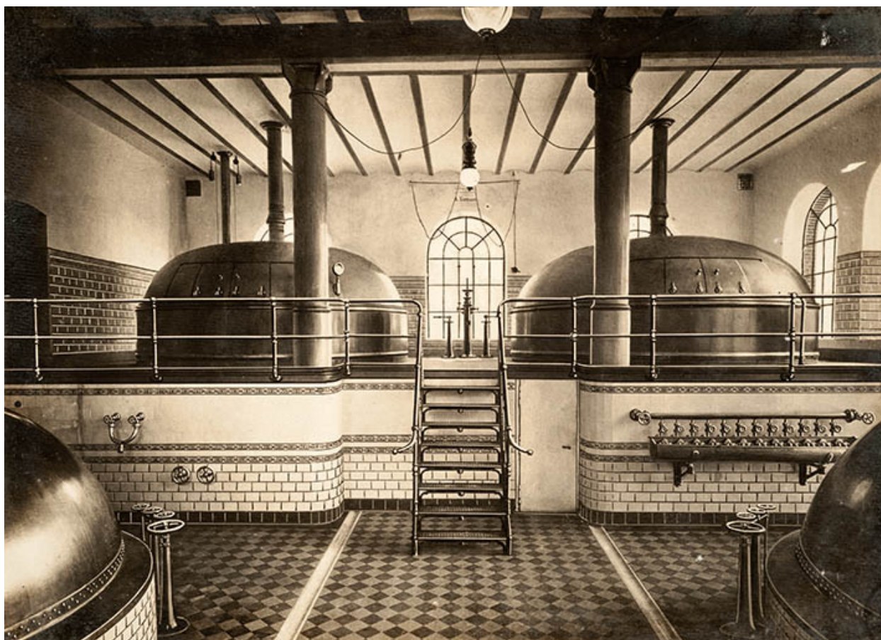
Chaudières à houblonner.
