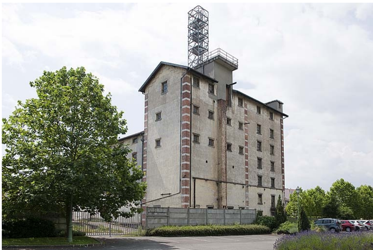
La malterie vue depuis le nord-est.
