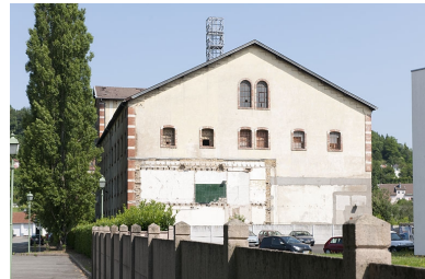
Pignon sud de la malterie. Phot. Jérôme Mongreville IVR43_20122501819NUC4A
