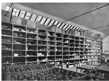
Vue intérieure des magasins. Phot. Raphaël Favereaux, Autr. IVR43_20122501351NUC2A
