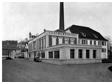
Les bureaux. Phot. Raphaël Favereaux, Autr. IVR43_20122501318NUC2A
