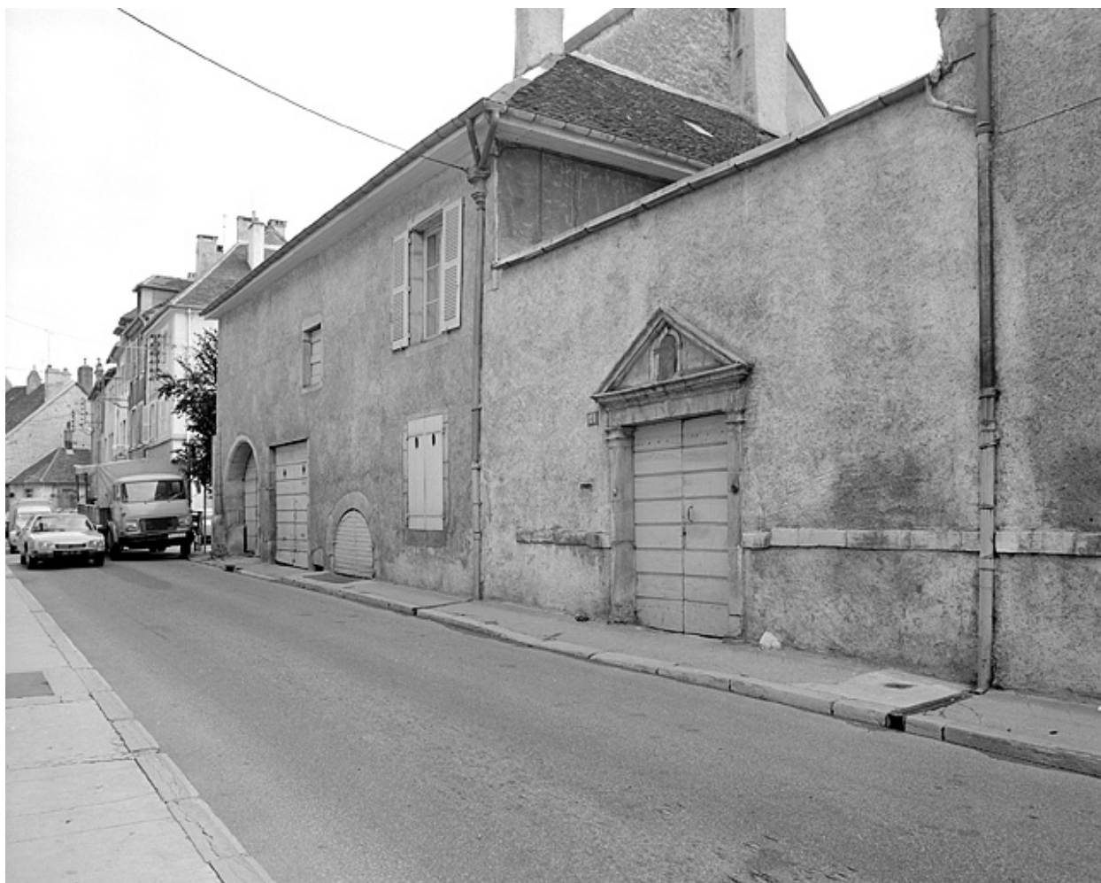
Façade antérieure, partie centrale.
