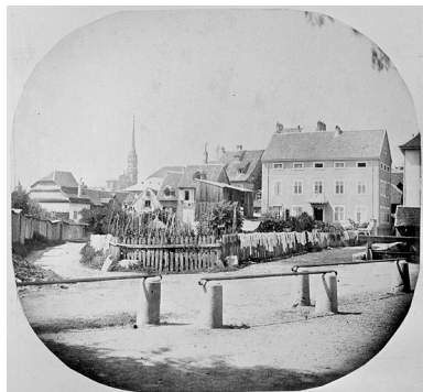
Vue d'ensemble du quartier des Tanneurs et de la maison, années 1860. Phot. IVR43_19872500983X
