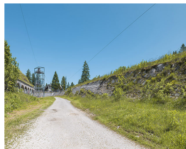
Front est : vue en direction du nord. Phot. Thierry Kuntz IVR43_20253900397NUC4A
