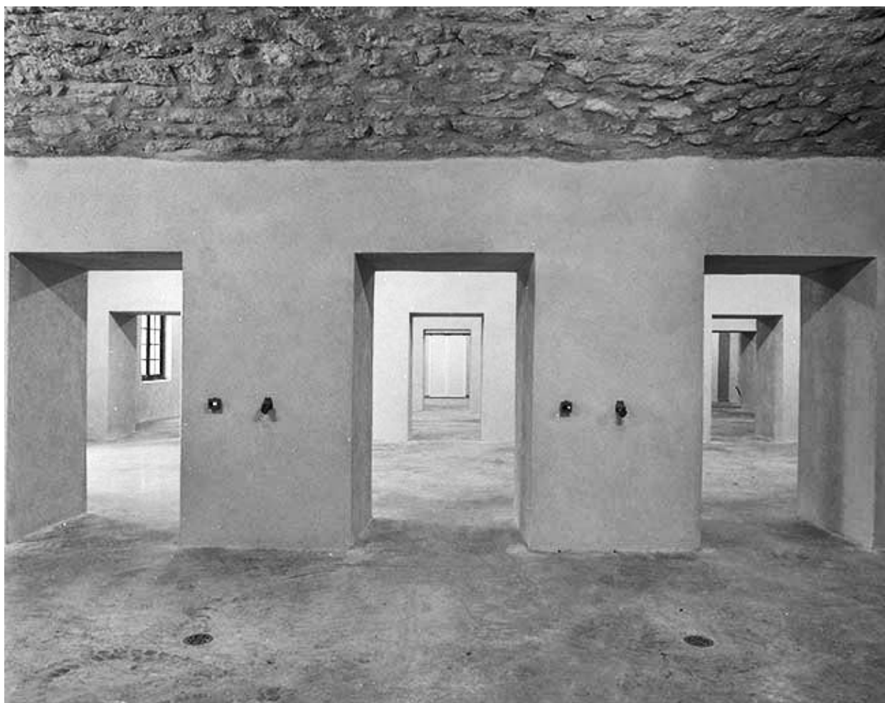
Bâtiment Quitry, pièces successives couvertes de voûtes en berceau segmentaire (en 2000).
