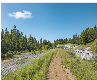
Vue d'une partie du front est. De gauche à droite : le glacis, le chemin couvert et le rempart avec ses arcs de décharge. Phot. Thierry Kuntz IVR43_20253900389NUC4A
