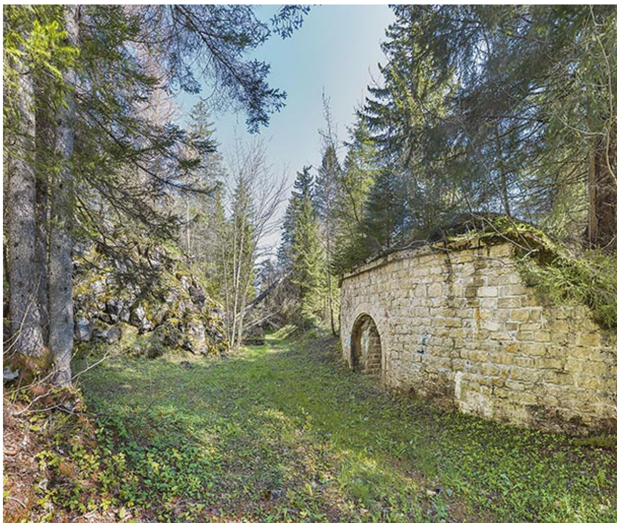
Traverse-abri à la courtine est.
