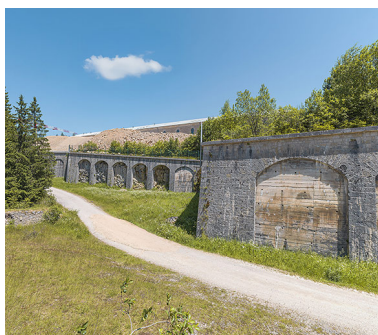
Front ouest : détail d'un arc de décharge hourdis de béton. Phot. Thierry Kuntz IVR43_20253900414NUC4A
