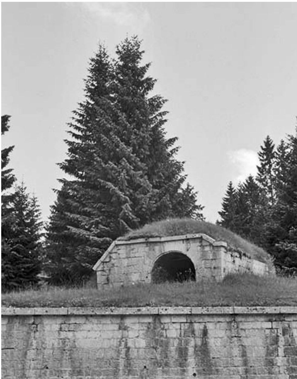
Ouvrage avancé face au porche d'accès (en 2000).
