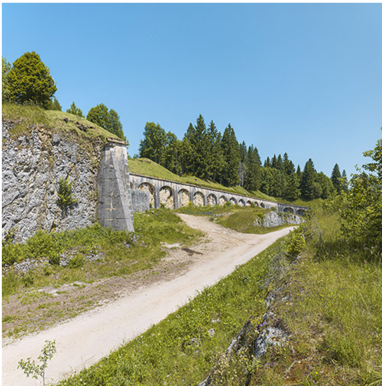
Front sud-est : vue générale.
