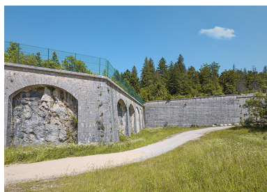
Front ouest : détail d'un arc de décharge avec roc apparent. Phot. Thierry Kuntz IVR43_20253900411NUC4A
