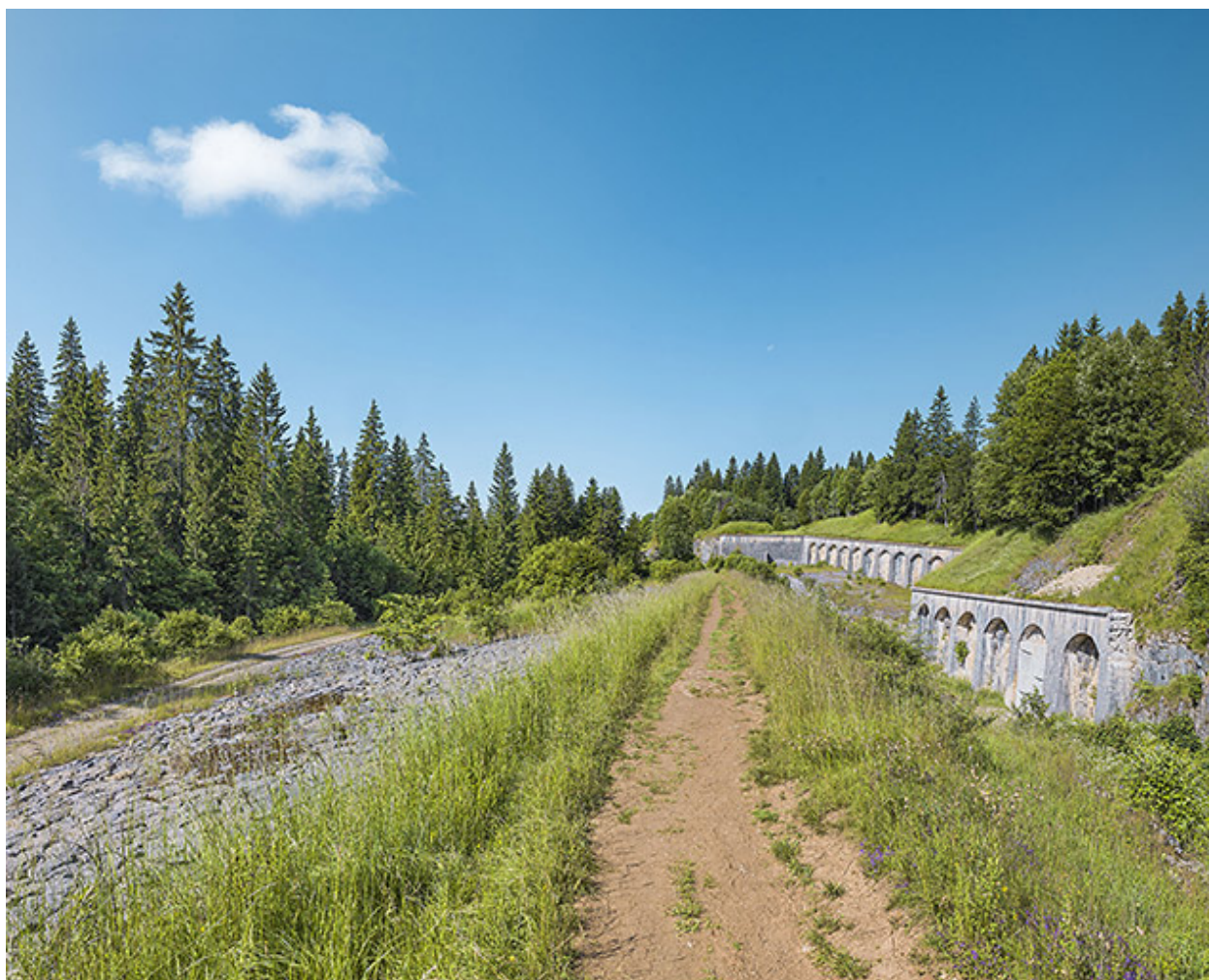
Vue d'une partie du front est. De gauche à droite : le glacis, le chemin couvert et le rempart avec ses arcs de décharge.
