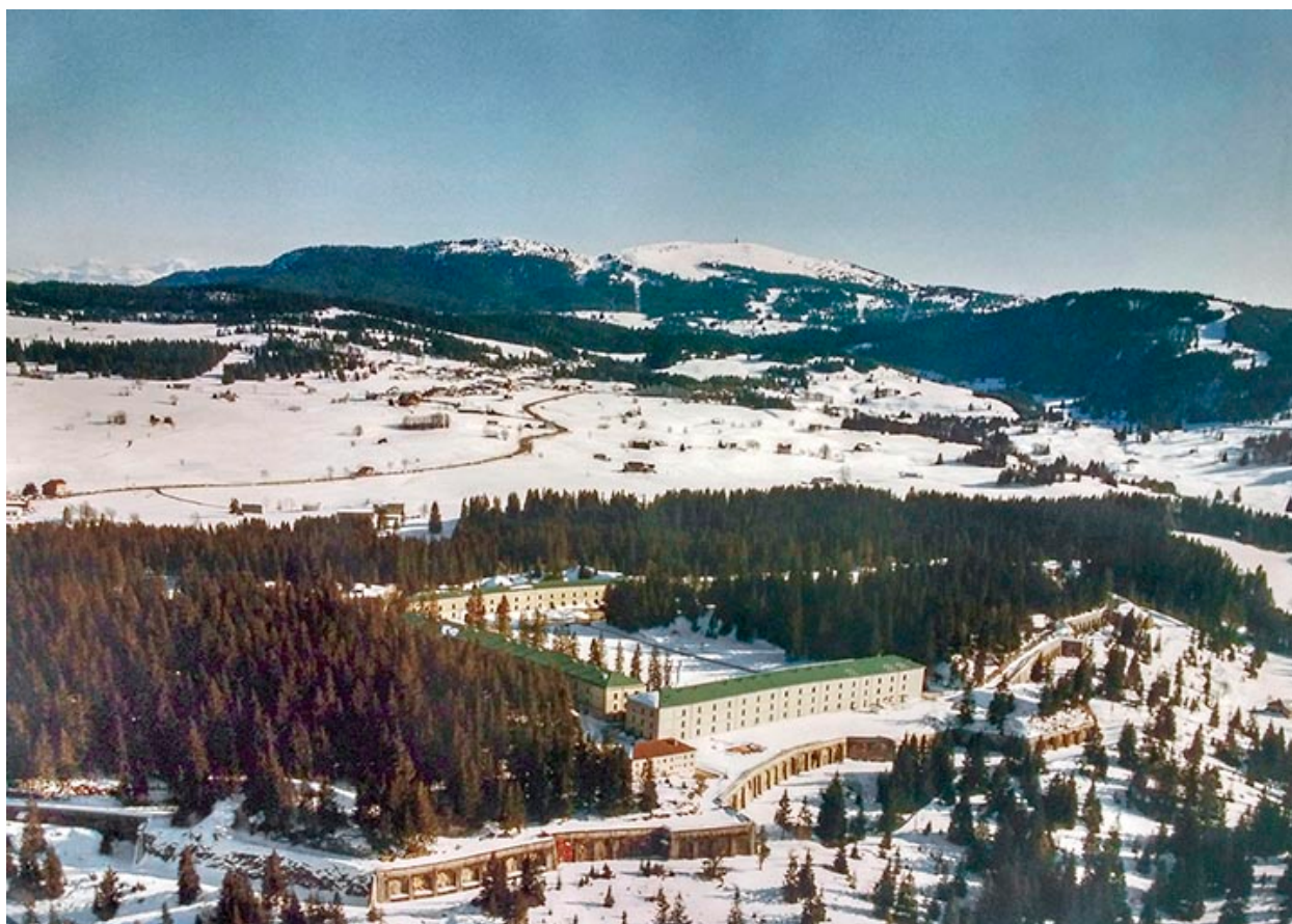
Vue aérienne générale du front ouest.
