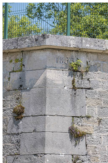
Date portée sur le rempart au front nord ouest. Phot. Thierry Kuntz IVR43_20253900400NUC4A
