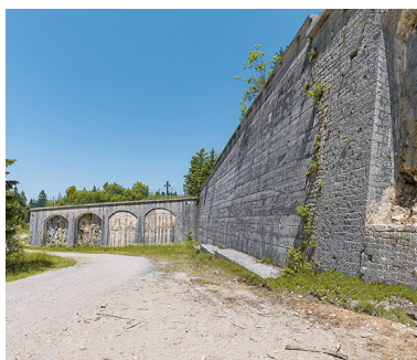
Le mur d'enceinte au front ouest. Des arcs sont hourdis de béton. Phot. Thierry Kuntz IVR43_20253900409NUC4A
