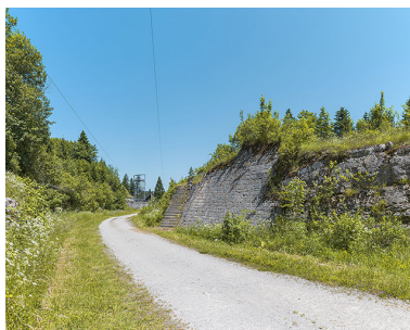
Le front est : mur d'enceinte partiellement maçonné et taillé dans le roc. Phot. Thierry Kuntz IVR43_20253900396NUC4A
