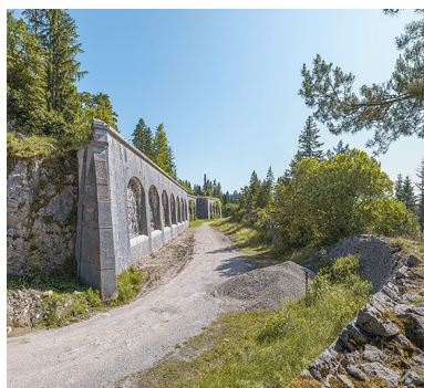
Front ouest : vue en enfilade des arcs de décharge du rempart. Phot. Thierry Kuntz IVR43_20253900418NUC4A
