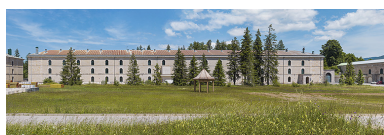
Intérieur de la place : la caserne Quitry. Phot. Thierry Kuntz IVR43_20253900381NUC4A
