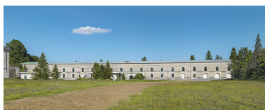
Intérieur de la place : le cavalier 12. Phot. Thierry Kuntz IVR43_20253900380NUC4A
