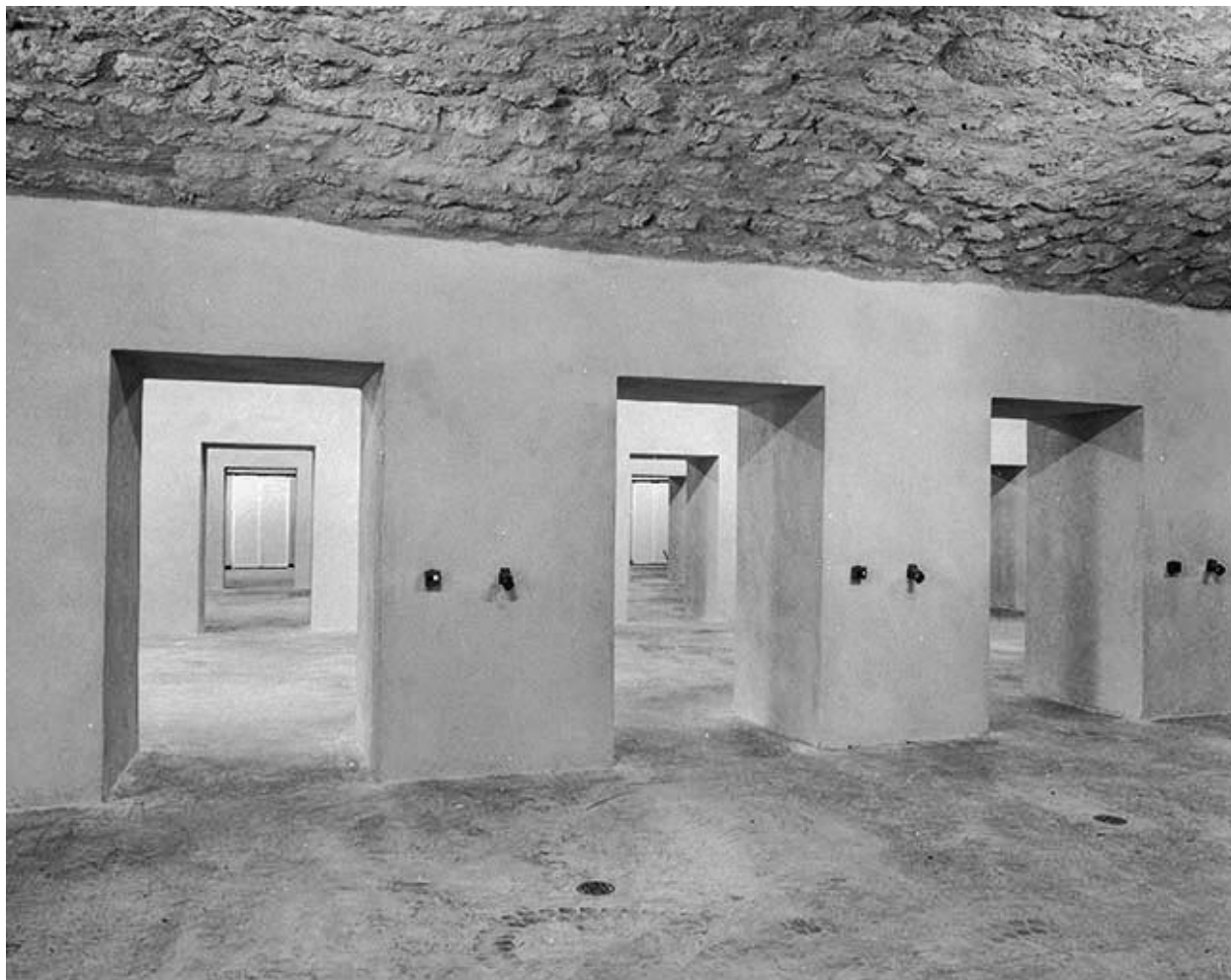
Bâtiment Cavalier, salles successives couvertes de voûtes en berceau segmentaire (en 2000).
