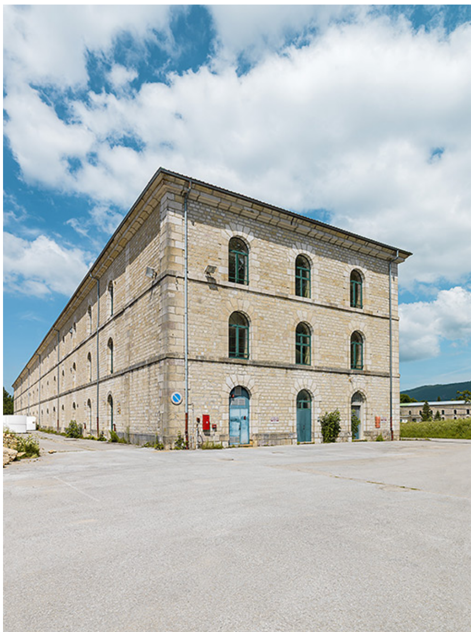
Intérieur de la place : façades latérale et postérieure de la caserne Saint-Germain.
