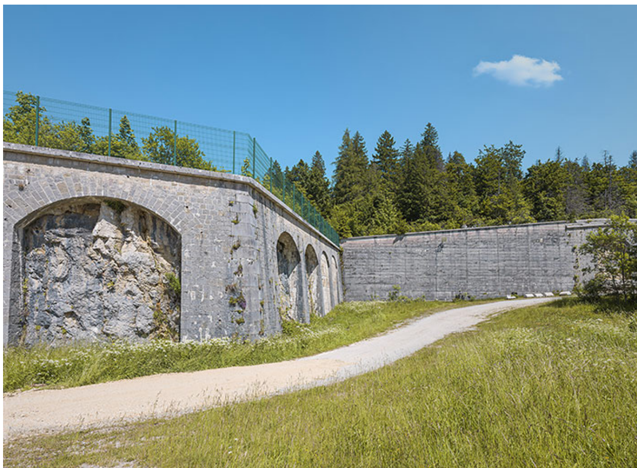
Front ouest : détail d'un arc de décharge avec roc apparent.
