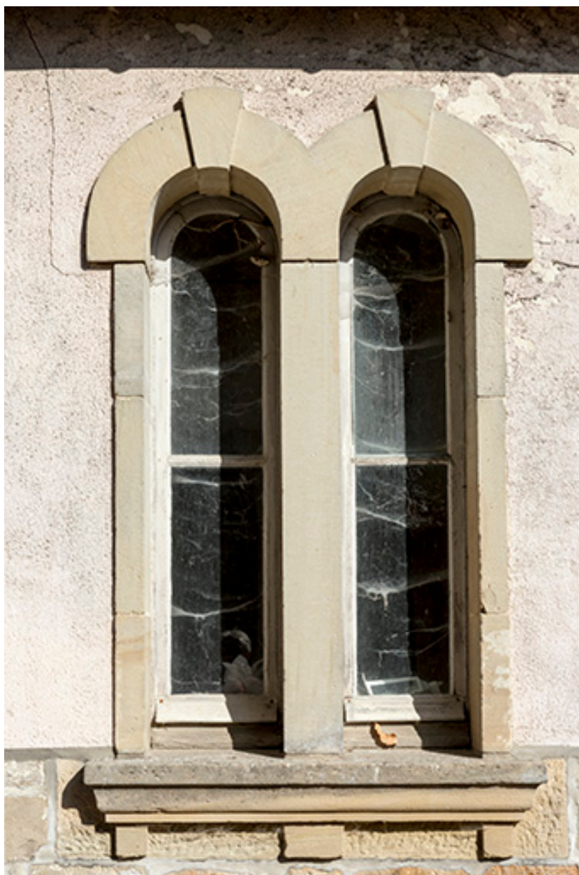
Détail des baies jumelées de l'ancienne dépendance.
