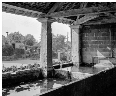
Vue de l'intérieur. Phot. Yves Sancey IVR43_19767000590X
