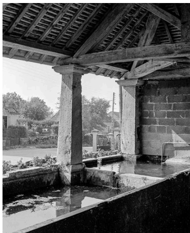
Vue de l'intérieur. Phot. Yves Sancey IVR43_19767000591X
