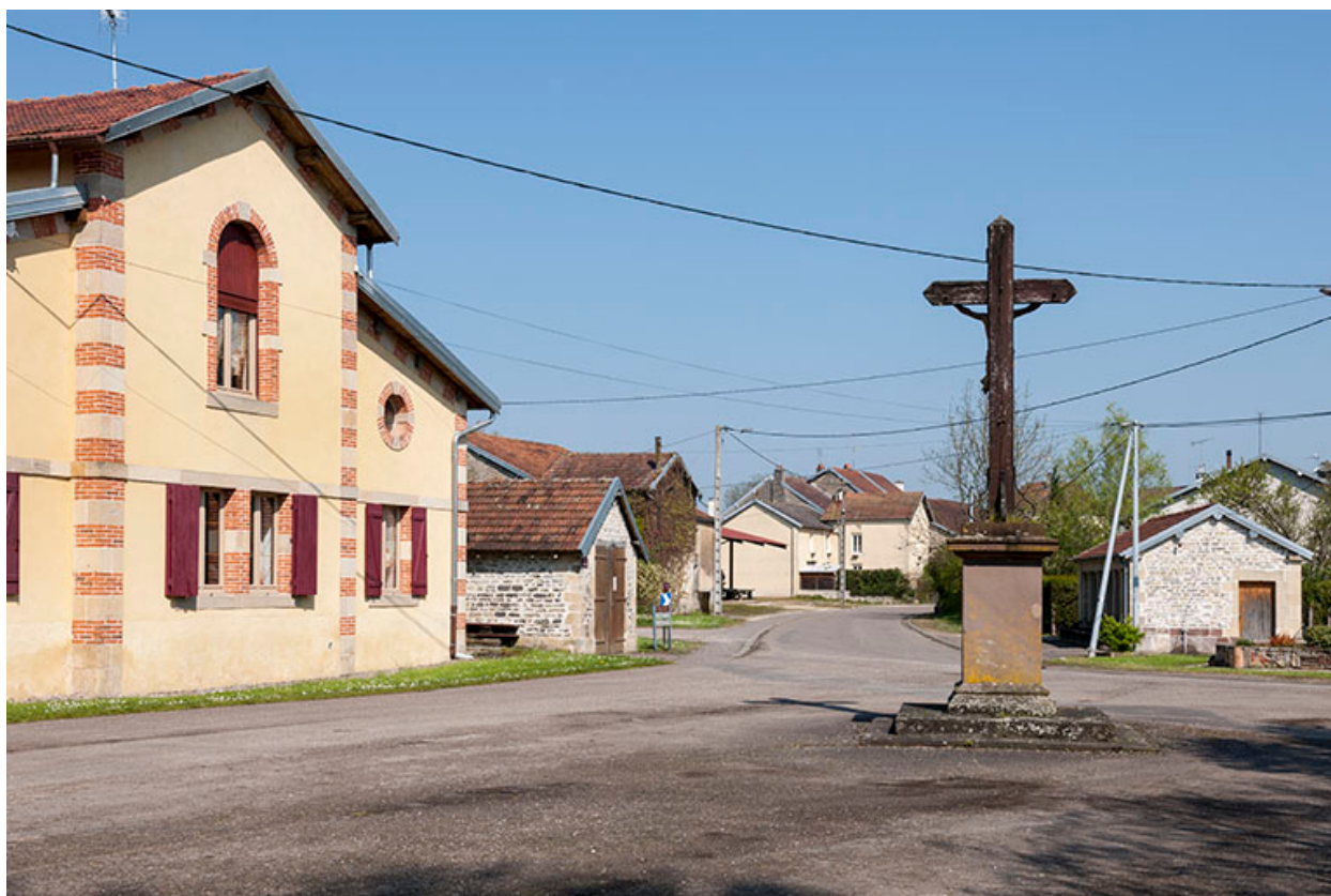
Vue depuis la route de l'Eglise.
