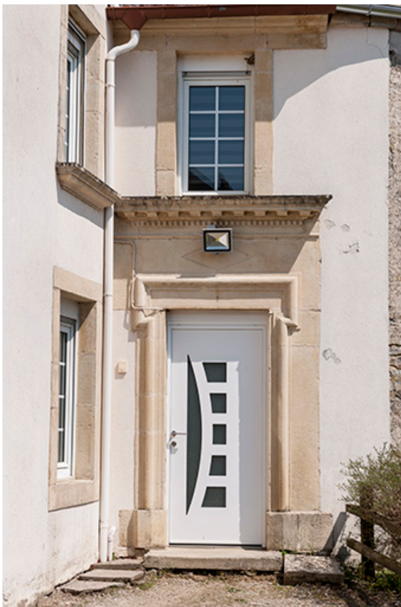
Détail du décor de l'entrée, partie habitation.
