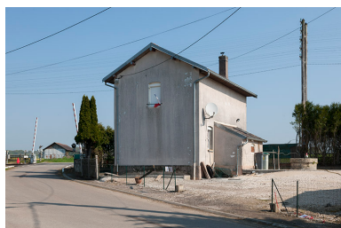
Maison garde-barrière de la commune. Phot. Jérôme Mongreville IVR43_20167000336NUC4A
