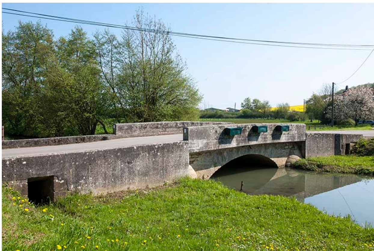
Le pont permettant de franchir le ruisseau.
