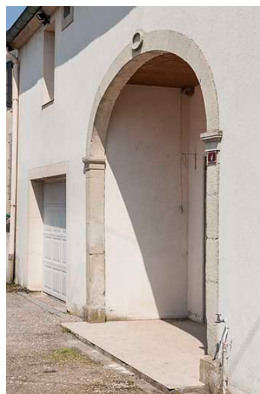
La porte charretière. Phot. Jérôme Mongreville IVR43_20167000381NUC4A
