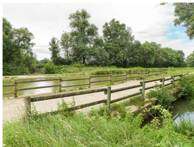
Vue du déversoir.
