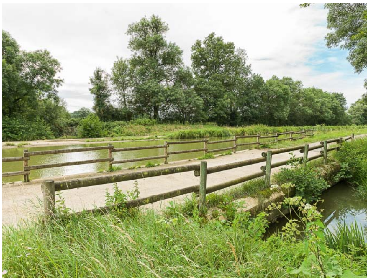
Vue du déversoir.
