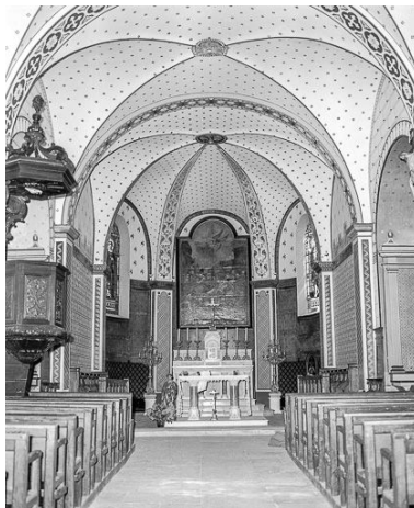
Chœur vu depuis la nef.
