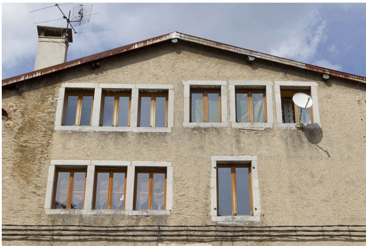
Fenêtres multiples de l'immeuble au 80 rue de la République (AE 33). Les fenêtres multiples de cet immeuble, qui a abrité l'usine d'horlogerie Bailly-Comte, sont d'un module intermédiaire entre la fenêtre courante et la fenêtre lunetière.
