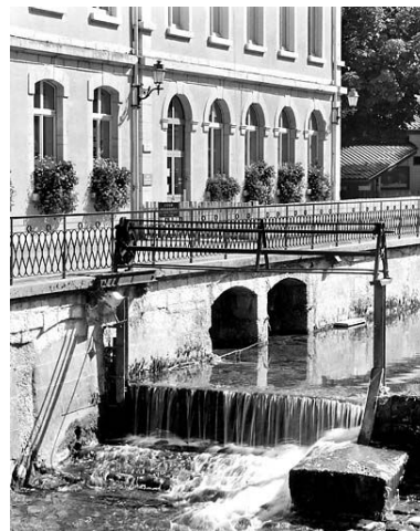
Barrage et prise d'eau de l'ancien site Paul Odobey Fils (1 à 13 cours Paul Odobey). Le canal d'amenée passe sous la mairie. Phot. Yves Sancey IVR43_20033900300X
