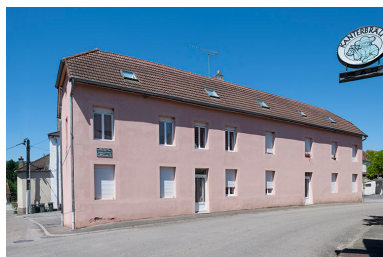
Vue générale de l'édifice.
