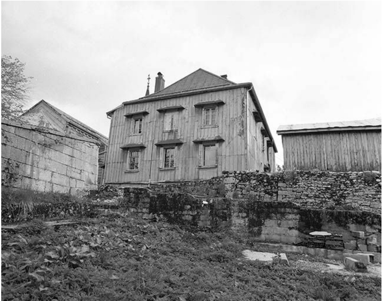
Vue éloignée de la façade ouest.
