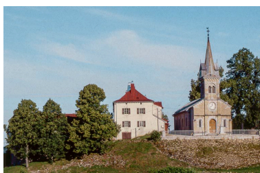
Vue éloignée du presbytère et de l'église. Phot. Yves Sancey IVR43_19993900236ZA
