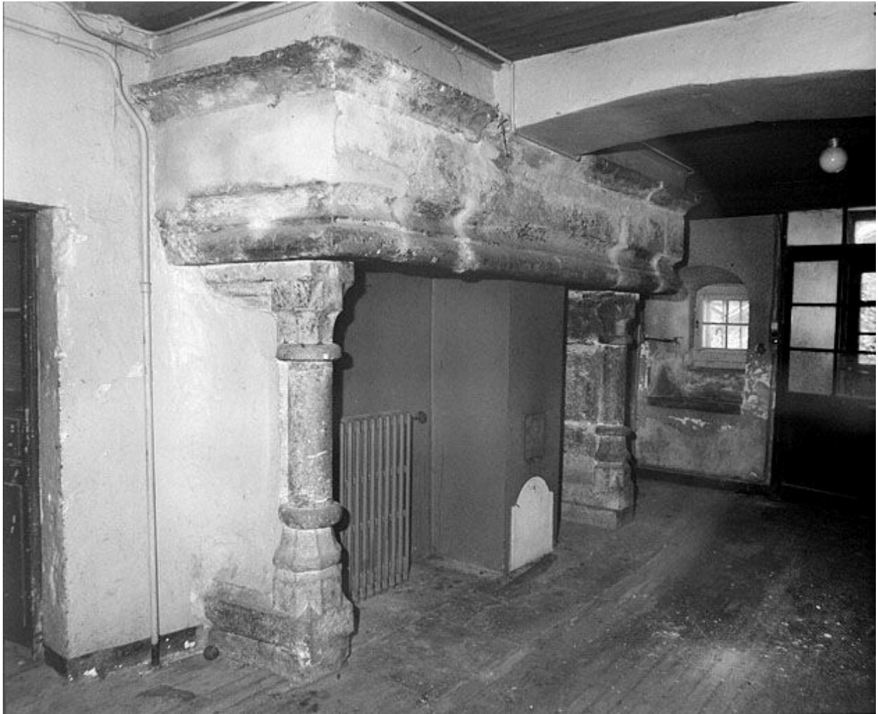
Vue intérieure, cheminée.
