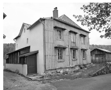
Façades nord et ouest vues de trois quarts. Phot. Yves Sancey IVR43_19993900246X
