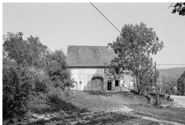
Façade antérieure en 1976. Phot. Bernard Pontefract IVR43_19763900247Z
