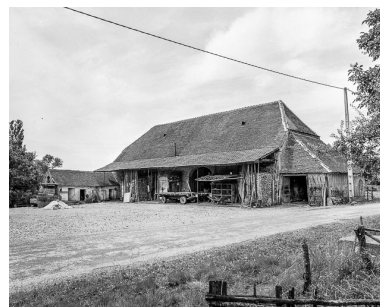
Le bâtiment d'exploitation. Phot. Dominique Dominguez IVR43_19773900066X
