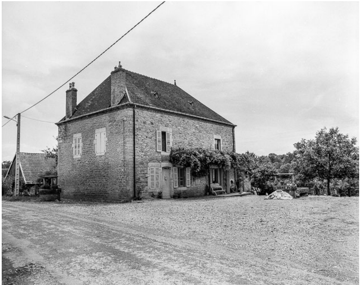
Le bâtiment d'habitation, façade antérieure.
