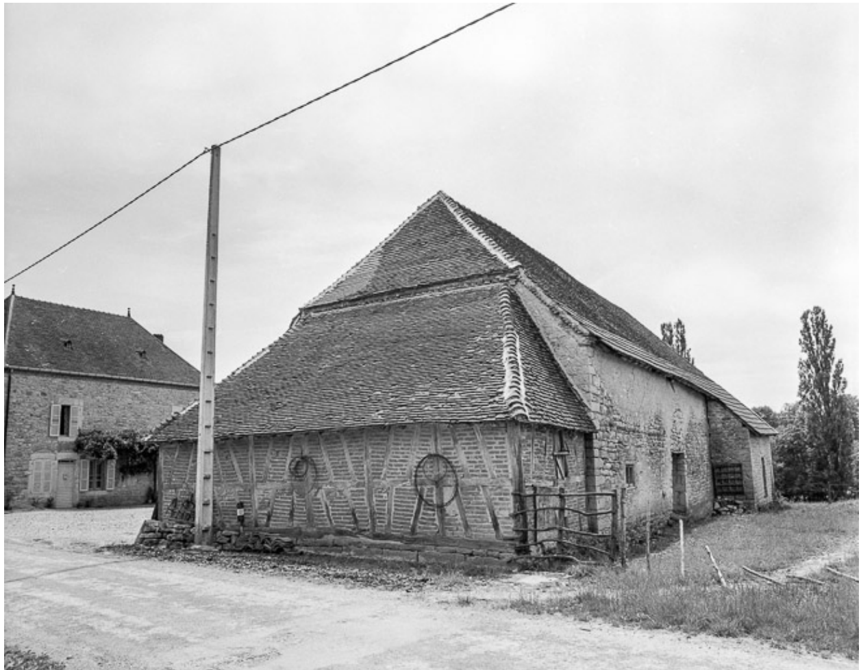
Bâtiment d'exploitation, façade postérieure et face droite.
