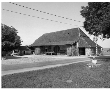
Le bâtiment d'exploitation en 1990. Phot. Yves Sancey IVR43_19903901171X
