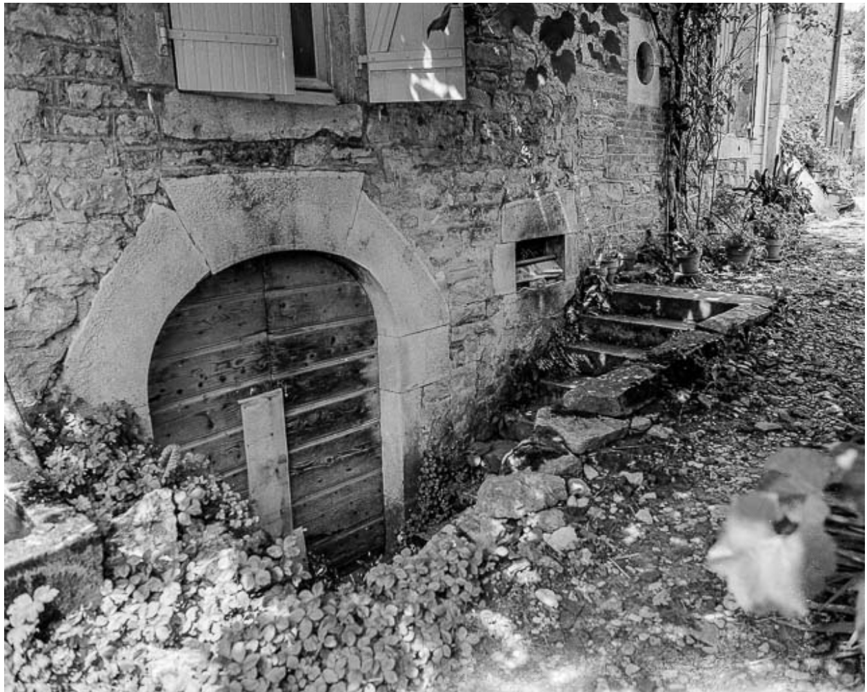
Bâtiment d'habitation : l'entrée de cave sur la façade postérieure.
