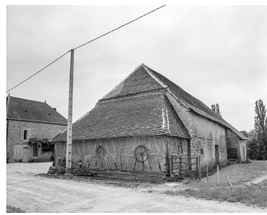
Bâtiment d'exploitation, façade postérieure et face droite. Phot. Dominique Dominguez IVR43_19773900069X
