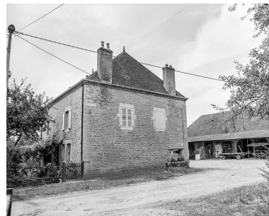
Le bâtiment d'habitation : façade postérieure de trois quarts et pignon droit. Phot. Dominique Dominguez IVR43_19773900064X
