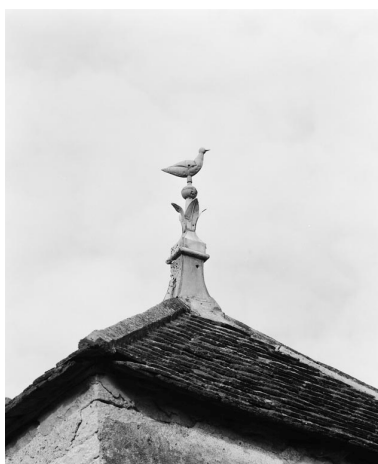
Détail de l'épi de faîtage du colombier, parcelle 647, section C2 sur le cadastre de 1948. Phot. Michel Thierry IVR26_19792101679X
