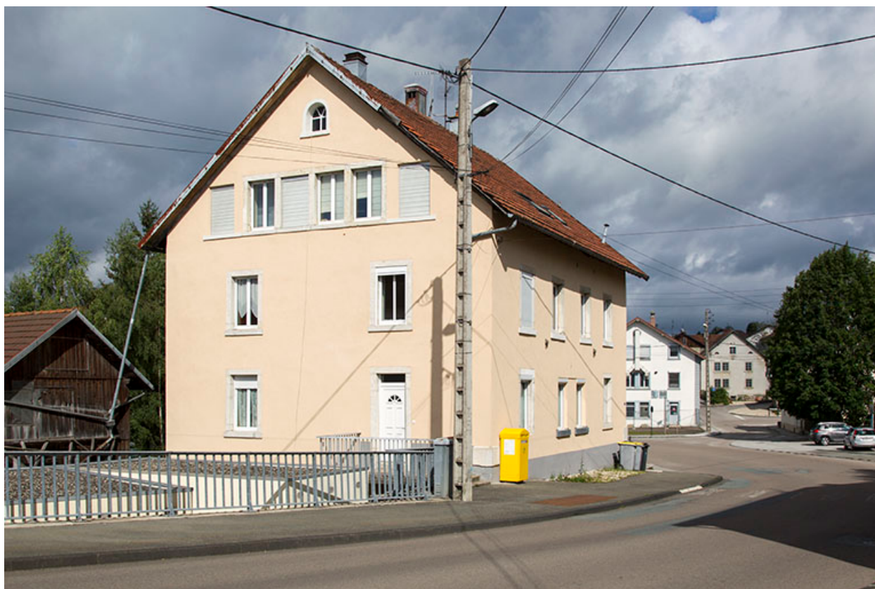
Façades postérieure et latérale droite.
