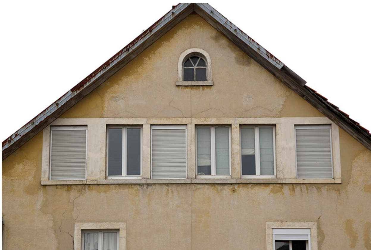
Façade postérieure en 2012 (avant rénovation) : fenêtres multiples.
