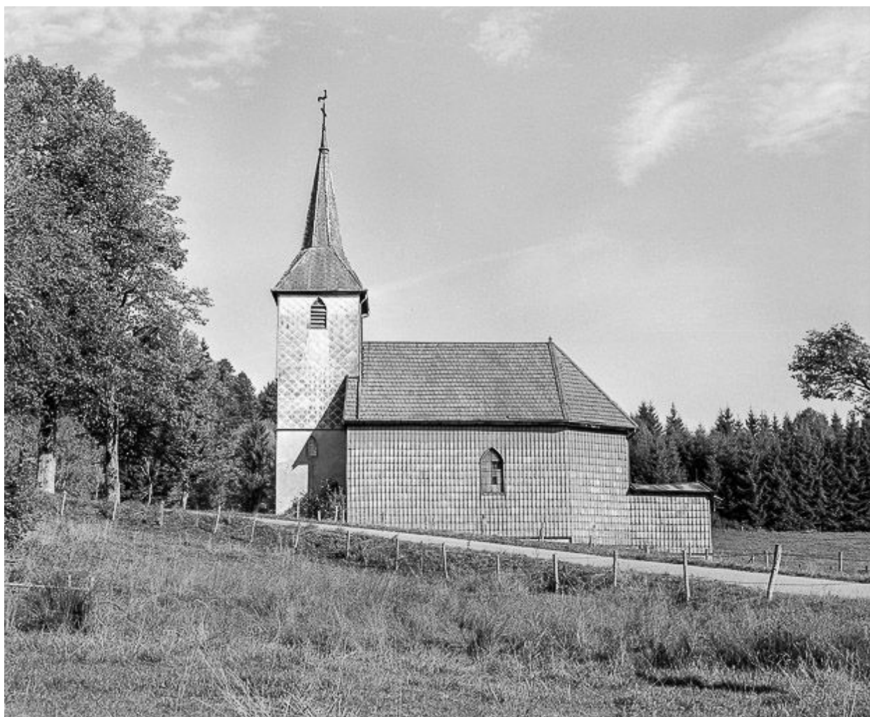
Façade latérale droite.
