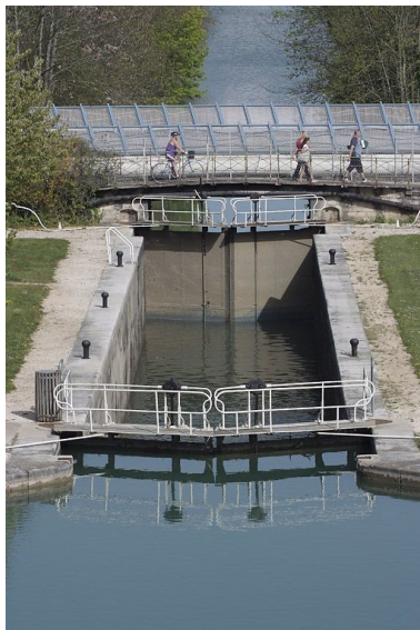
Tête aval de l'écluse 54, avec le pont ancien sur écluse doublé par le pont moderne. Phot. Thierry Kuntz IVR26_20112102685NUC2A
