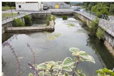
Bassin aménagé à l'emplacement du canal d'amenée.
