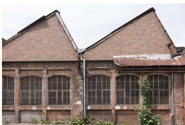
Atelier de fabrication. Pignons de sheds.
