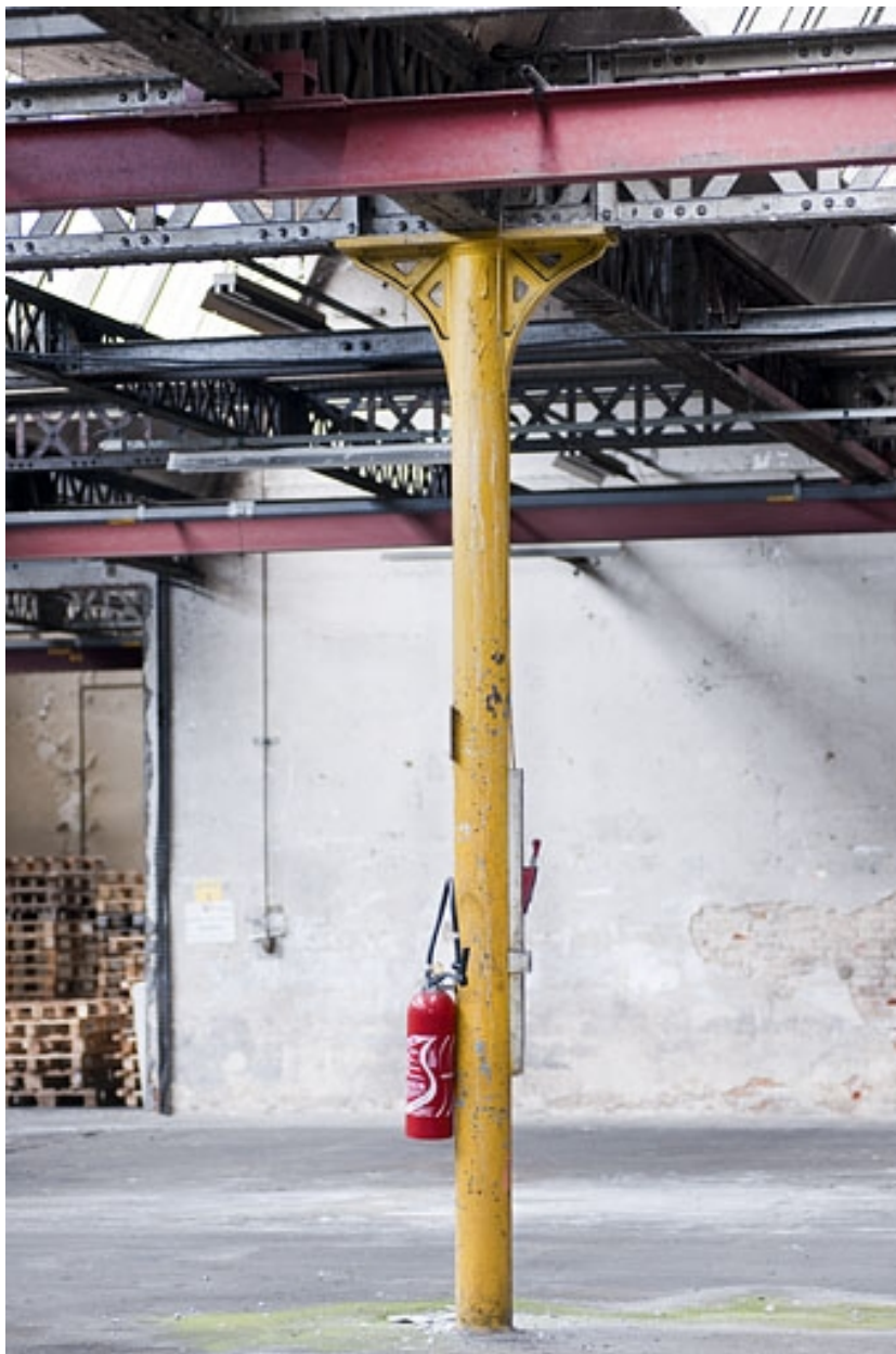
Colonne en fonte et charpente métallique.
