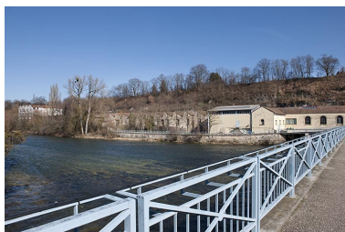
Partie nord du site vue depuis le pont. Phot. Jérôme Mongreville IVR43_20122500111NUC4A
