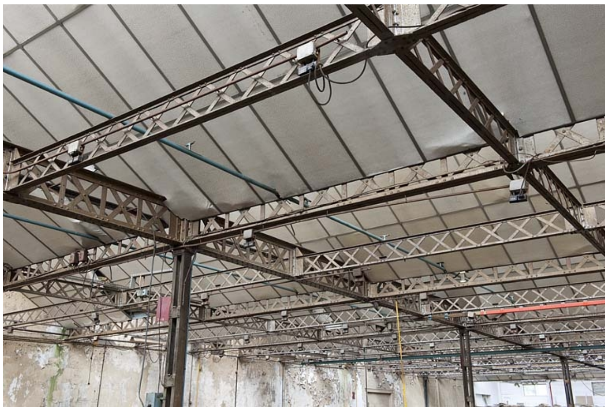
Atelier de fabrication. Eléments de charpente métallique.
