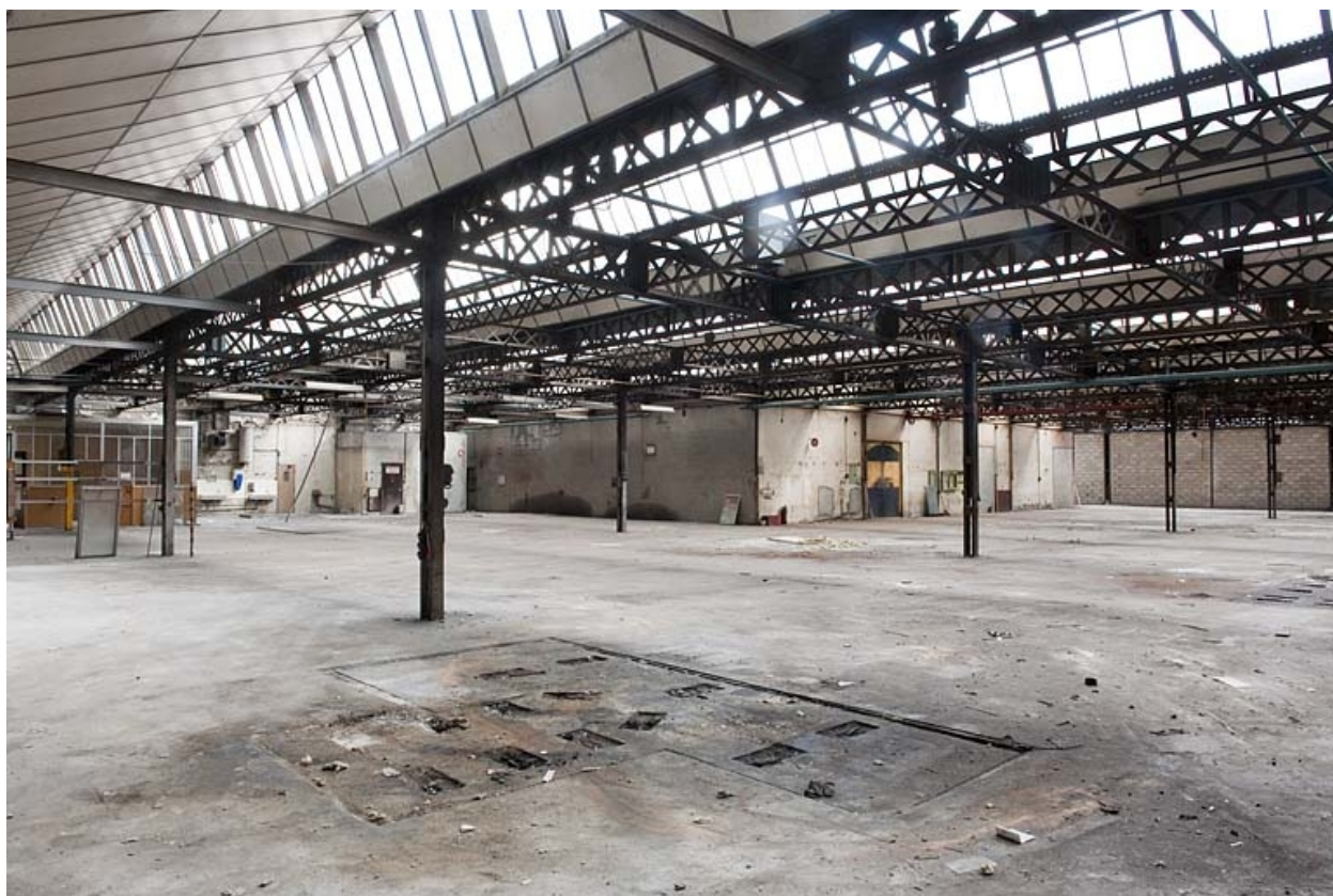
Atelier de fabrication. Vue depuis le sud-est.
