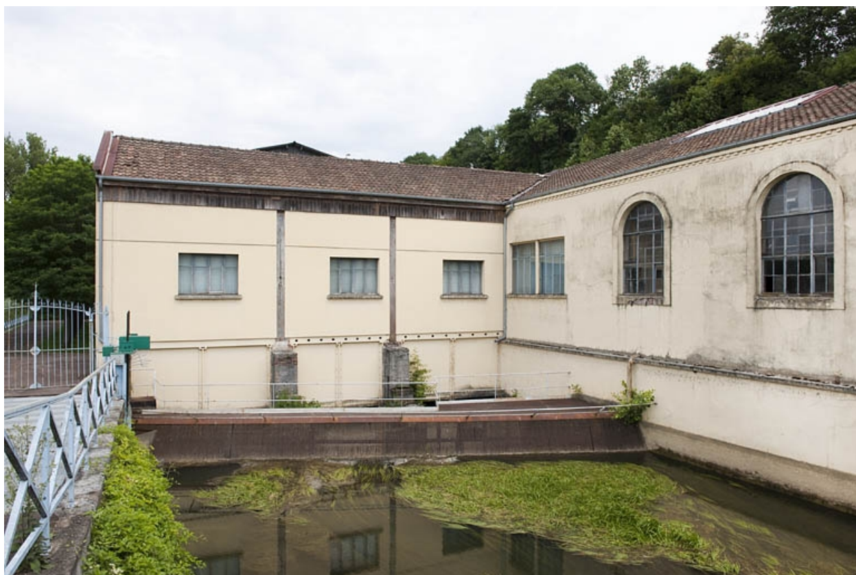
Bâtiment d'eau vu depuis l'amont.
