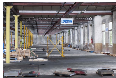
Travée d'un atelier de fabrication.
