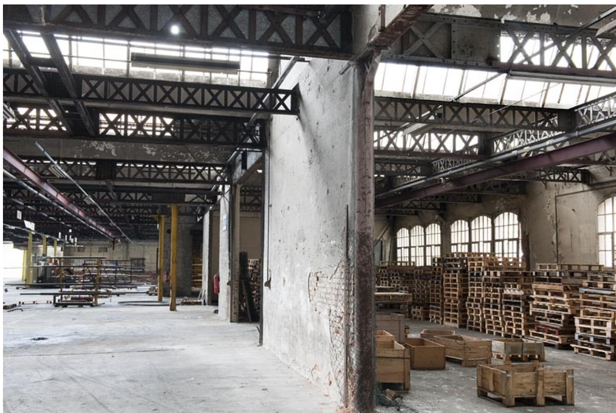
Partie d'un atelier de fabrication.
