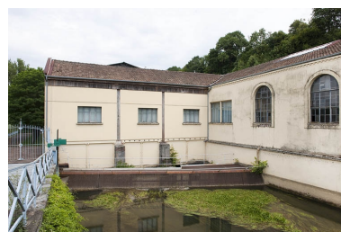
Bâtiment d'eau vu depuis l'amont. Phot. Jérôme Mongreville IVR43_20112501550NUC4A
