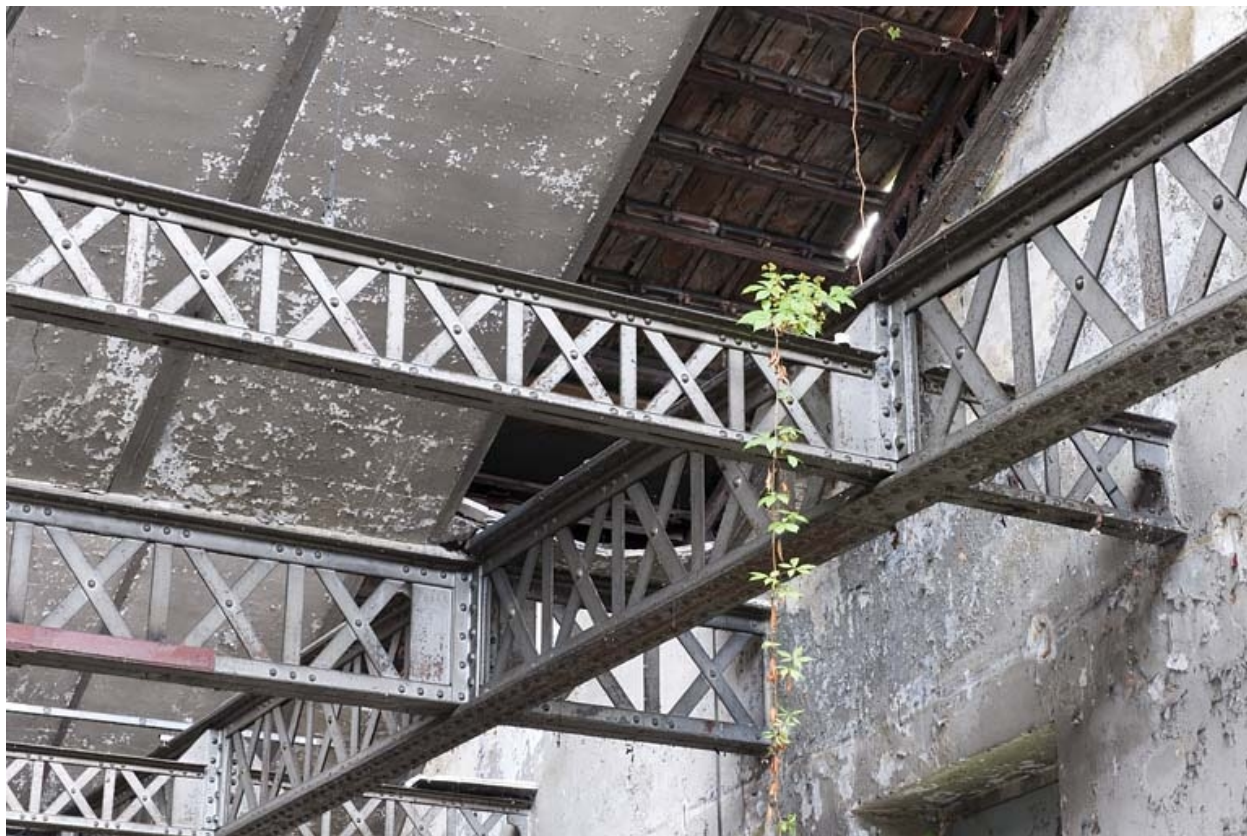
Poutrelles à treillis et mur pignon des sheds.
