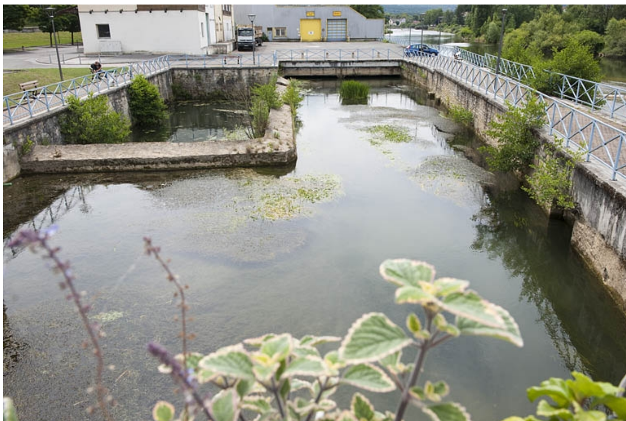
Bassin aménagé à l'emplacement du canal d'amenée.
