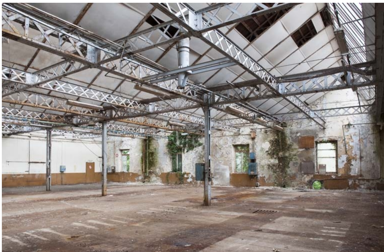
Atelier de fabrication. Vue depuis le nord-est.
