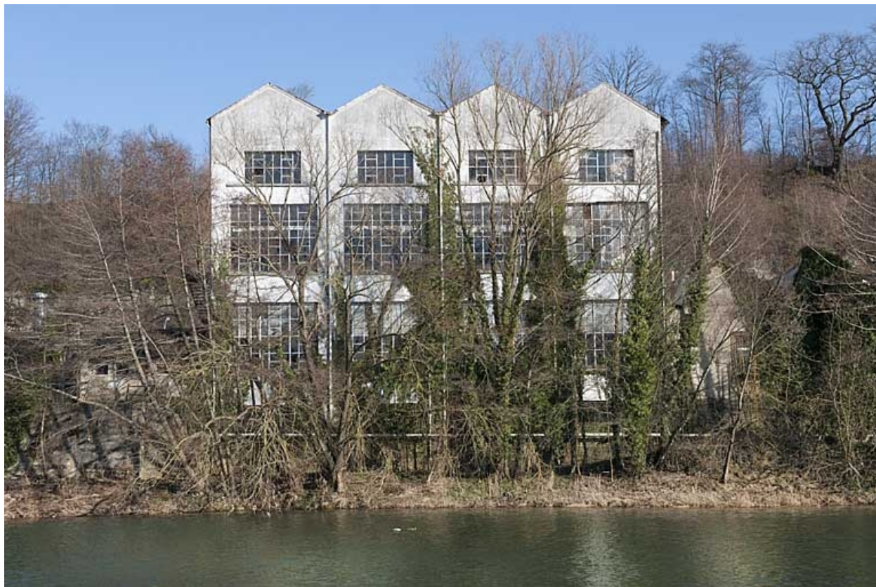
Façade ouest de l'atelier des presses.
