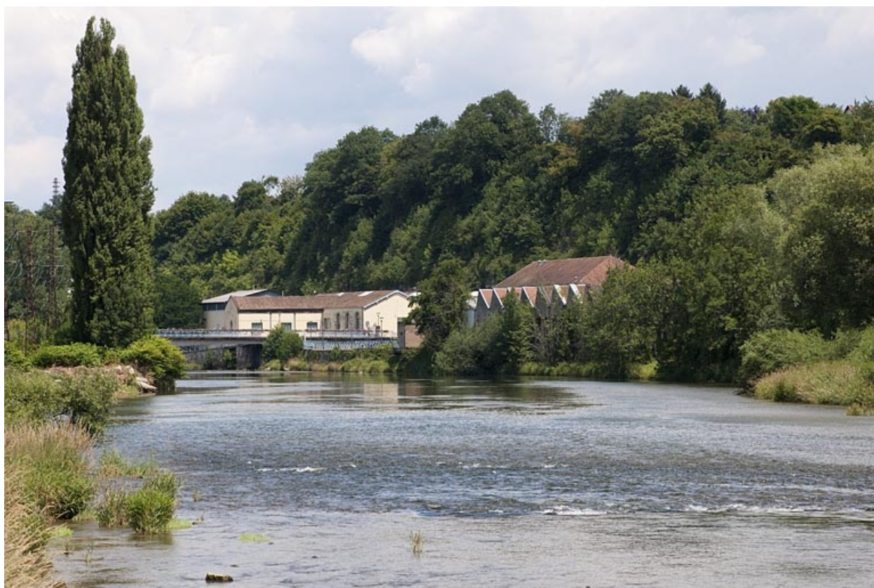
Vue depuis l'amont de la rive gauche.
