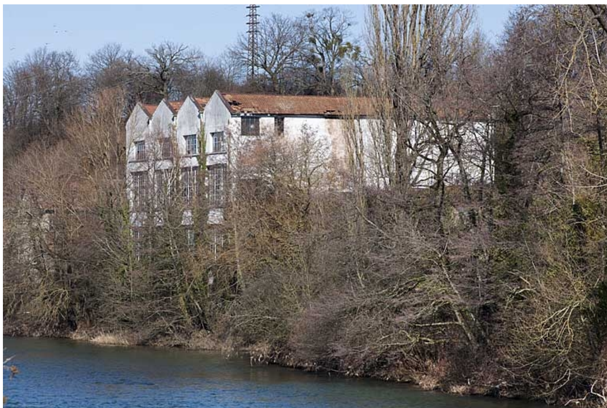
Atelier des presses depuis l'amont.
