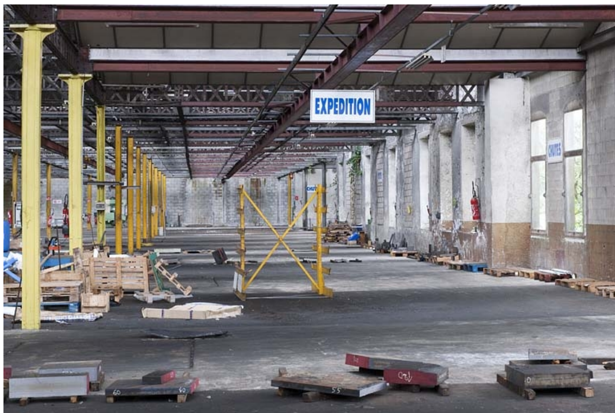
Travée d'un atelier de fabrication.
