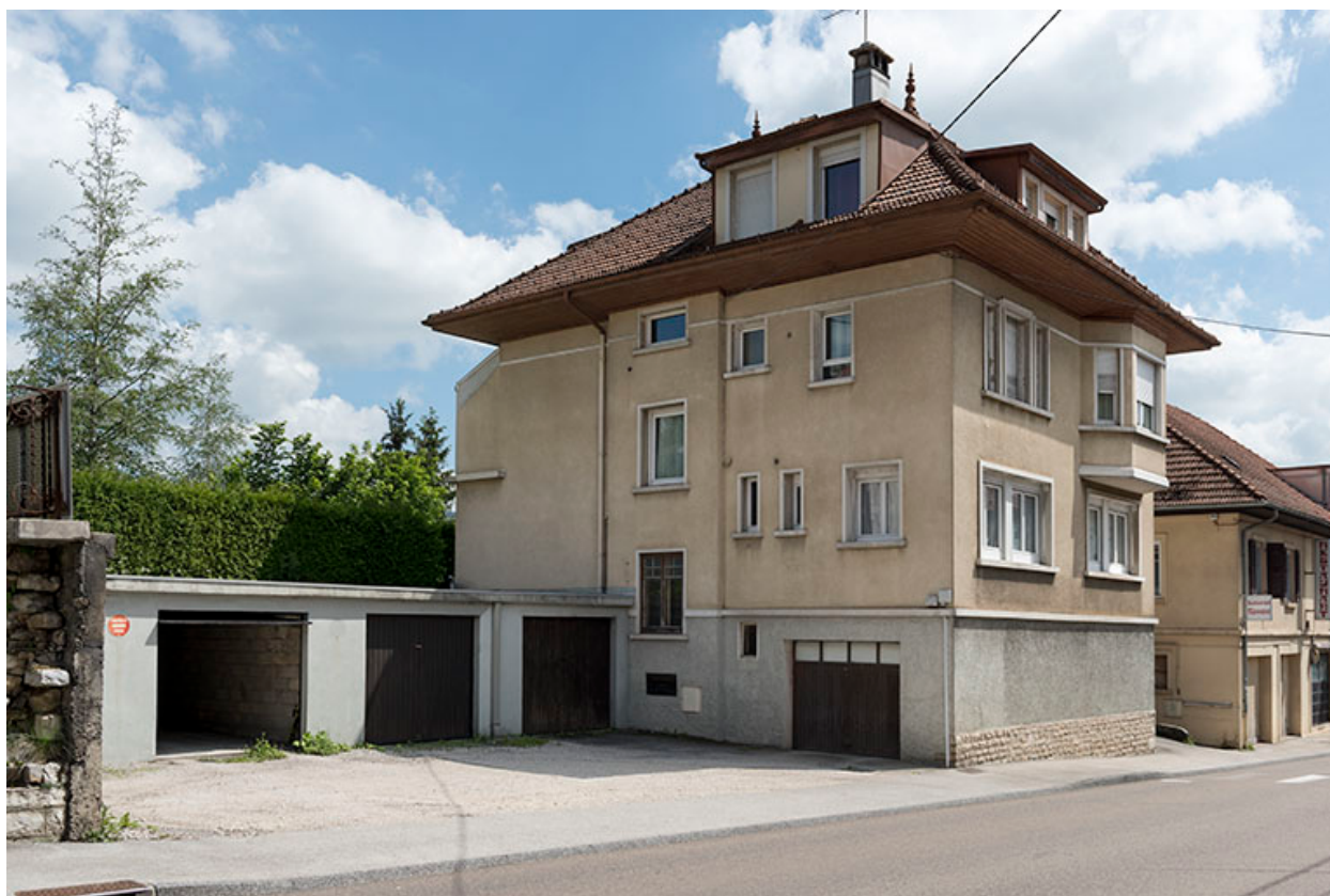
Façades antérieure et latérale gauche.
