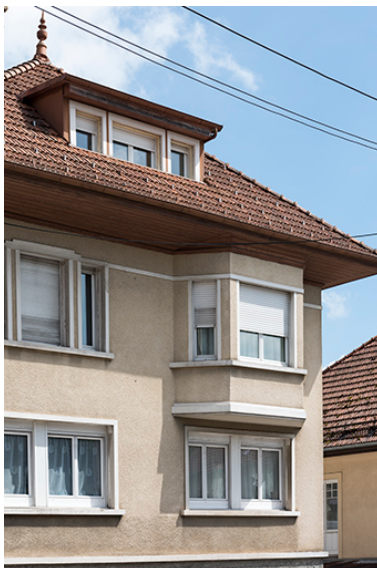
Façade antérieure : baies des étages et oriel.
