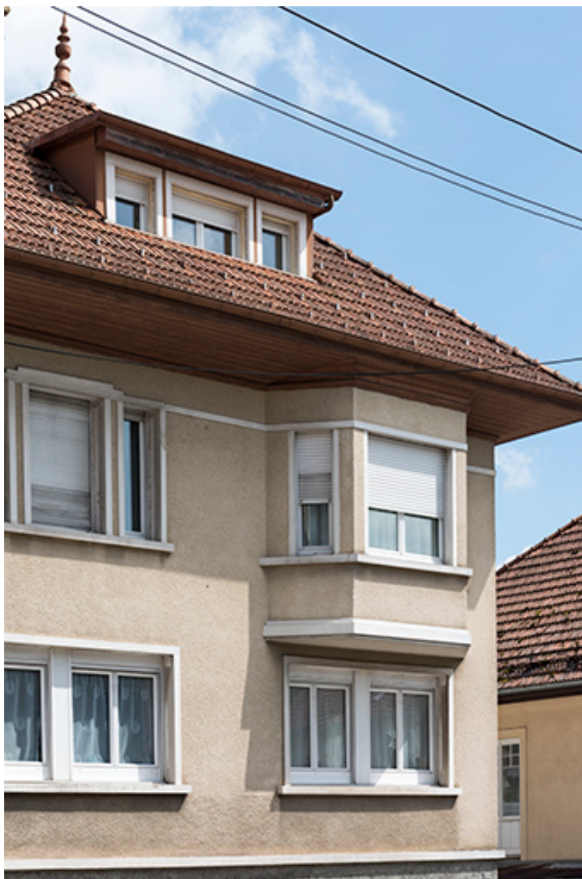
Façade antérieure : baies des étages et oriel.
