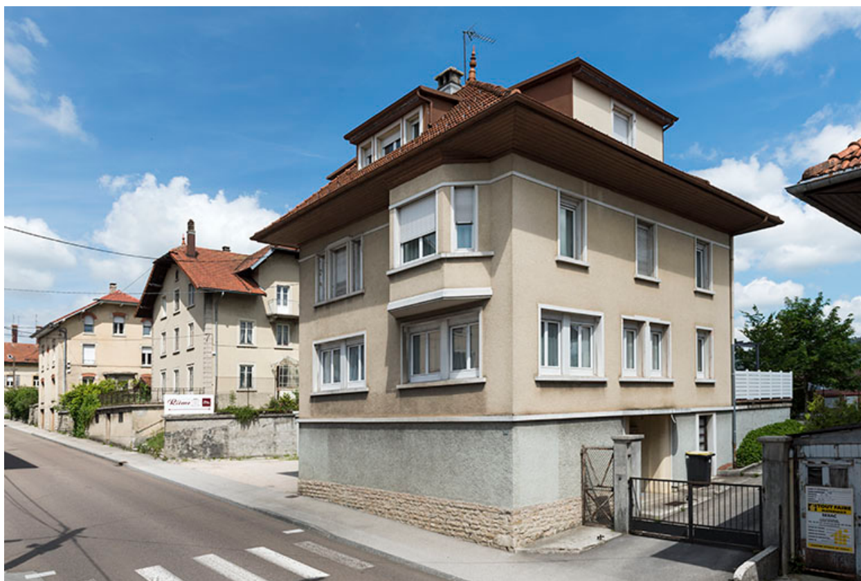
Vue d'ensemble dans la rue, depuis le sud-ouest.
