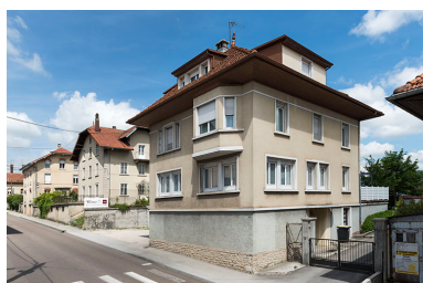
Vue d'ensemble dans la rue, depuis le sud-ouest. Phot. Sonia Dourlot IVR43_20182500957NUC4A
