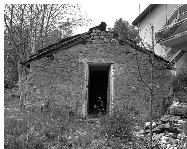
Façade antérieure de la resserre, " grenier fort ".
