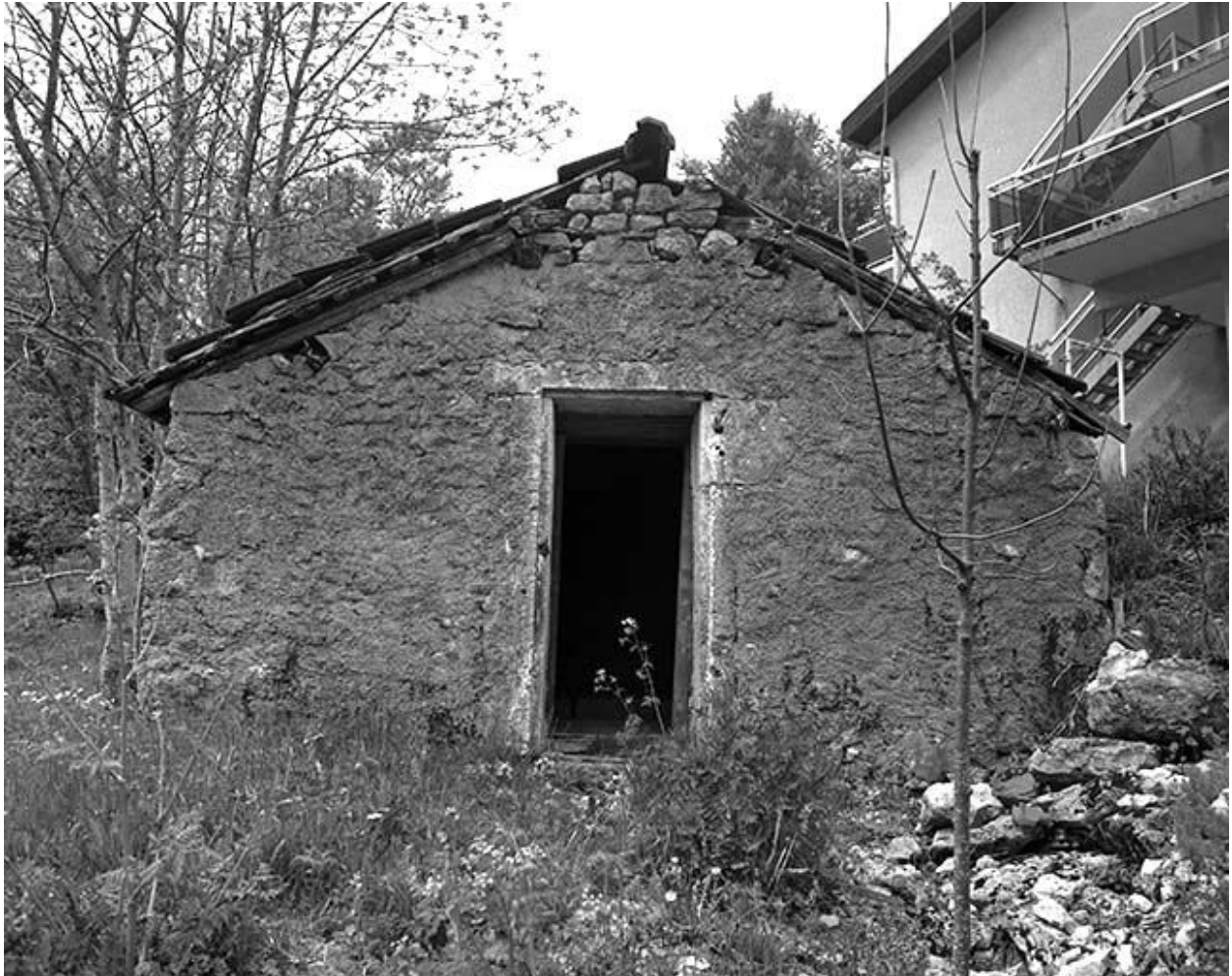
Façade antérieure de la resserre, " grenier fort ".
