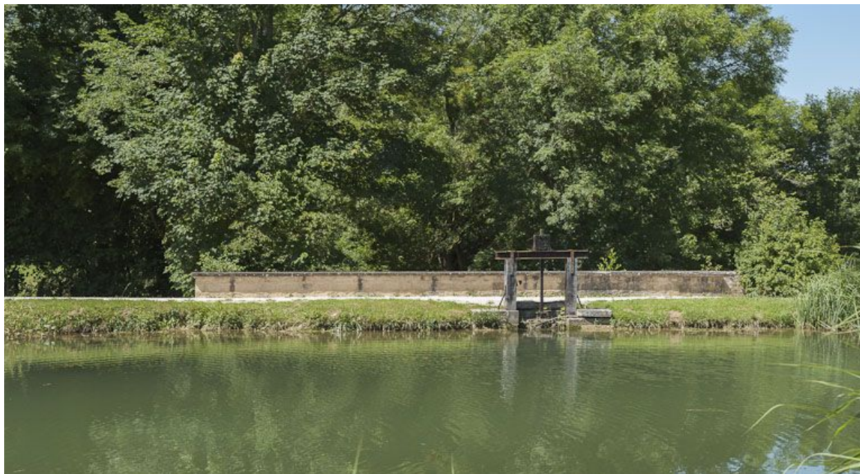
Déversoir rive gauche.
