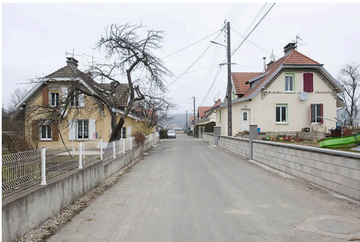
Vue d'ensemble depuis la rue.
