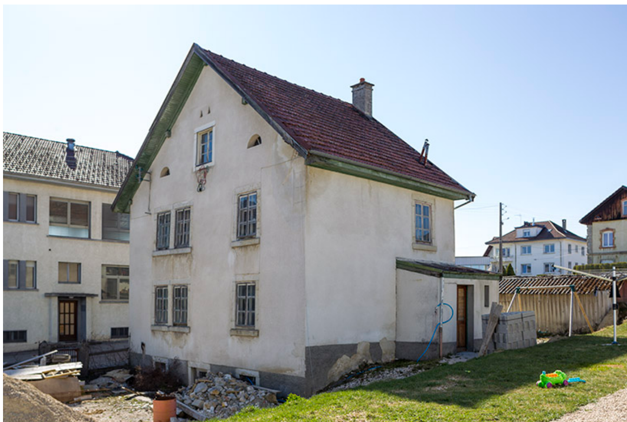
Façades postérieure et latérale droite.
