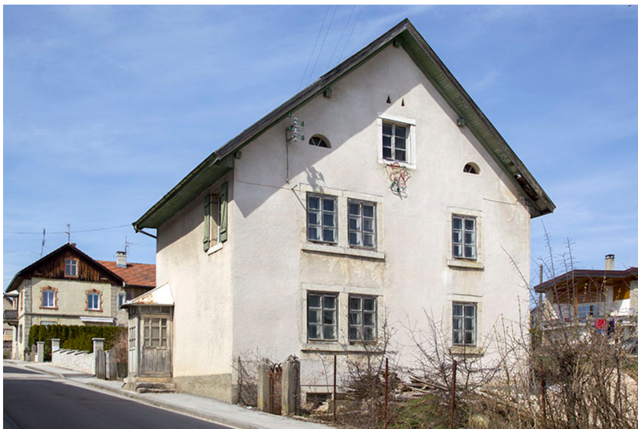
Façades antérieure et latérale droite.
