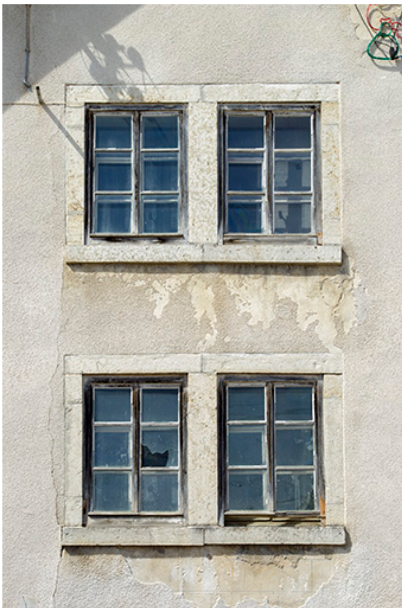
Façade latérale droite : fenêtres horlogères.
