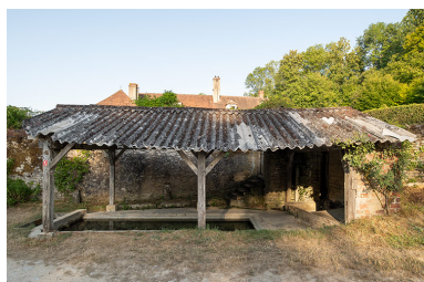
Le côté du lavoir. Phot. Nicolas Waltefaugle IVR26_20268900347NUC4A
