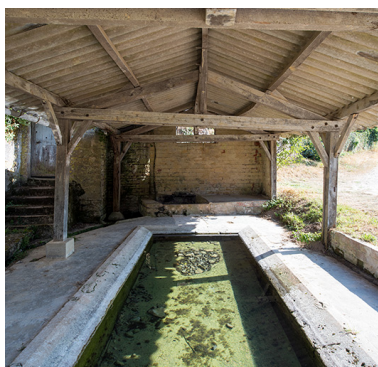
L'intérieur du lavoir vers le fond. Phot. Nicolas Waltefaugle IVR26_20268900318NUC4A
