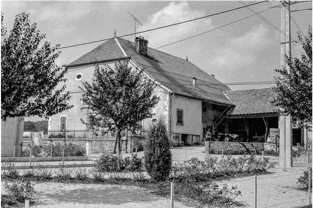
Façades sur cour.
