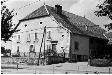
Vue de trois quarts droit. Phot. Gilbert Poinot IVR43_19752501243Z
