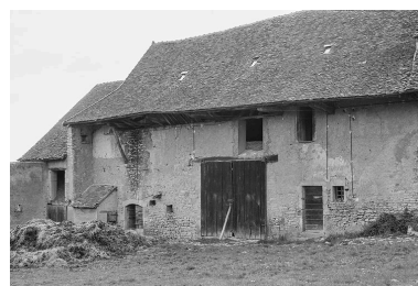
Grange, aujourd'hui détruite, à l'est du carrefour principal du hameau. Seul subsiste aujourd'hui, le bâtiment bas, à l'arrière-plan. Phot. Raymond Oursel IVR26_20207100083NUC2
