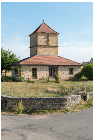
Habitation, surmontée d'un pigeonnier et érigée à la fin du XIXe siècle Phot. Pierre-Marie Barbe-Richaud IVR26_20197100174NUC4A
