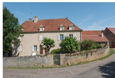
Ferme d'embouche. La maison est construite au milieu du XIXe siècle. Phot. Pierre-Marie Barbe-Richaud IVR26_20197100179NUC4A
