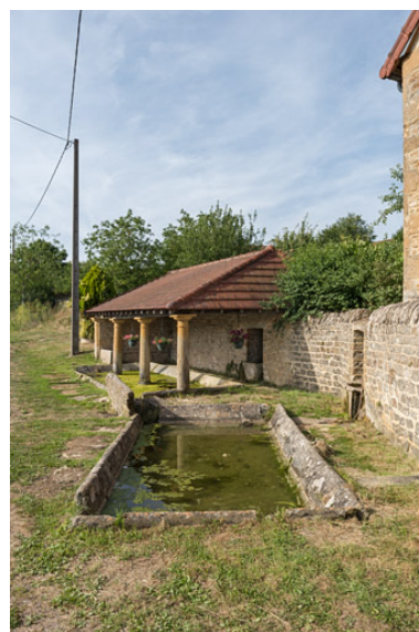
Lavoir à Tourny Phot. Pierre-Marie Barbe-Richaud IVR26_20197100210NUC4A
