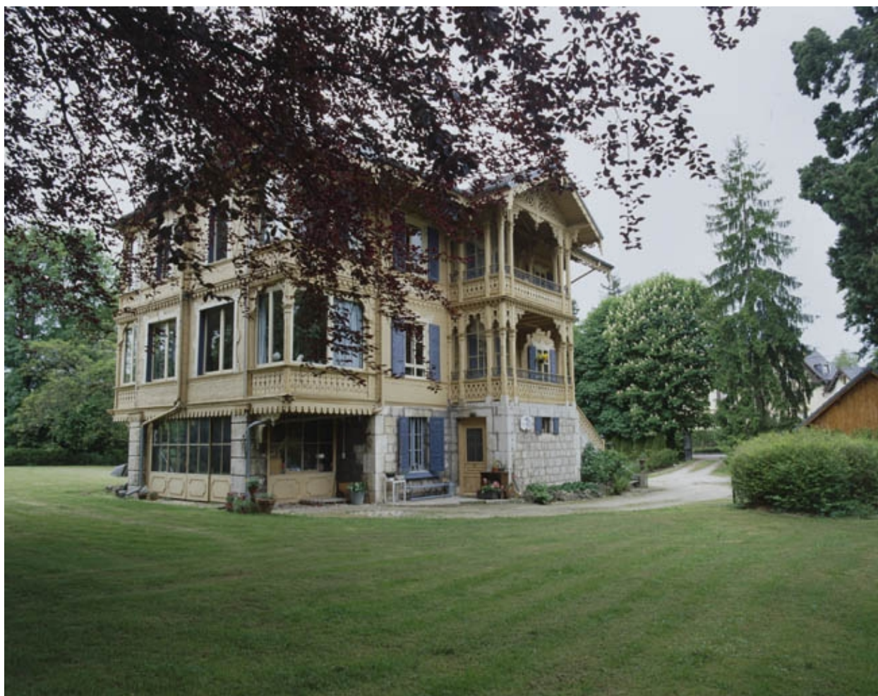
Chalet. Vue d'ensemble depuis le nord-est.
