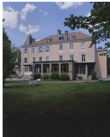
Façade postérieure. Phot. Yves Sancey IVR43_20029000310XA
