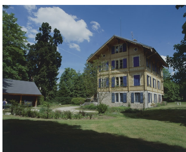
Chalet. Vue d'ensemble depuis le sud-ouest. Phot. Yves Sancey IVR43_20029000300XA
