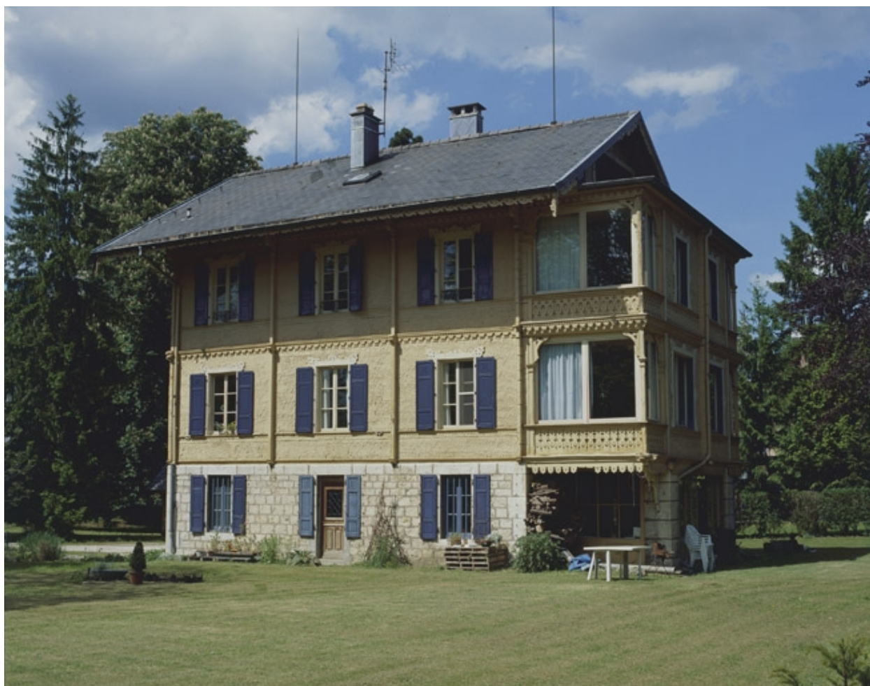
Chalet. Façade sud.
