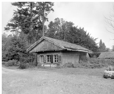
Cellier en 1981.SRI. Enquête régionale sur les bâtiments industriels (1979-1981). Phot. Yves Sancey IVR43_19819000014X
