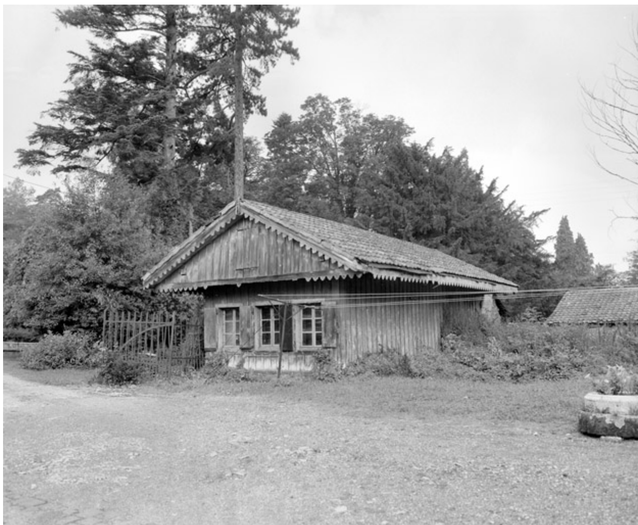
Cellier en 1981.SRI. Enquête régionale sur les bâtiments industriels (1979-1981).
