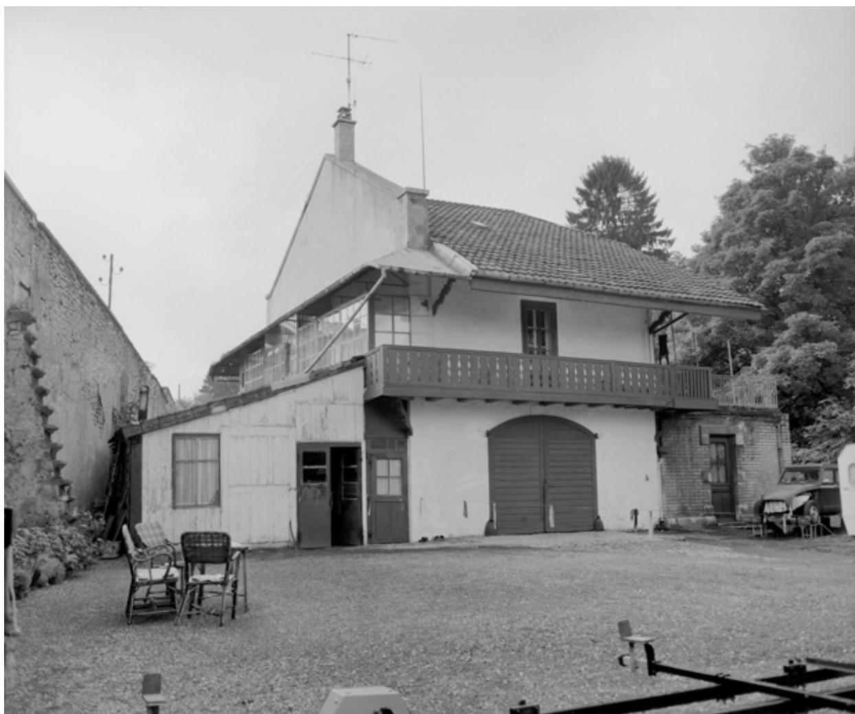
Logement et écurie en 1981.SRI. Enquête régionale sur les bâtiments industriels (1979-1981).
