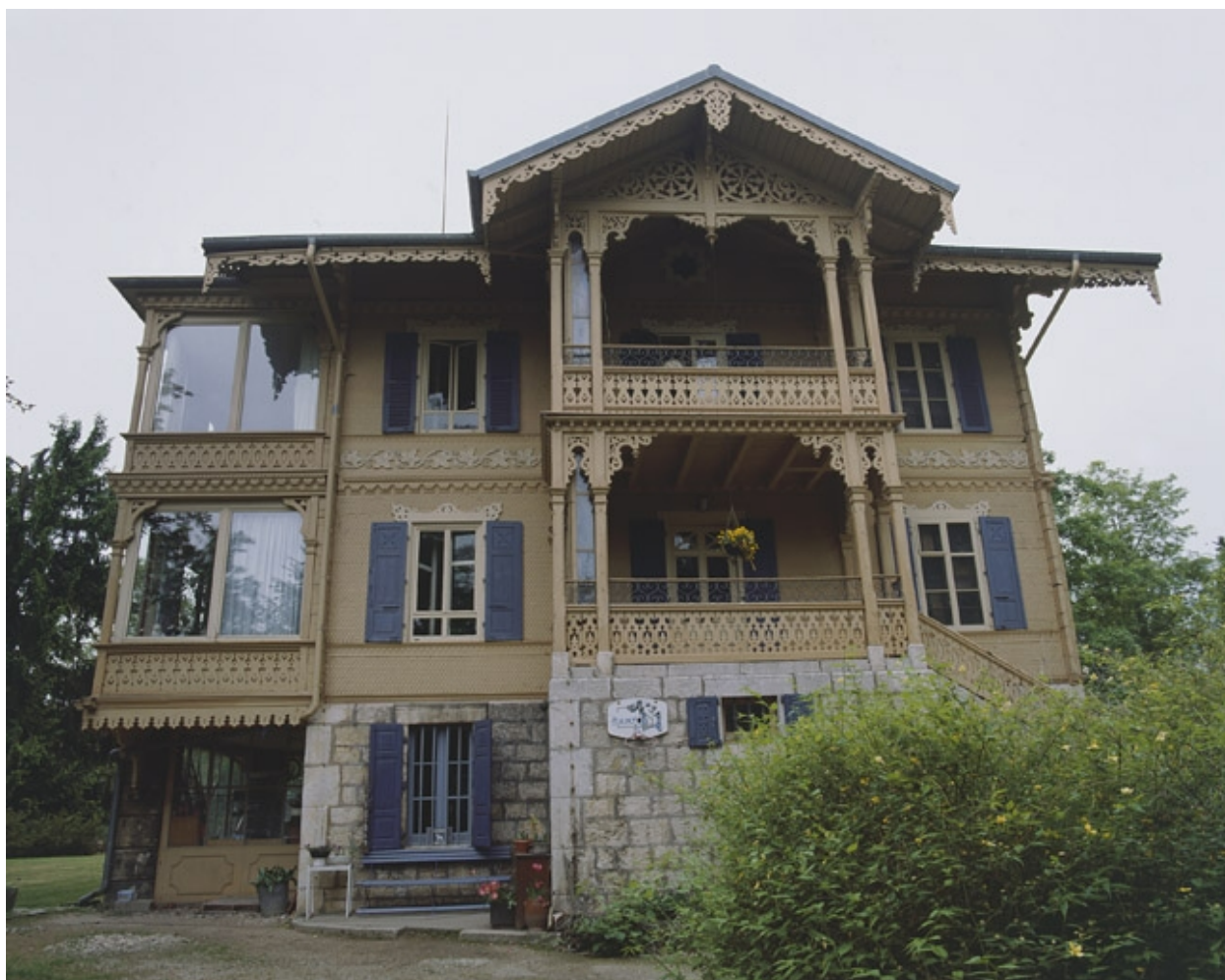
Chalet. Façade nord.
