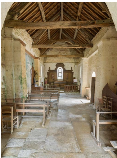
La nef, depuis l'entrée. Phot. Pierre-Marie Barbe-Richaud IVR26_20182100070NUC4A
