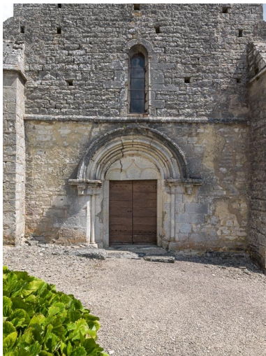
Portail et baie de la façade. Phot. Pierre-Marie Barbe-Richaud IVR26_20162100260NUC2A
