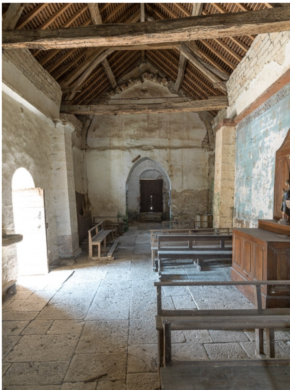
Vue d'ensemble depuis le chœur.
