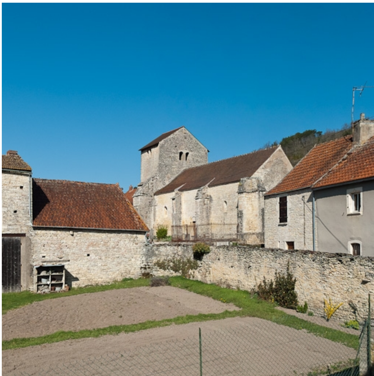
Eglise d'Auxey-le-Petit : vue d'ensemble côté chevet.
