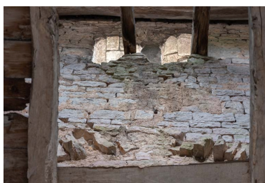
Baies géminées du clocher-porche. Phot. Pierre-Marie Barbe-Richaud IVR26_20182100097NUC4A
