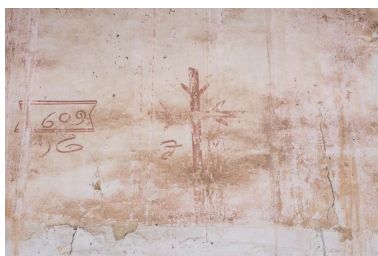
Peintures murales du mur occidental. Phot. Pierre-Marie Barbe-Richaud IVR26_20182100077NUC4A
