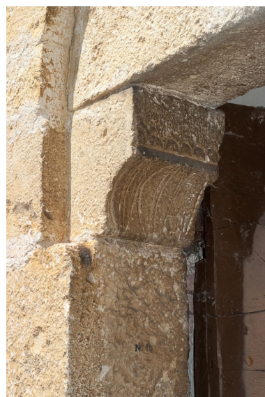
Porte latérale, détail d'un coussinet. Phot. Pierre-Marie Barbe-Richaud IVR26_20162100264NUC2A
