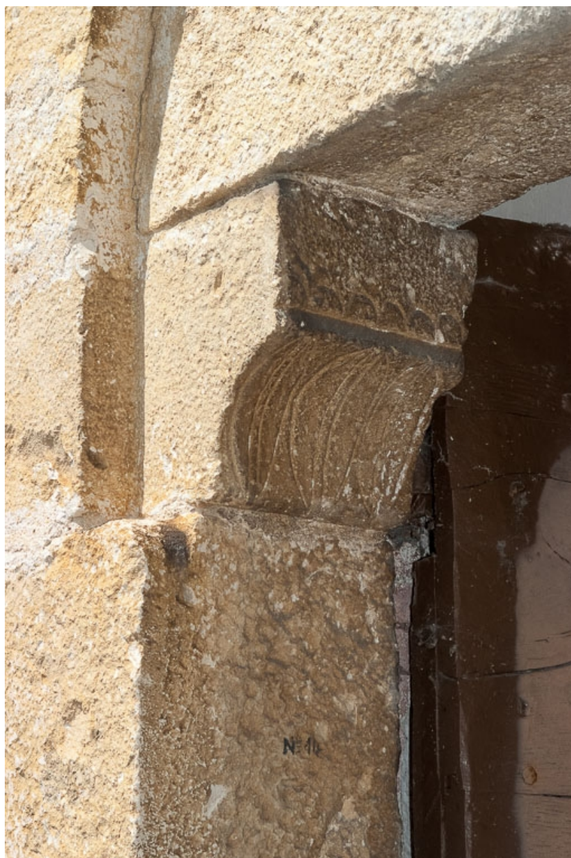
Porte latérale, détail d'un coussinet.
