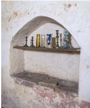
Lavabos liturgiques dans le chœur. Phot. Pierre-Marie Barbe-Richaud IVR26_20182100083NUC2A
