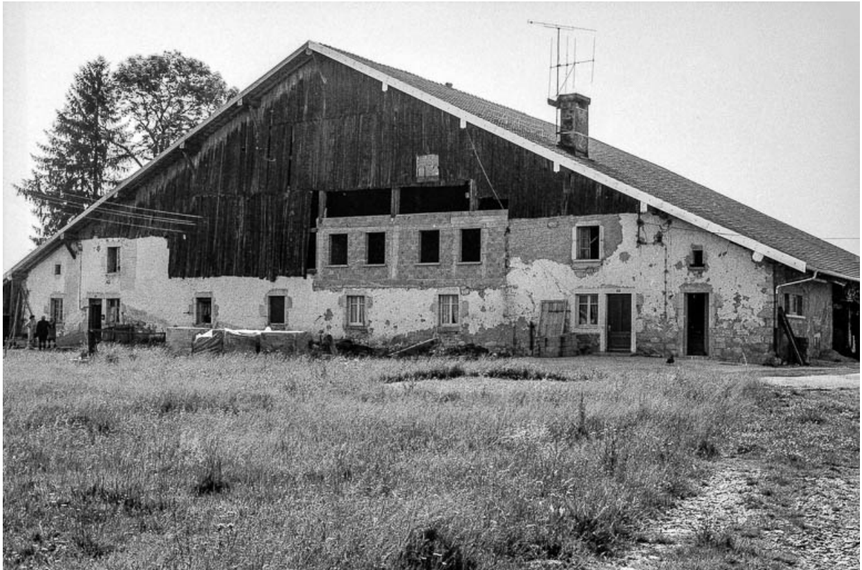
Ferme cadastrée 1938 E 266-267 : façade antérieure.
