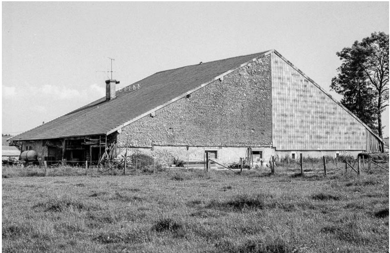
Ferme cadastrée 1938 E 266-267 : façade postérieure.
