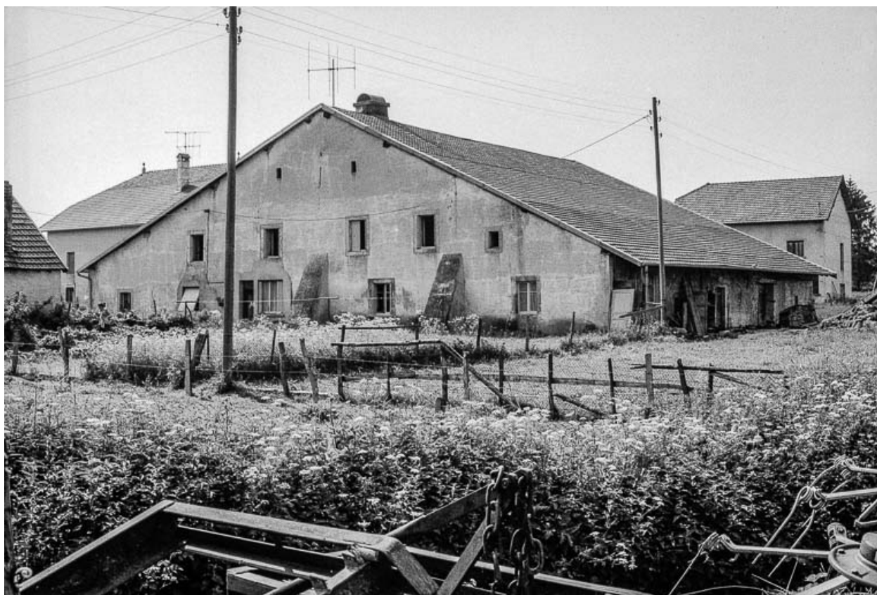
Ferme datée de 1750, cadastrée 1938 F 56 : façade antérieure.
