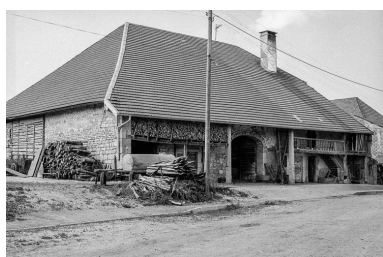
Ferme, cadastrée 1938 F 62 : façade antérieure. Phot. Gilbert Poinot IVR43_19752500770Z
