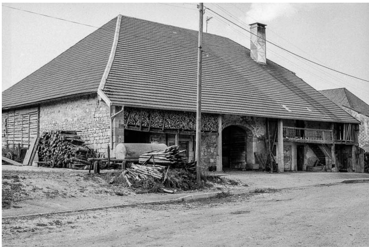
Ferme, cadastrée 1938 F 62 : façade antérieure.
