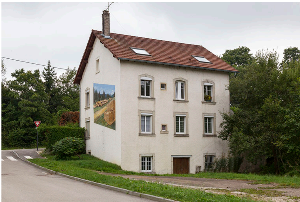
Logement patronal : façades postérieure et latérale droite.
