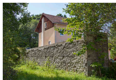
Vestige du mur de la scierie. Phot. Sonia Dourlot IVR43_20152500921NUC2A
