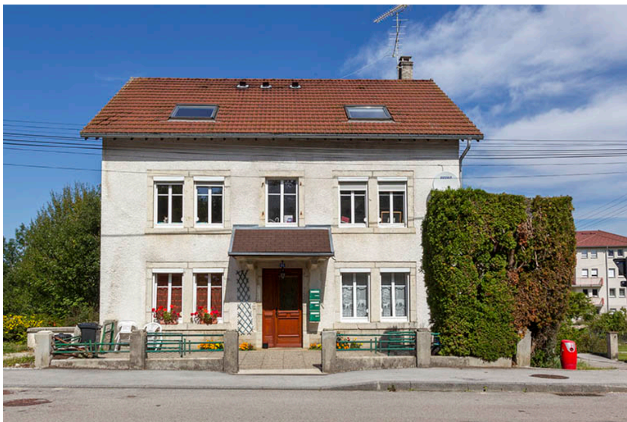
Logement patronal : façade antérieure.
