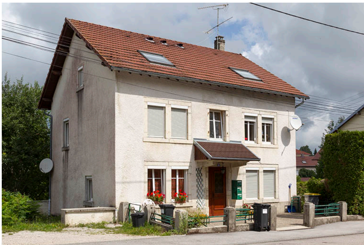
Logement patronal : façades antérieure et latérale gauche.
