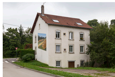
Logement patronal : façades postérieure et latérale droite. Phot. Yves Sancey IVR43_20122502318NUC2A
