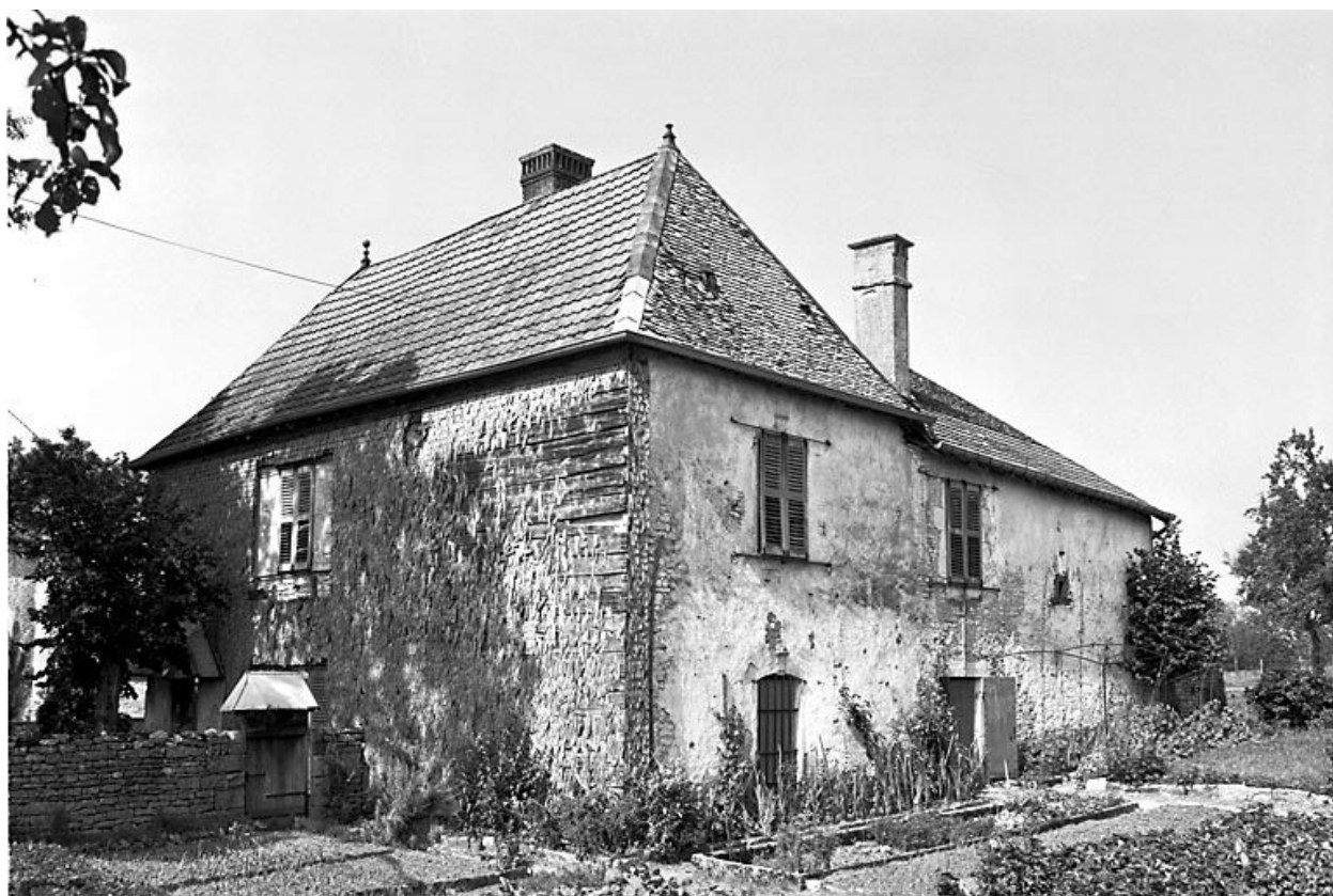
Façade antérieure et face latérale droite.
