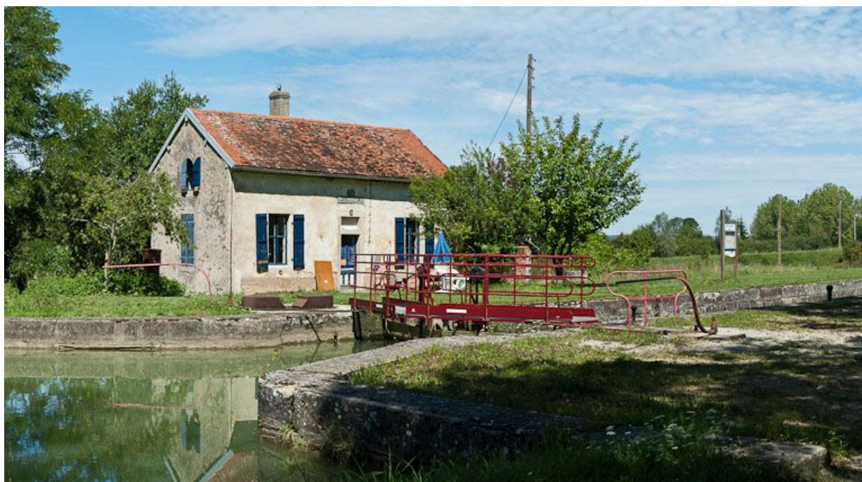
Vue d'ensemble du site d'écluse.
