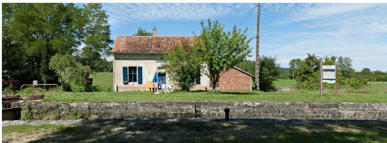
Vue de face de la maison éclusière.
