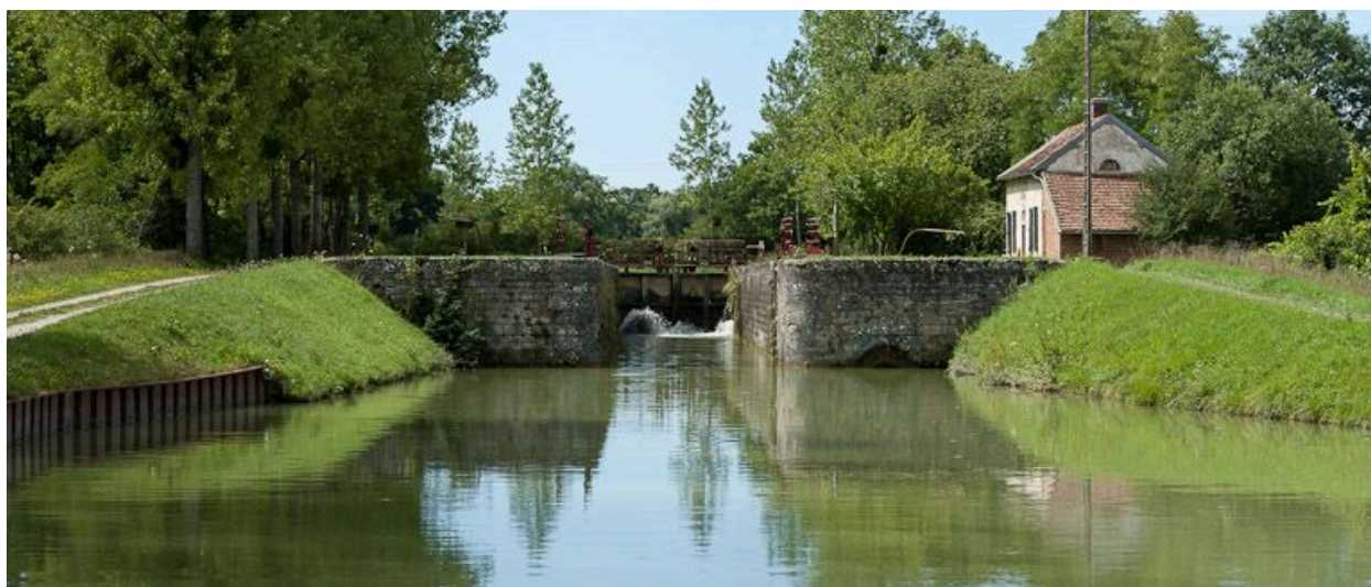
Vue du site d'écluse depuis l'aval.
