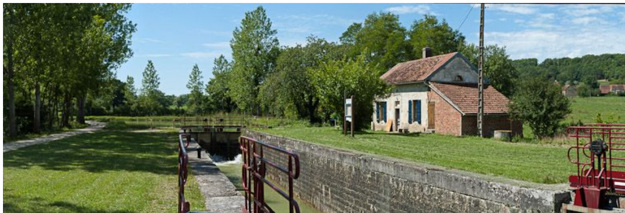
Vue d'ensemble du site d'écluse.
