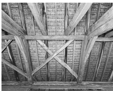
Deuxième niveau des combles du corps de bâtiment principal. Phot. Jérôme Mongreville IVR43_19872500953X
