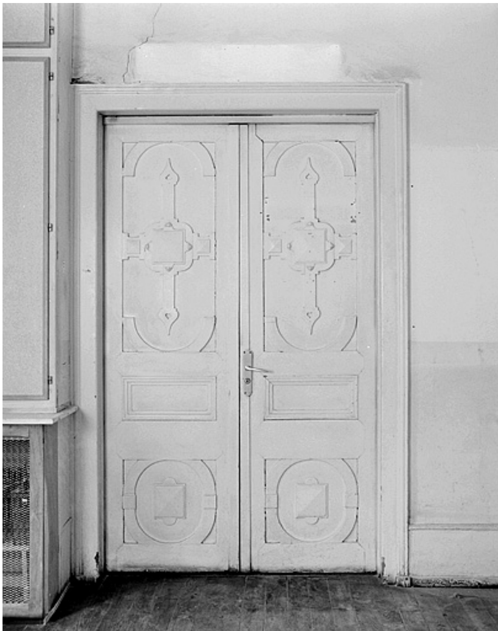
Aile est, vestibule du premier étage, porte à droite en sortant de l'escalier.
