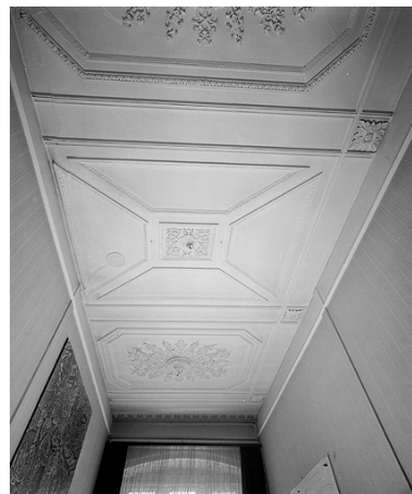
Plafond en plâtre. Phot. Jérôme Mongreville IVR43_19872501216V
