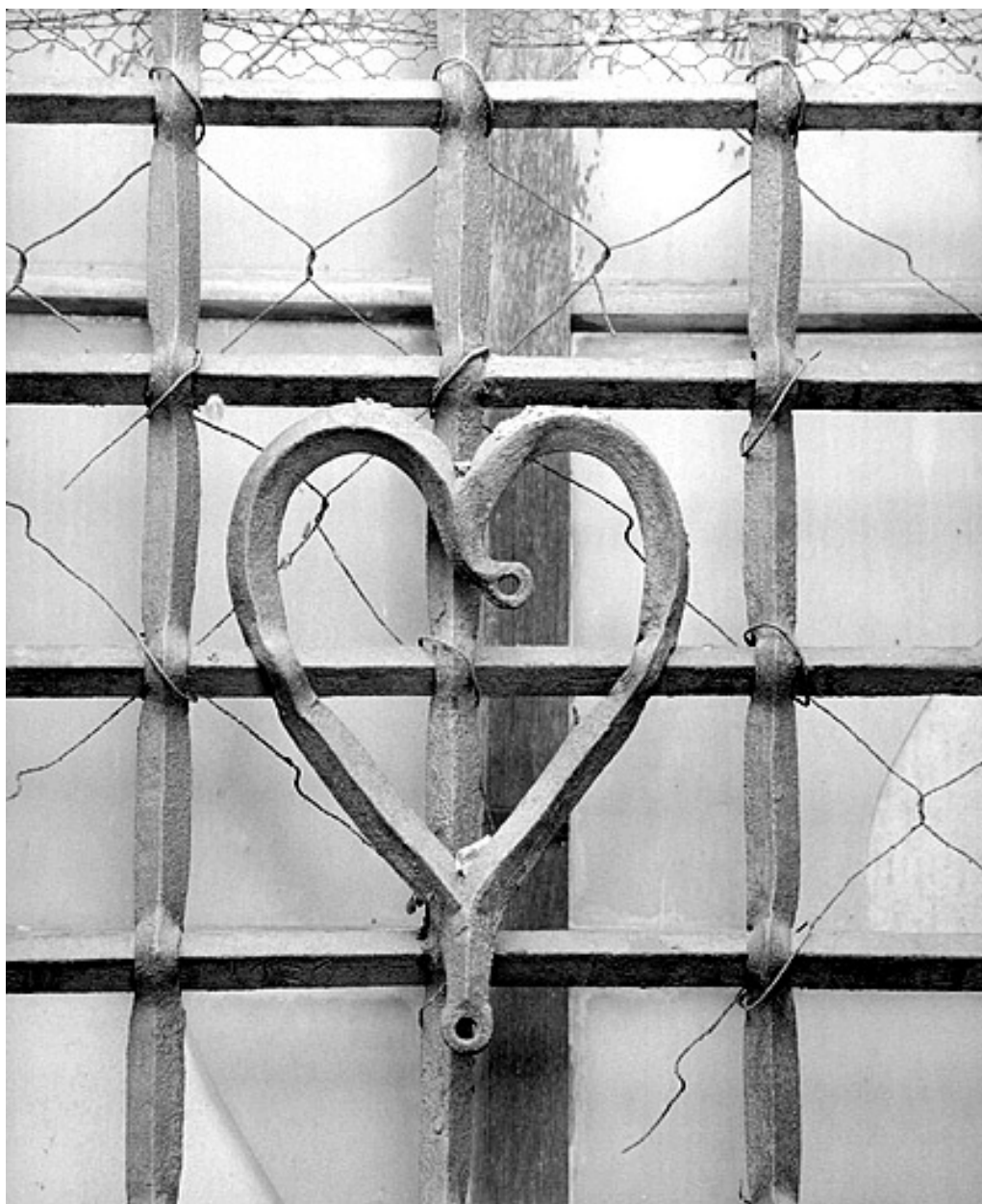
Détail de la grille de droite de l'ancien grenier à blé.
