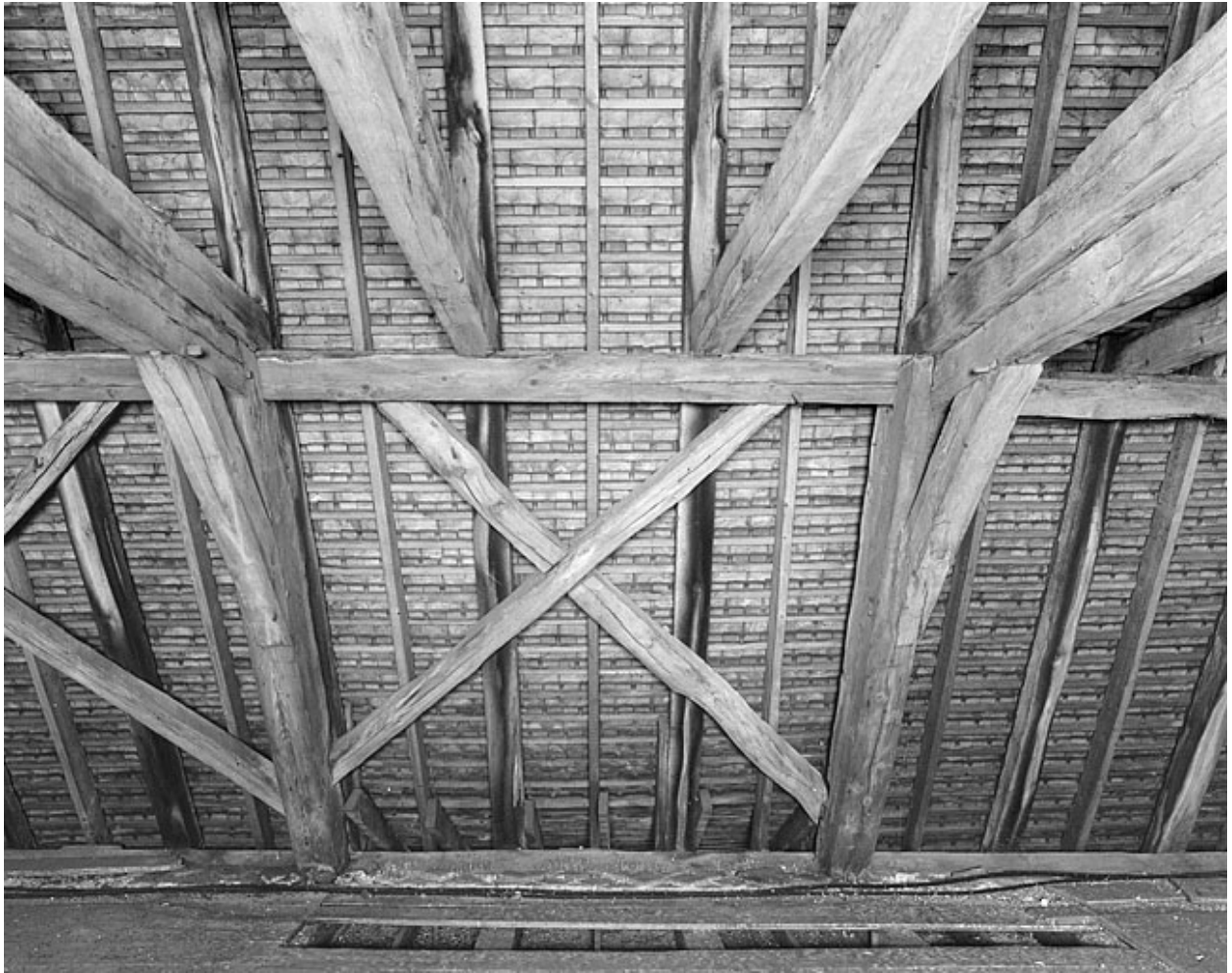
Deuxième niveau des combles du corps de bâtiment principal.
