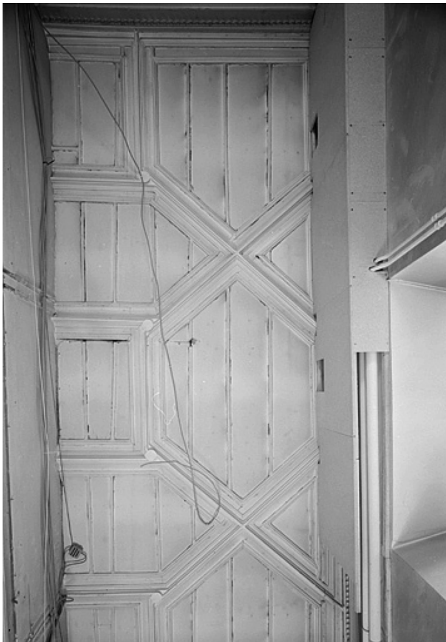
Plafond "à motifs complexes" [au premier étage du corps de bâtiment principal].
