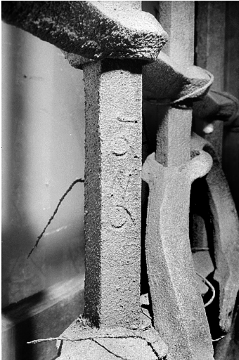
Détail de la grille de droite de l'ancien grenier à blé.
