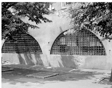
Grilles de l'ancien grenier à blé. Phot. Jérôme Mongreville IVR43_19882500176X
