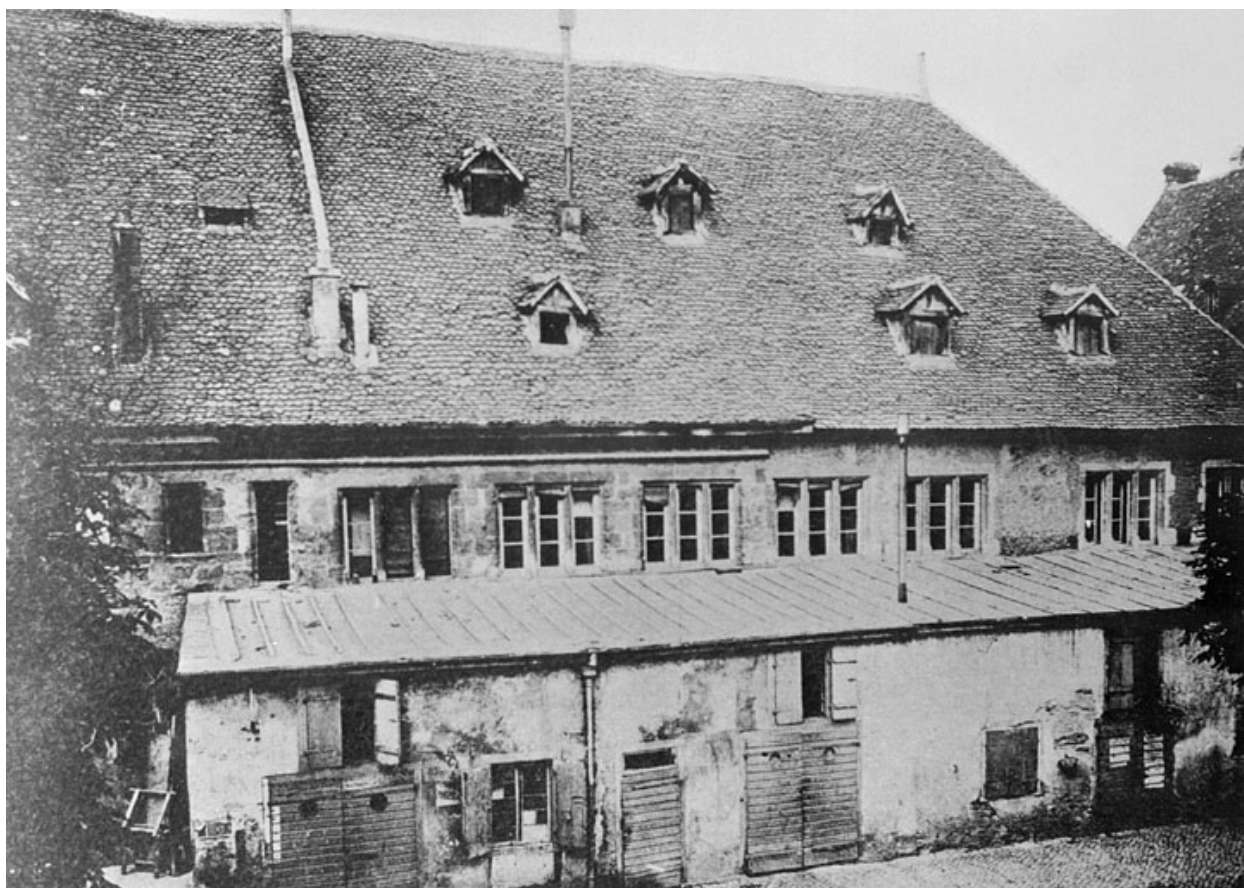
Aile est, façade sur la place Dorian, avant 1905.
