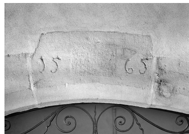
Date sur la porte d'entrée de l'ancienne douane à l'intérieur de l'aile est. Phot. Jérôme Mongreville IVR43_19882500180X
