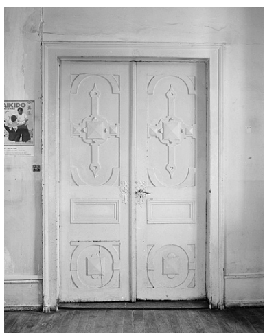
Aile est, vestibule du premier étage, porte à gauche en sortant de l'escalier.
