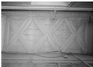
Plafond "à losanges" [au premier étage du corps de bâtiment principal]. Phot. Jérôme Mongreville IVR43_19872501215V
