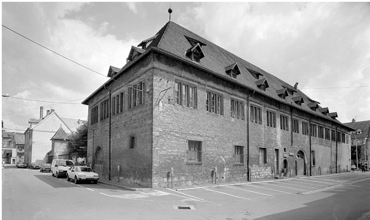
Vue extérieure de l'aile ouest.
