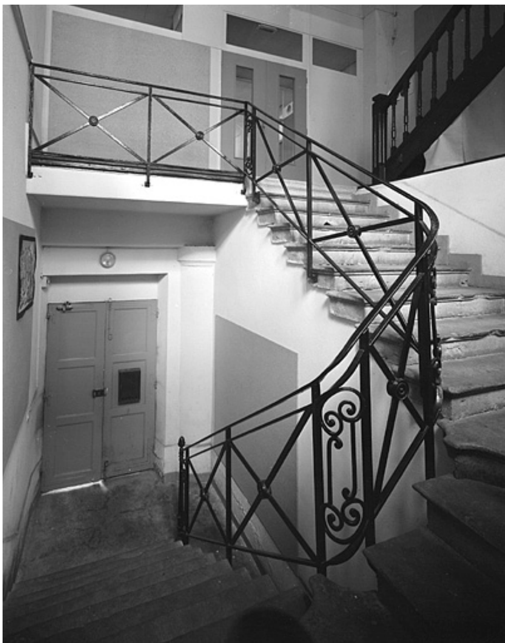
Escalier de l'aile ouest.
