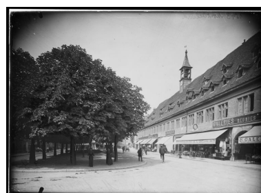
Vue de la place Denfert-Rochereau et de la halle [1re moitié 20e siècle]. Autr. Jules Manias IVR43_20062500798PY
