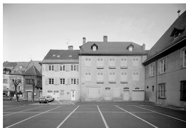
Maisons fermant le côté nord de la cour (18e siècle). Phot. Jérôme Mongreville IVR43_19882500030V
