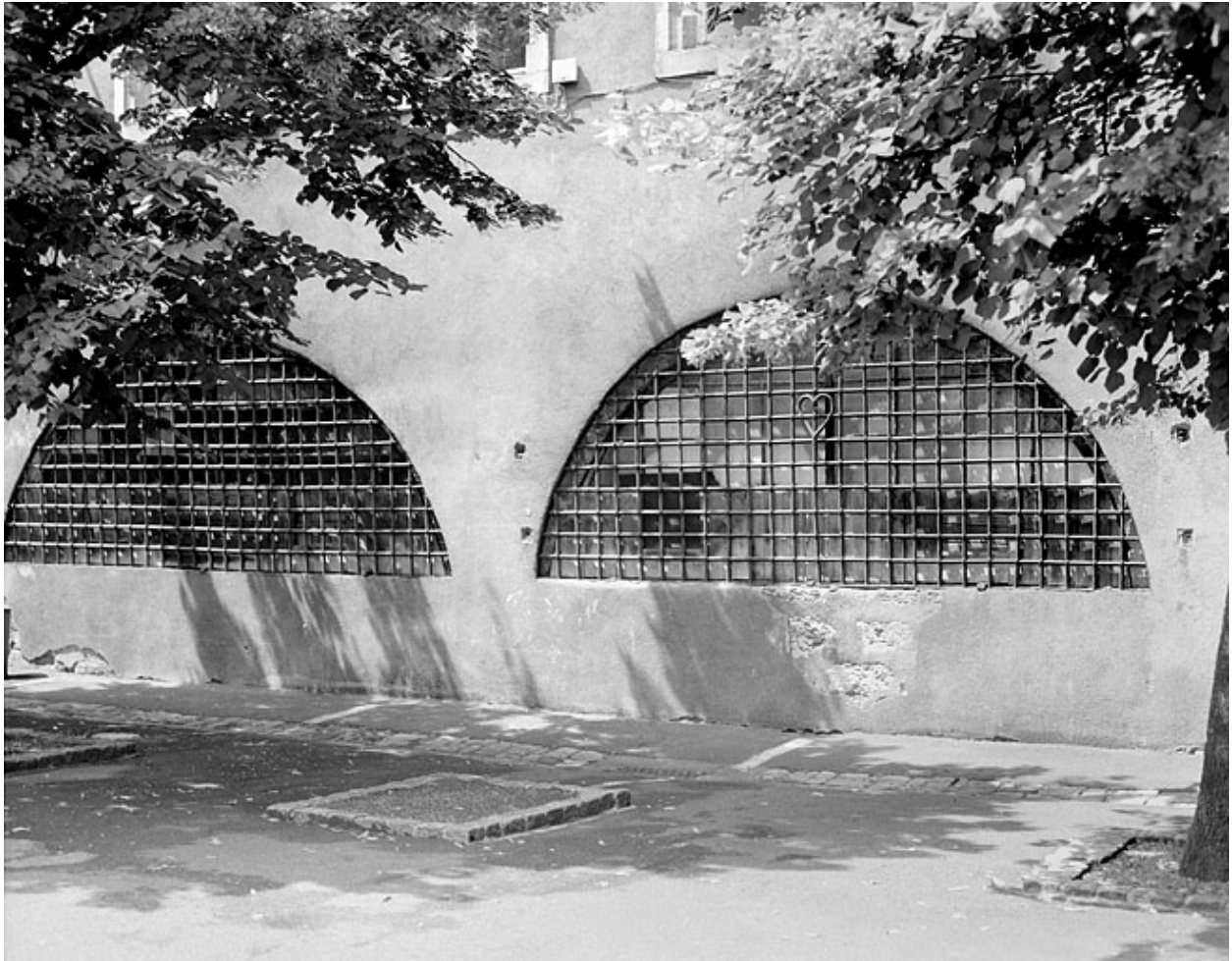
Grilles de l'ancien grenier à blé.
