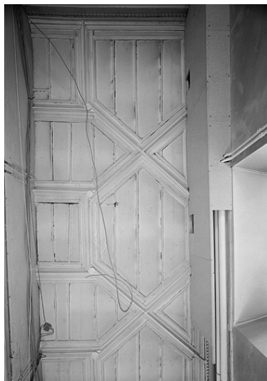
Plafond "à motifs complexes" [au premier étage du corps de bâtiment principal]. Phot. Jérôme Mongreville IVR43_19872501214V
