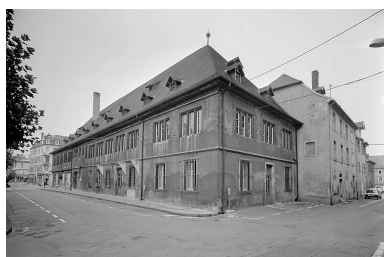
Vue extérieure de l'aile est. Phot. Jérôme Mongreville IVR43_19872501101V
