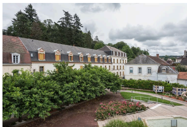
Situation de la villa (à droite) dans le quartier thermal. Phot. Pierre-Marie Barbe-Richaud IVR26_20217100210NUC4A
