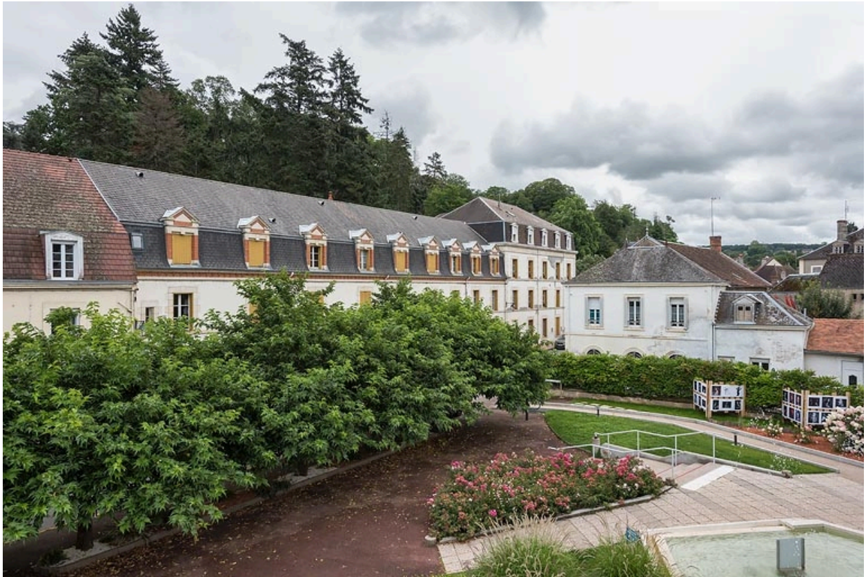
Situation de la villa (à droite) dans le quartier thermal.
