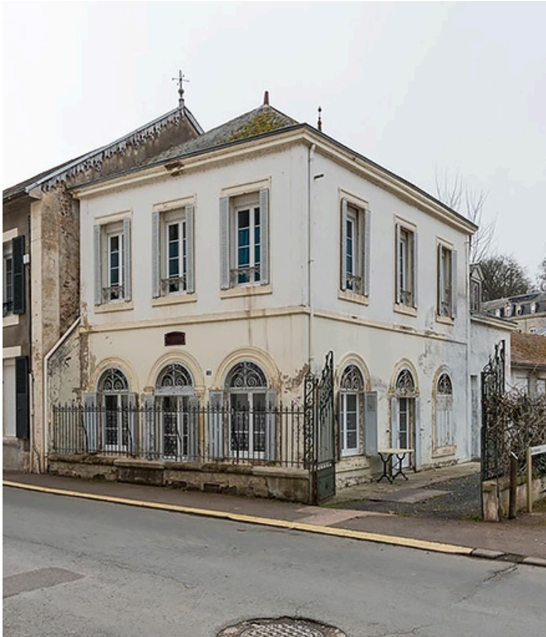
Façades sur l'avenue de la Libération.
