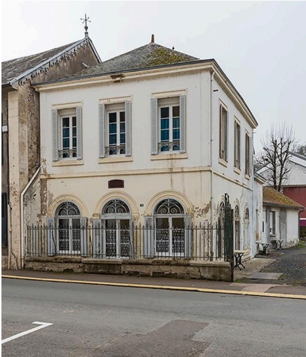
Façades sur l'avenue de la Libération.
