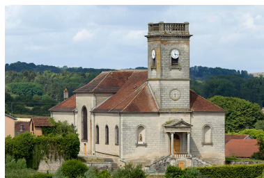
Vue d'ensemble. Phot. Sonia Dourlot IVR43_20157000523NUC2A
