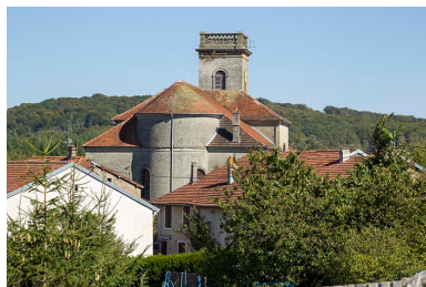
Vue sur le chevet. Phot. Sonia Dourlot IVR43_20157000532NUC2A
