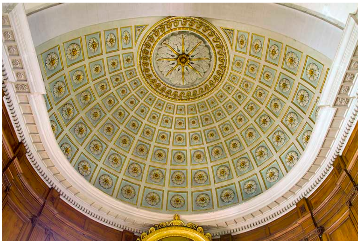
Voûte à caissons, chœur de l'église.
