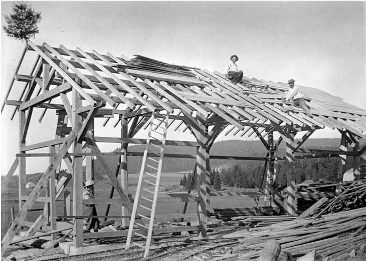
Construction du bâtiment de la parqueteuse, 1904.
