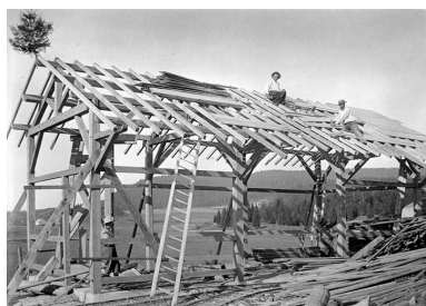
Construction du bâtiment de la parqueteuse, 1904. Phot. Jérôme Mongreville, Phot. Luc Paget IVR43_19913900151X
