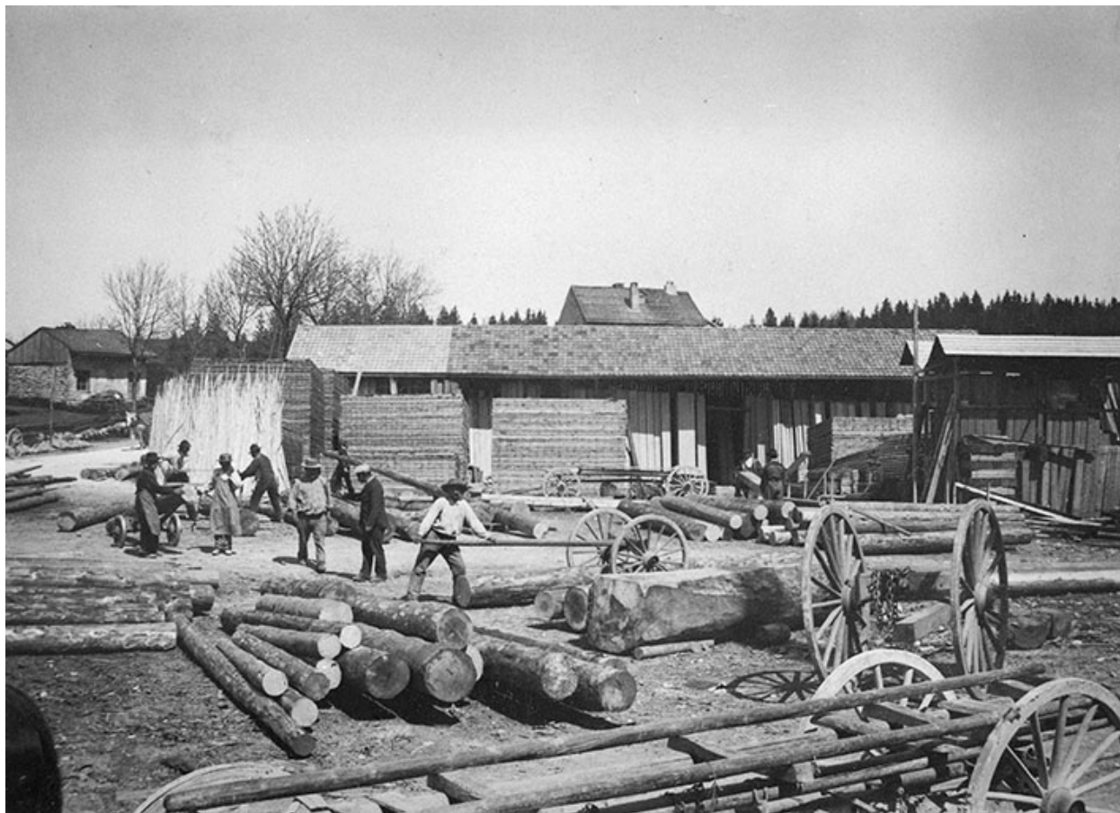
St Laurent. La scierie (chantier devant l'usine), 1898.
