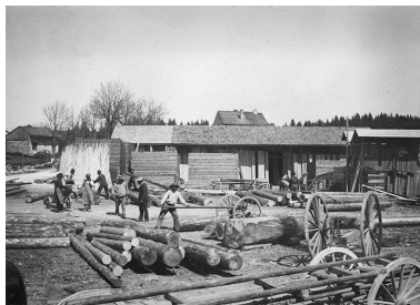
St Laurent. La scierie (chantier devant l'usine), 1898. Phot. Jérôme Mongreville, Phot. Luc Paget IVR43_19913900149X
