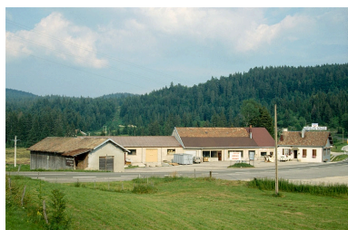
Vue d'ensemble depuis l'ouest. Phot. Laurent Poupard IVR43_19913901226ZA
