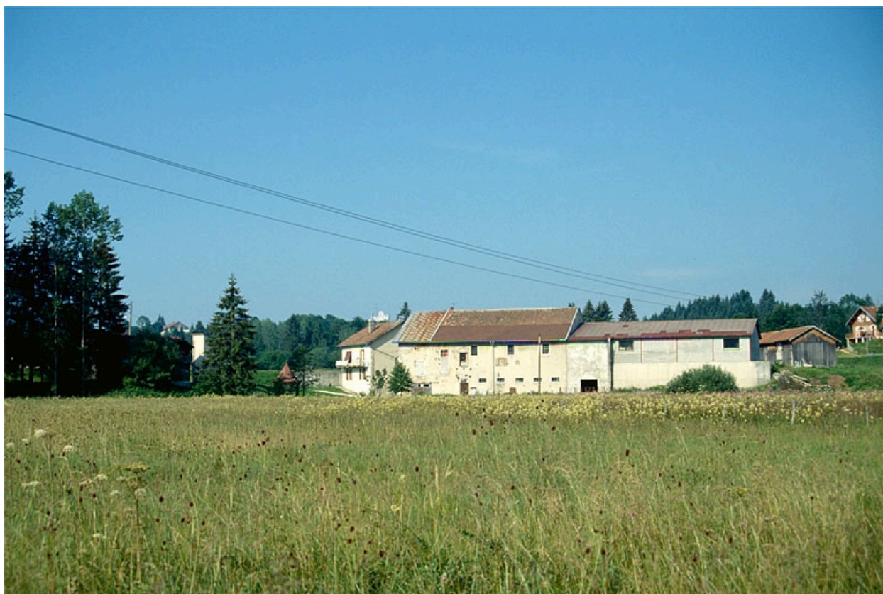
Ateliers de fabrication vus de l'est.
