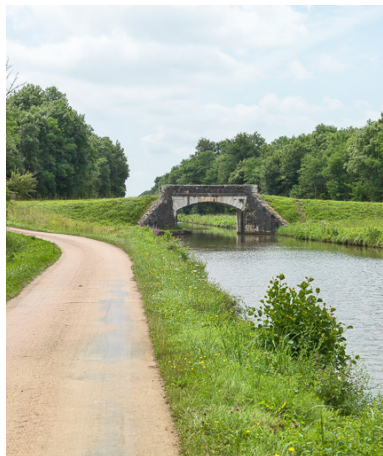
Vue générale du pont. Phot. Pierre-Marie Barbe-Richaud IVR26_20175800127NUC2A
