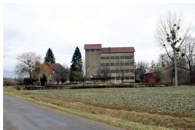
Vue d'ensemble depuis la route.
