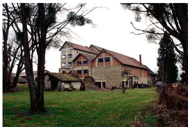
Pignons sud-est. De gauche à droite : ateliers de fabrication du blé, des céréales secondaires et magasin industriel.
