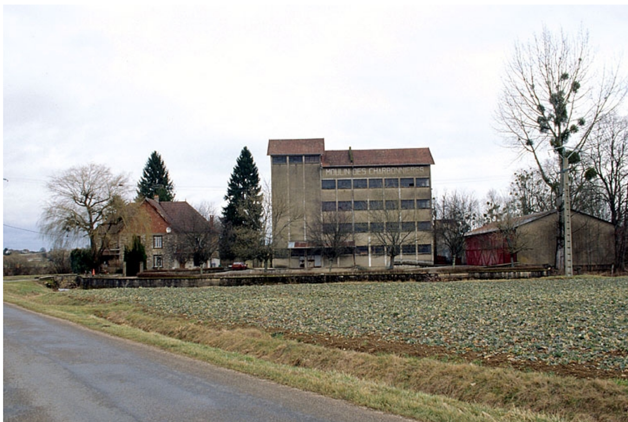
Vue d'ensemble depuis la route.
