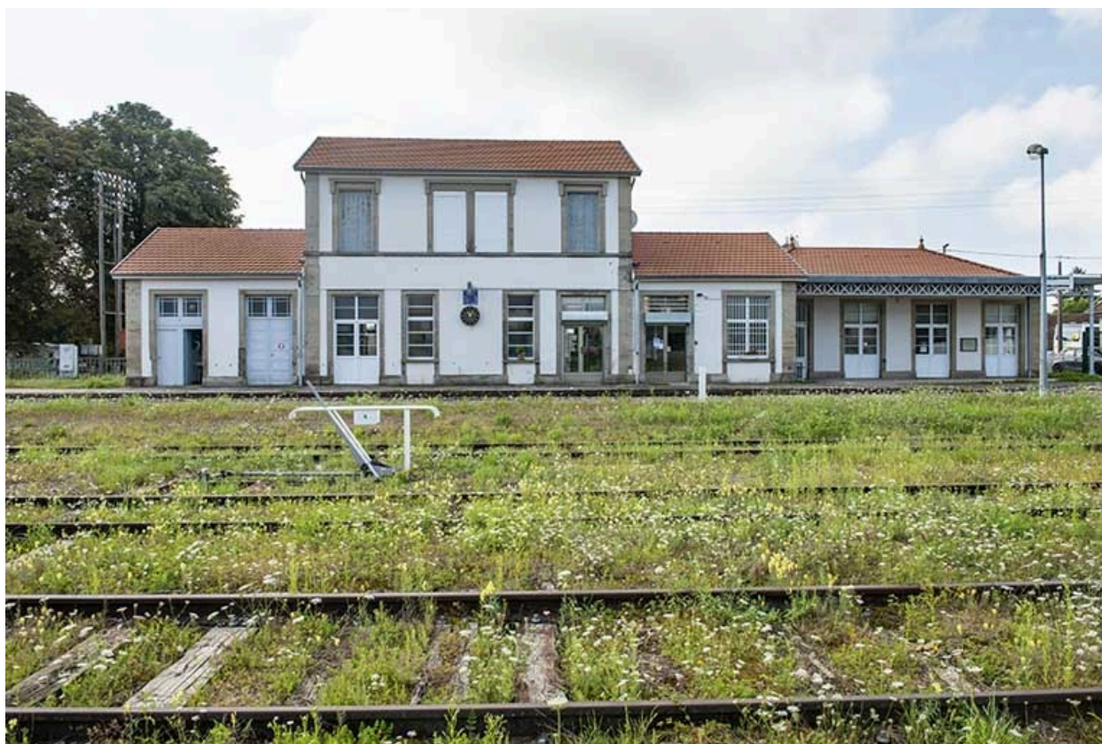
La gare, vue éloignée depuis les voies.
