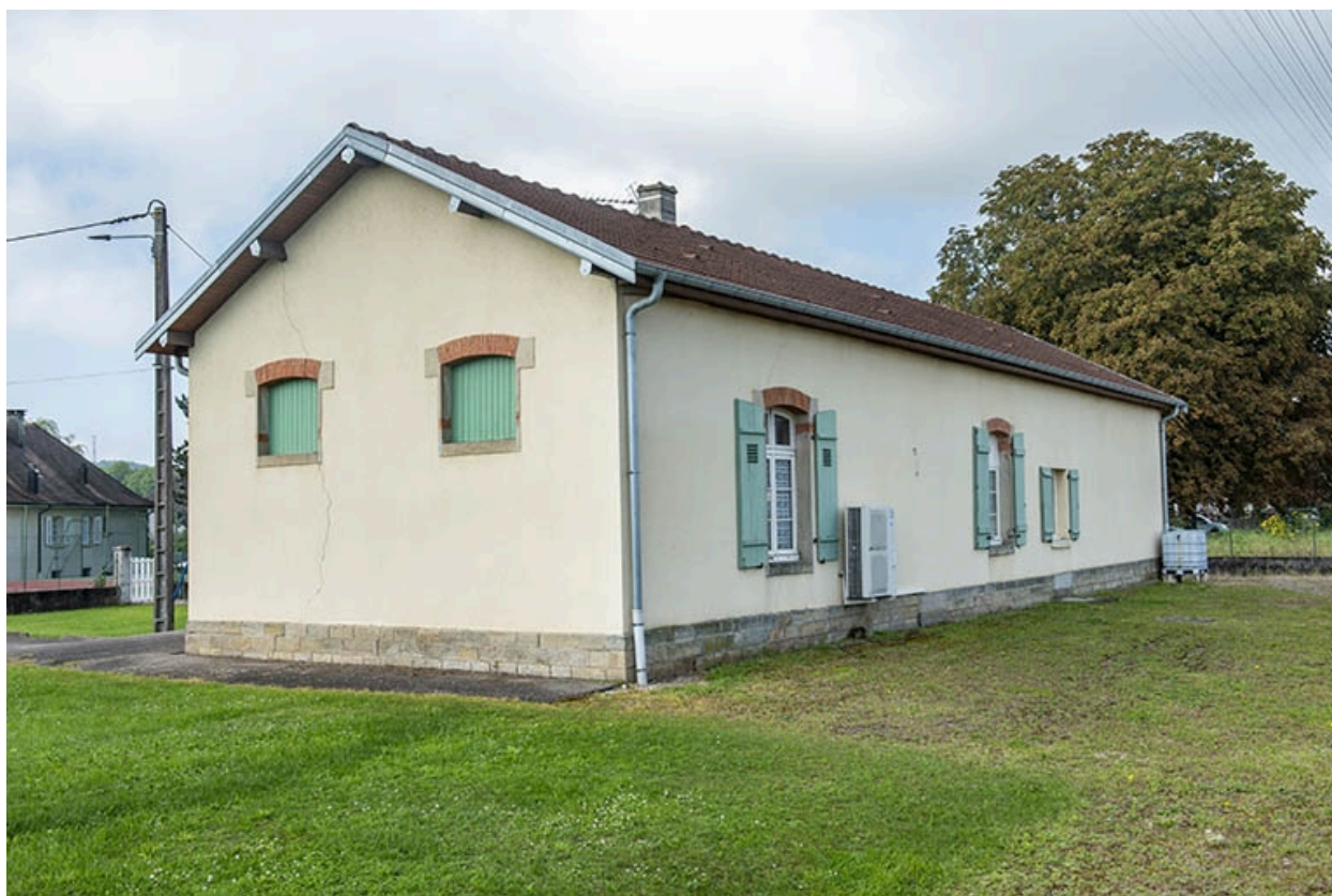
La maison, ancien bâtiment de bureau, façade postérieure.
