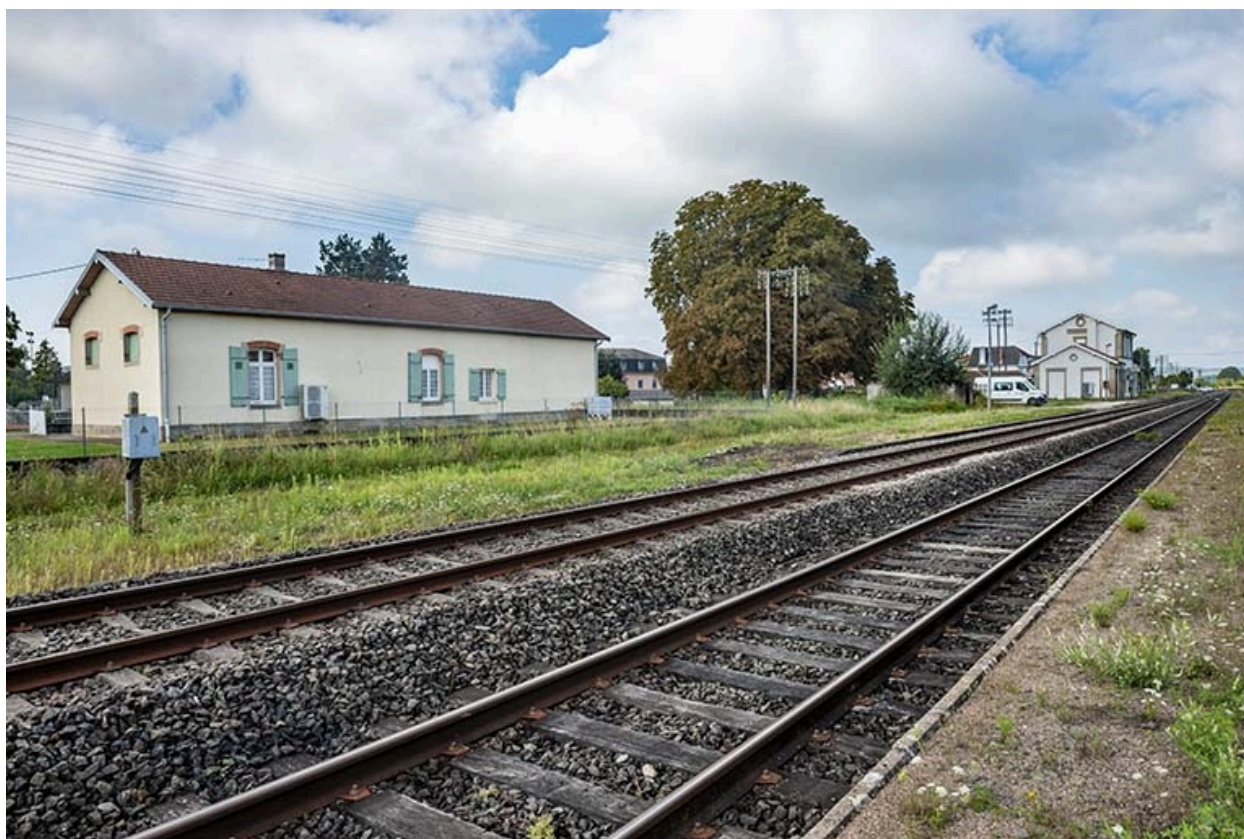
La maison, ancien bâtiment de bureau, vue éloignée.
