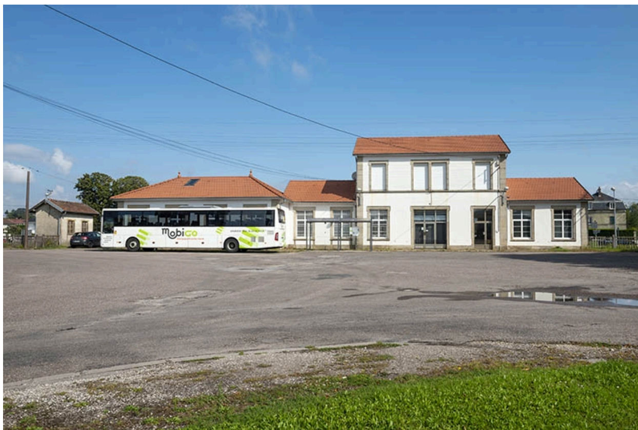
La gare, vue d'ensemble.
