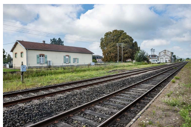
La maison, ancien bâtiment de bureau, vue éloignée. Phot. Jérôme Mongreville IVR43_20217000488NUC4A
