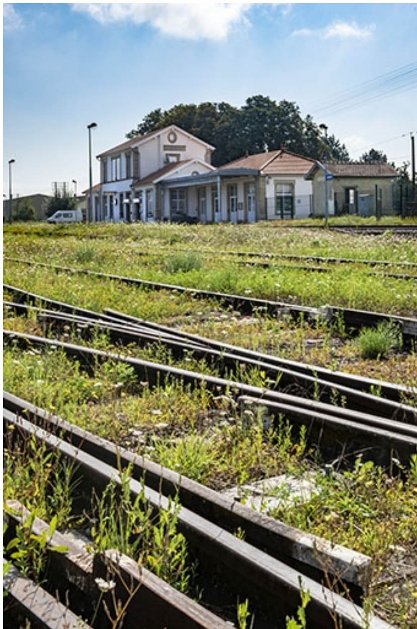
La gare, vue éloignée depuis les voies.
