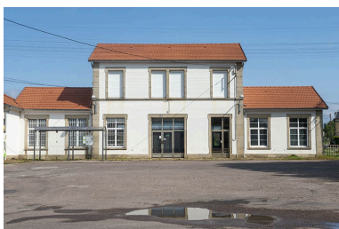
La gare, vue de face partielle. Phot. Jérôme Mongreville IVR43_20217000494NUC4A
