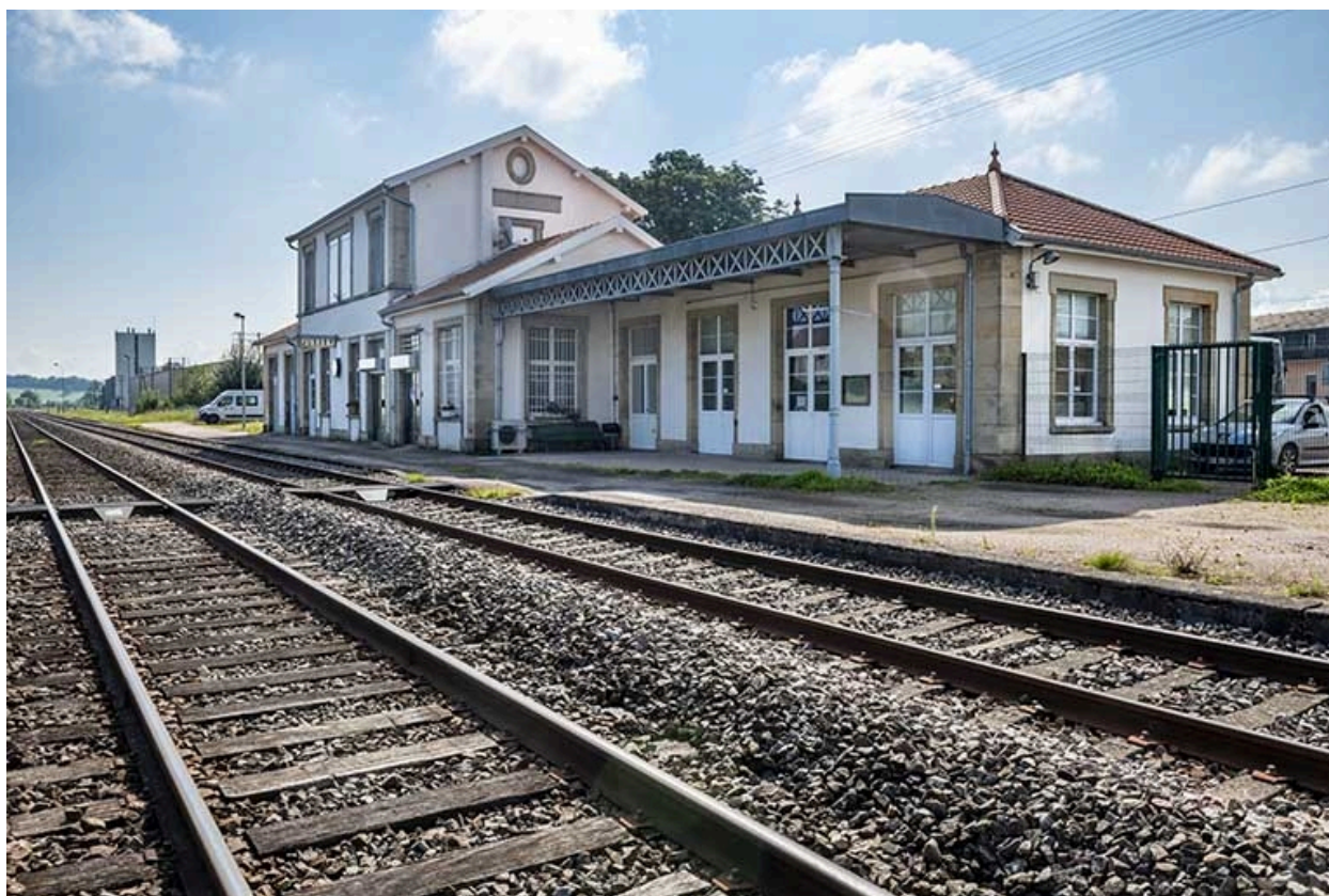
La gare, vue éloignée depuis les voies.
