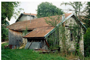
Façades postérieure et latérale droite. Phot. Laurent Poupard IVR43_19903900453ZA
