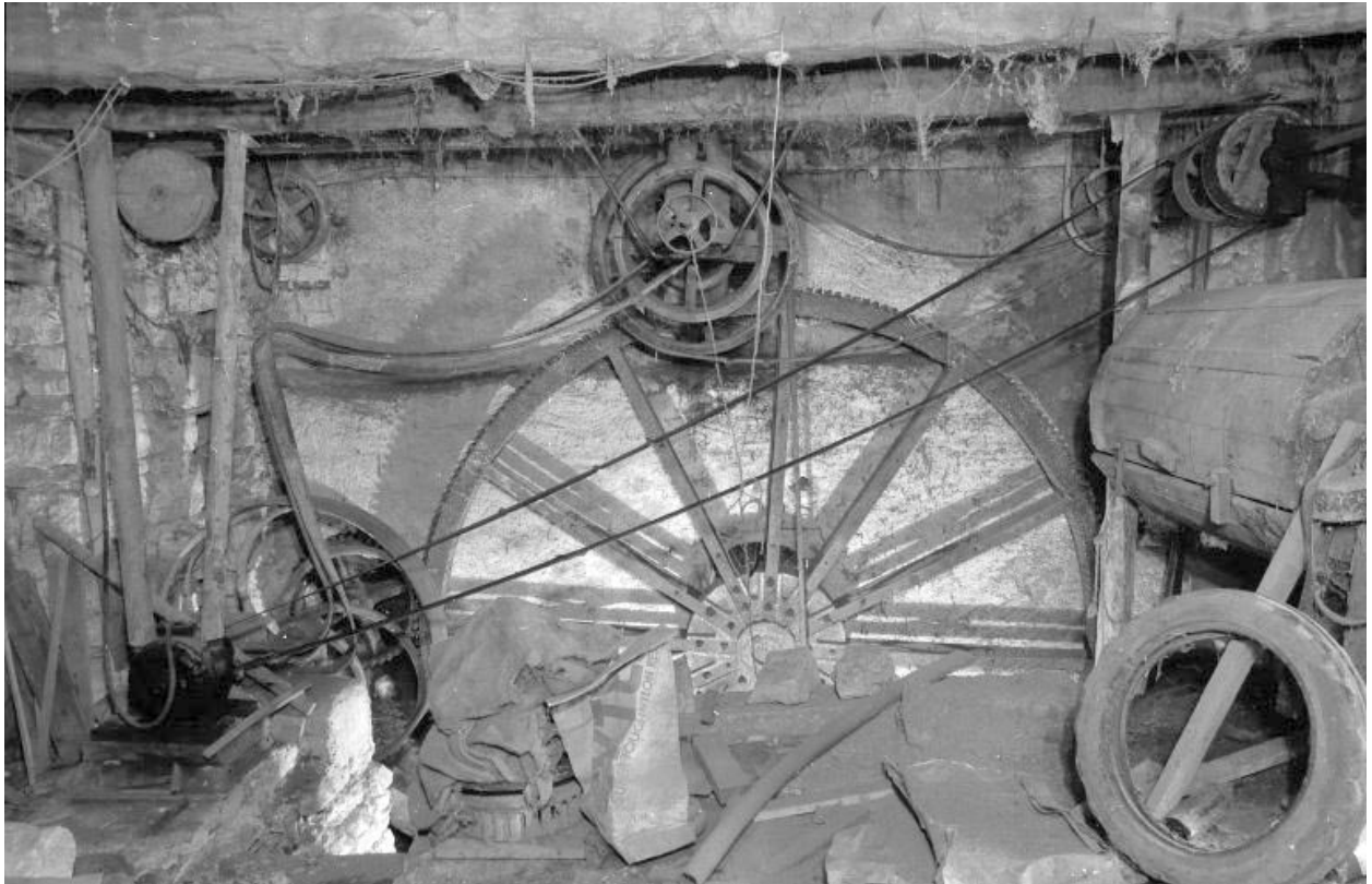
Intérieur de la salle des machines : moteur électrique, transmission de la roue hydraulique et tonneau de polissage.
