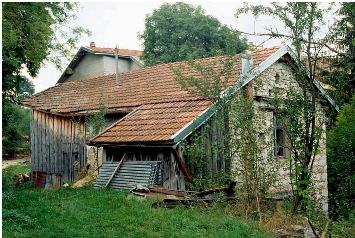
Façades postérieure et latérale droite.
