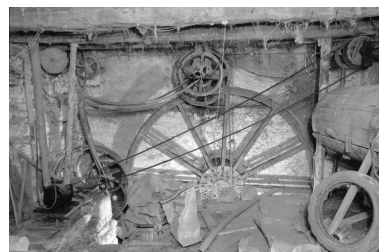
Intérieur de la salle des machines : moteur électrique, transmission de la roue hydraulique et tonneau de polissage. Phot. Laurent Poupard IVR43_19903900456Z
