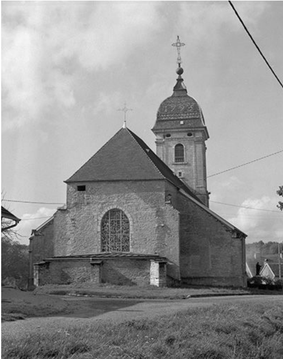
Face postérieure et clocher.
