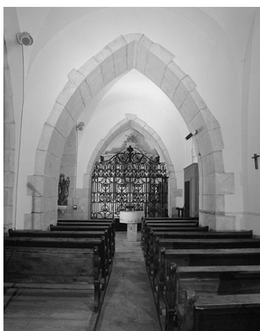
Bas-côté droit. Phot. Yves Sancey IVR43_19757000080X
