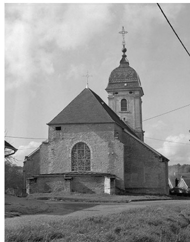
Face postérieure et clocher. Phot. Yves Sancey IVR43_19757000072X
