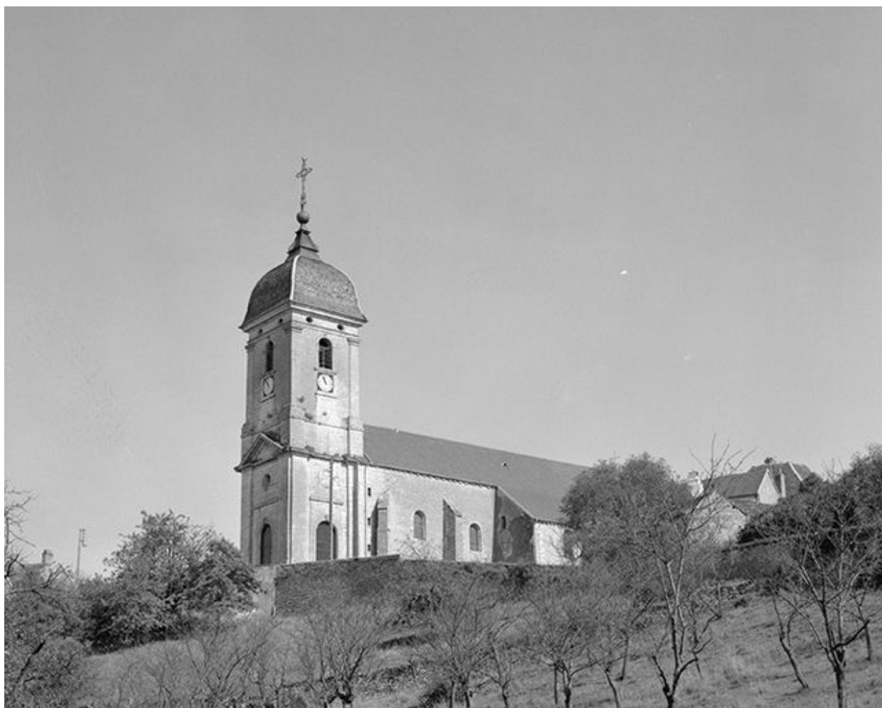
Façade latérale droite et clocher.
