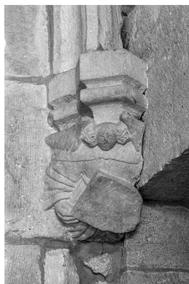
Intérieur : culot. Phot. Yves Sancey IVR43_19757000082Z
