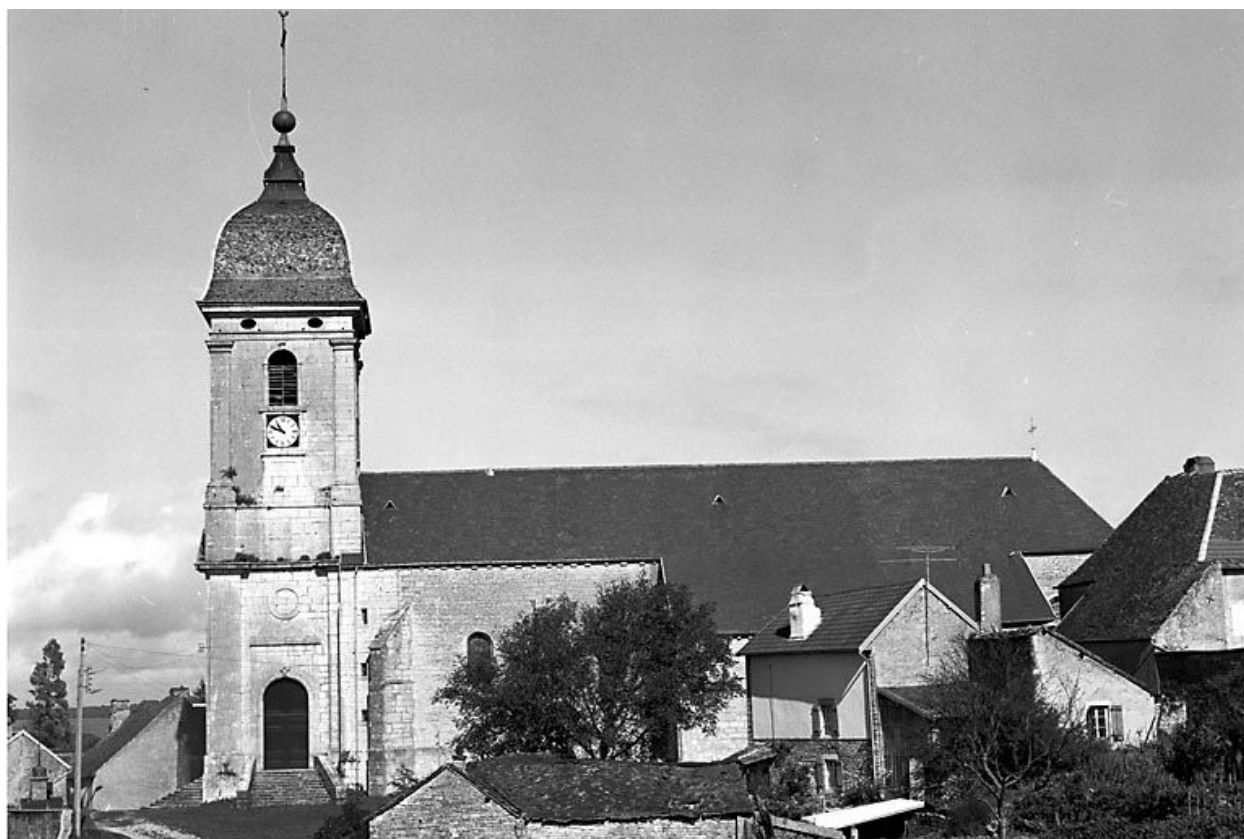
Façade latérale droite.
