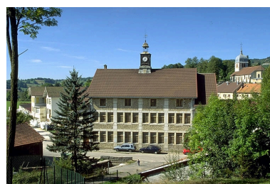
Foncine-le-Haut : usine d'horlogerie Château. Phot. Yves Sancey IVR43_19973901199ZA
