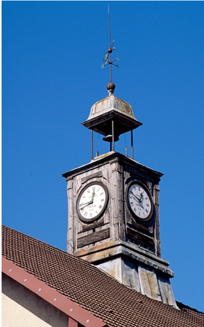
Foncine-le-Haut : clocheton de l'usine d'horlogerie Château.
