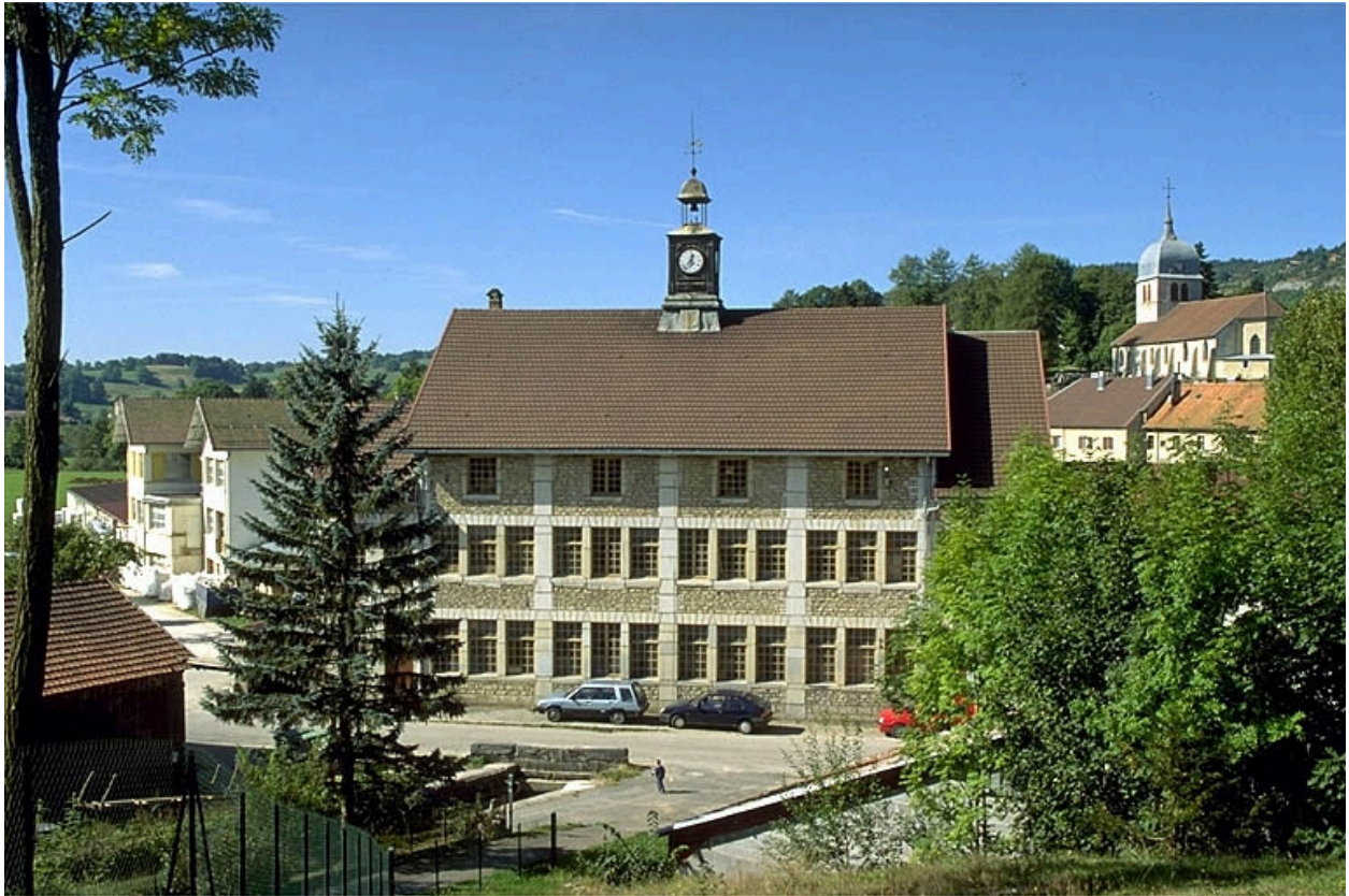
Foncine-le-Haut : usine d'horlogerie Château.
