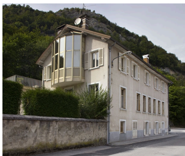
Morez : usine d'horlogerie Bailly- Comte, 20 rue de l'Industrie. Phot. Yves Sancey IVR43_20103900514NUC2A
