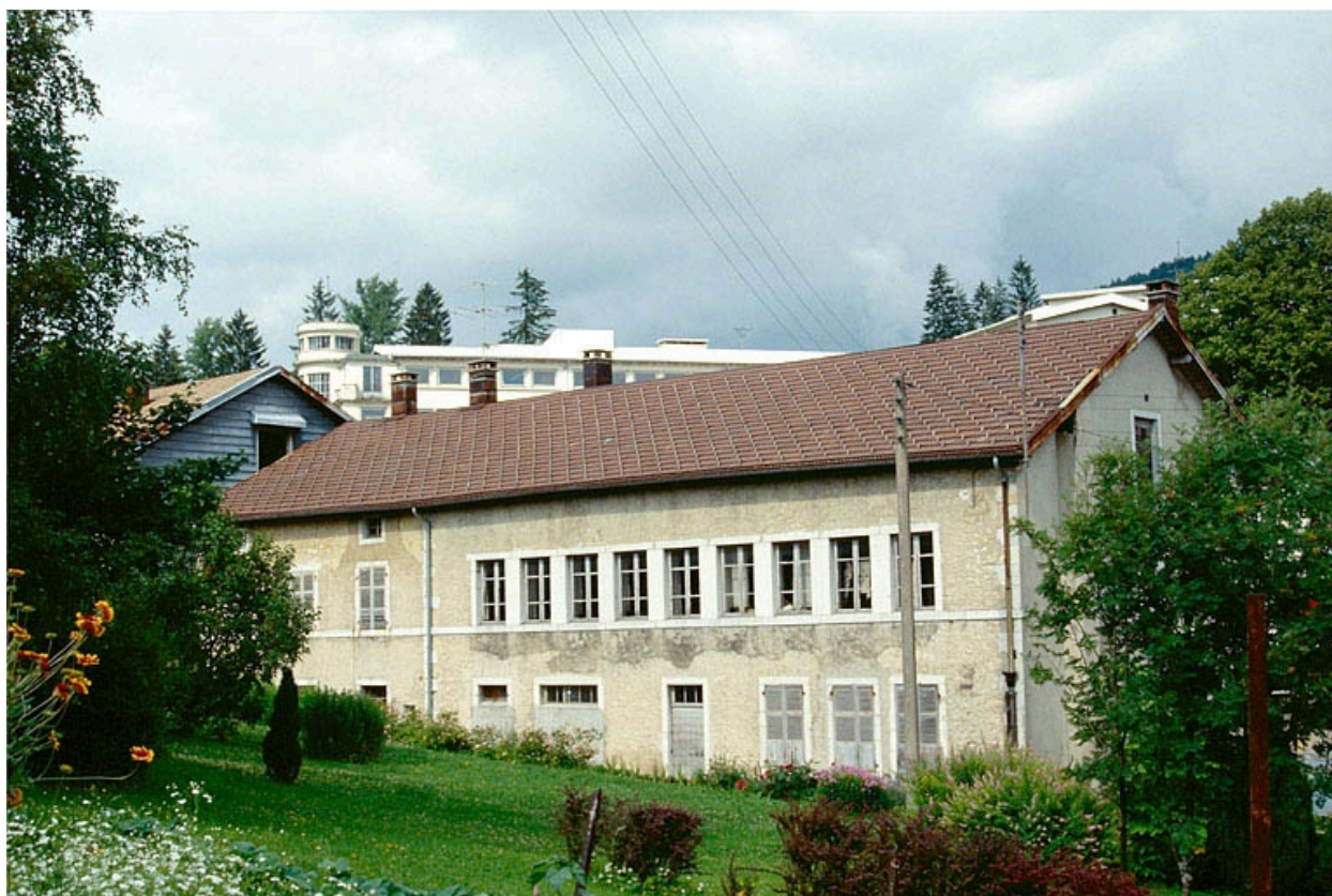
Morbier : usine d'horlogerie Arsène Cretin-l'Ange, 94-98 route Blanche.
