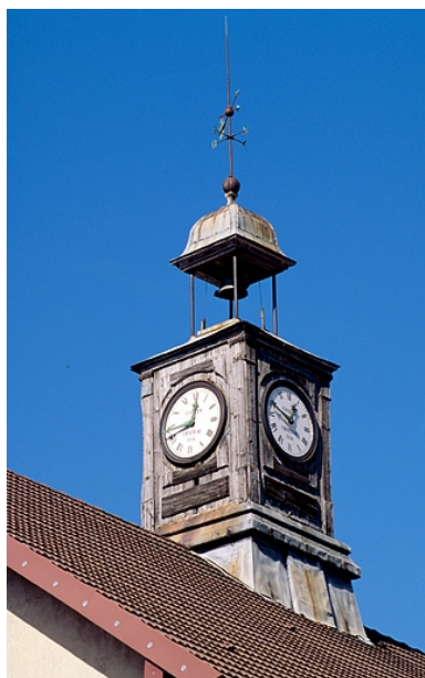
Foncine-le-Haut : clocheton de l'usine d'horlogerie Château. Phot. Yves Sancey IVR43_19973901212ZA
