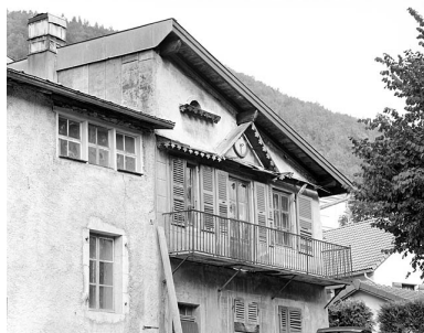
Morez : maison et atelier d'horlogerie, 4 à 8 chemin des Mouguettes. Phot. Yves Sancey IVR43_20033900443X
