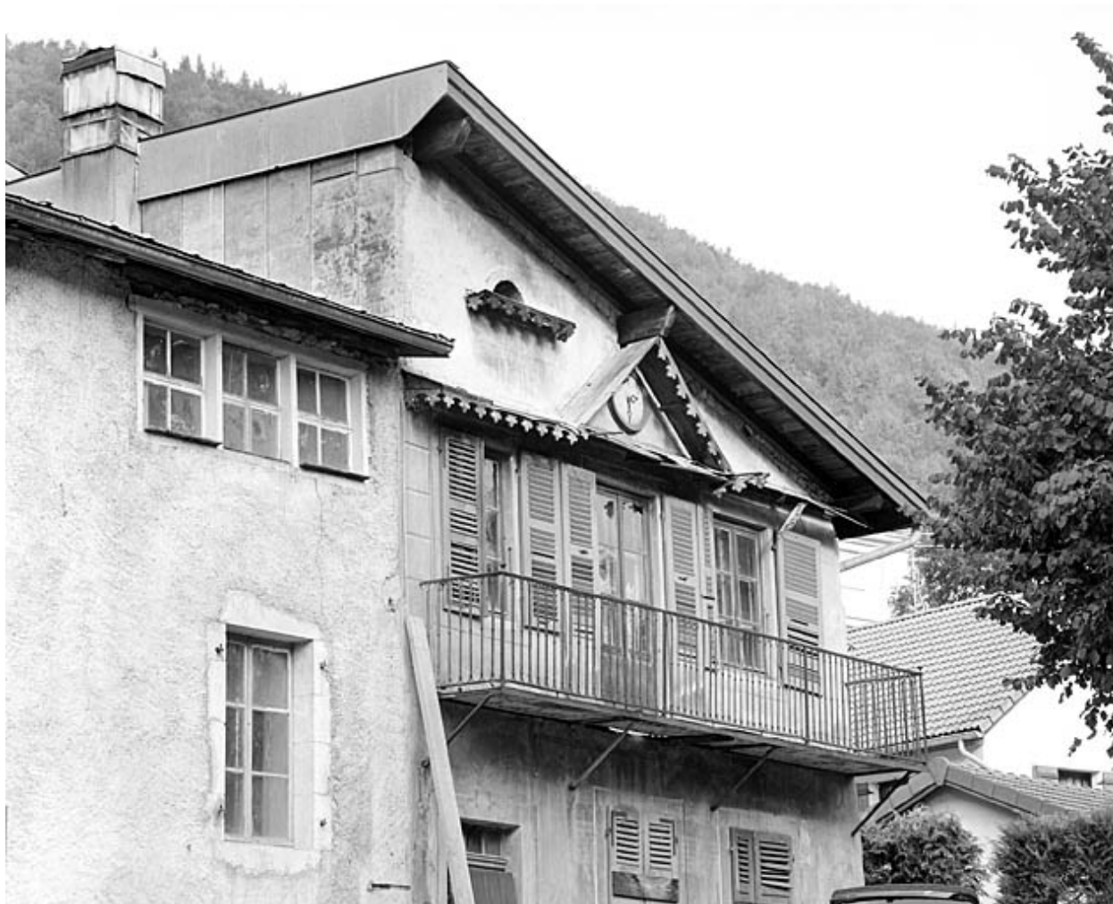
Morez : maison et atelier d'horlogerie, 4 à 8 chemin des Mouguettes.
