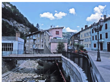
Morez : usine de fournitures pour l'horlogerie Bauduret, 84 rue de la République. Phot. Yves Sancey IVR43_20033900250XA
