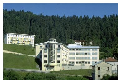
Morbier : usine d'horlogerie Girod, 83-93 route Blanche. Phot. Laurent Poupard IVR43_19913901559ZA
