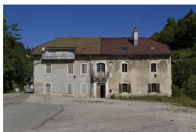
Morez : usine d'horlogerie et scierie Prost Frères, 2 à 10 rue des Forges. Phot. Yves Sancey IVR43_20103900663NUC2A
