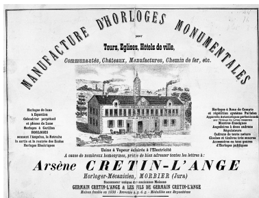
Morbier : façade antérieure de l'usine Cretin-l'Ange, [4e quart 19e siècle]. Phot. Jérôme Mongreville IVR43_19913900251X
