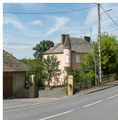
En amont du pont de Palinges, belle demeure à échauguettes. Phot. Pierre-Marie Barbe-Richaud IVR26_20137100481NUC4AQ
