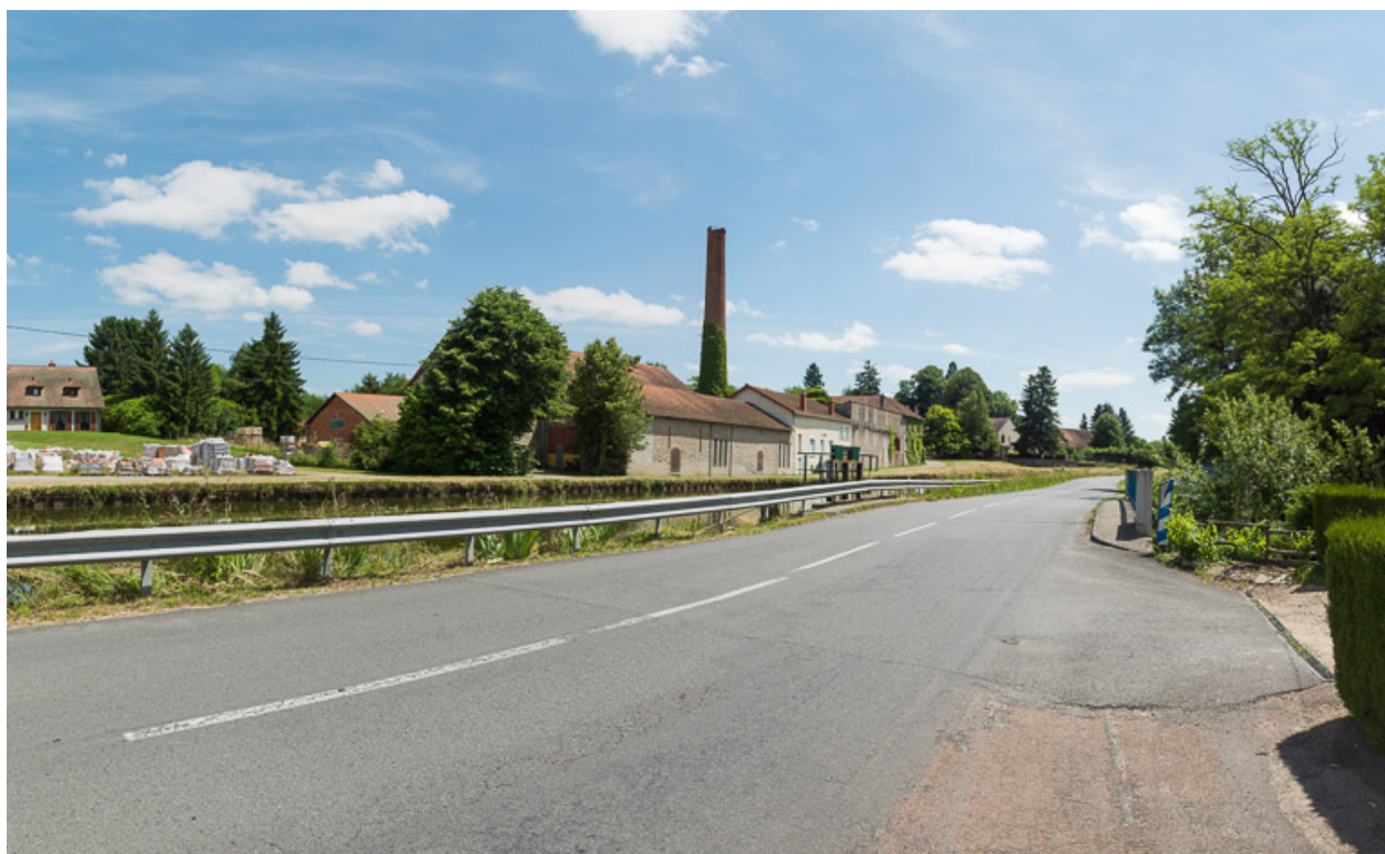
Vue d'ensemble des bâtiments rive gauche.
