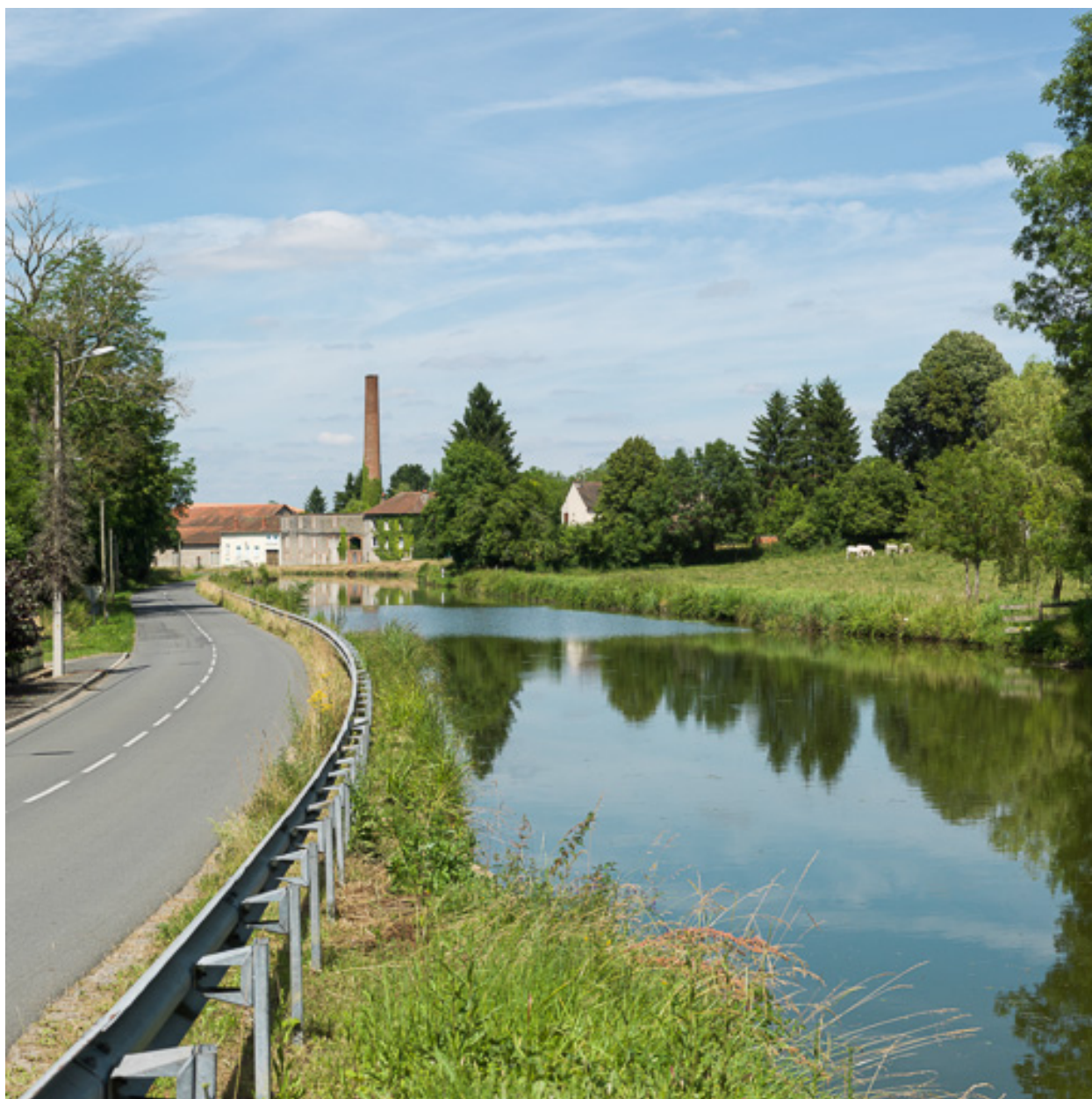
Vue d'ensemble d'aval.
