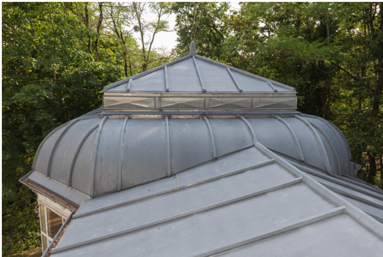
Jardin d'hiver, toiture vue depuis le premier étage de la villa.
