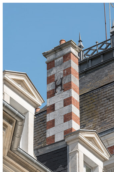
Cheminée avec ancre de tirant métallique au chiffre d'Henriette Mathé ("H"). Phot. Pierre-Marie Barbe-Richaud IVR26_20195800671NUC4A
