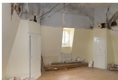
Étage de comble du pavillon nord, ancienne chambre. Phot. Pierre-Marie Barbe-Richaud IVR26_20195800588NUC4A
