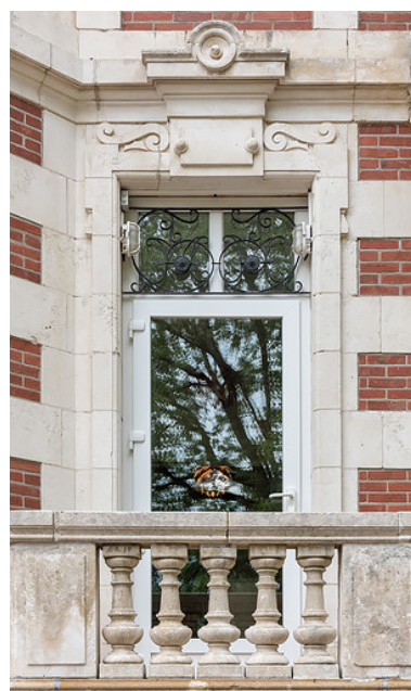
Porte d'entrée. Phot. Pierre-Marie Barbe-Richaud IVR26_20195800652NUC4A
