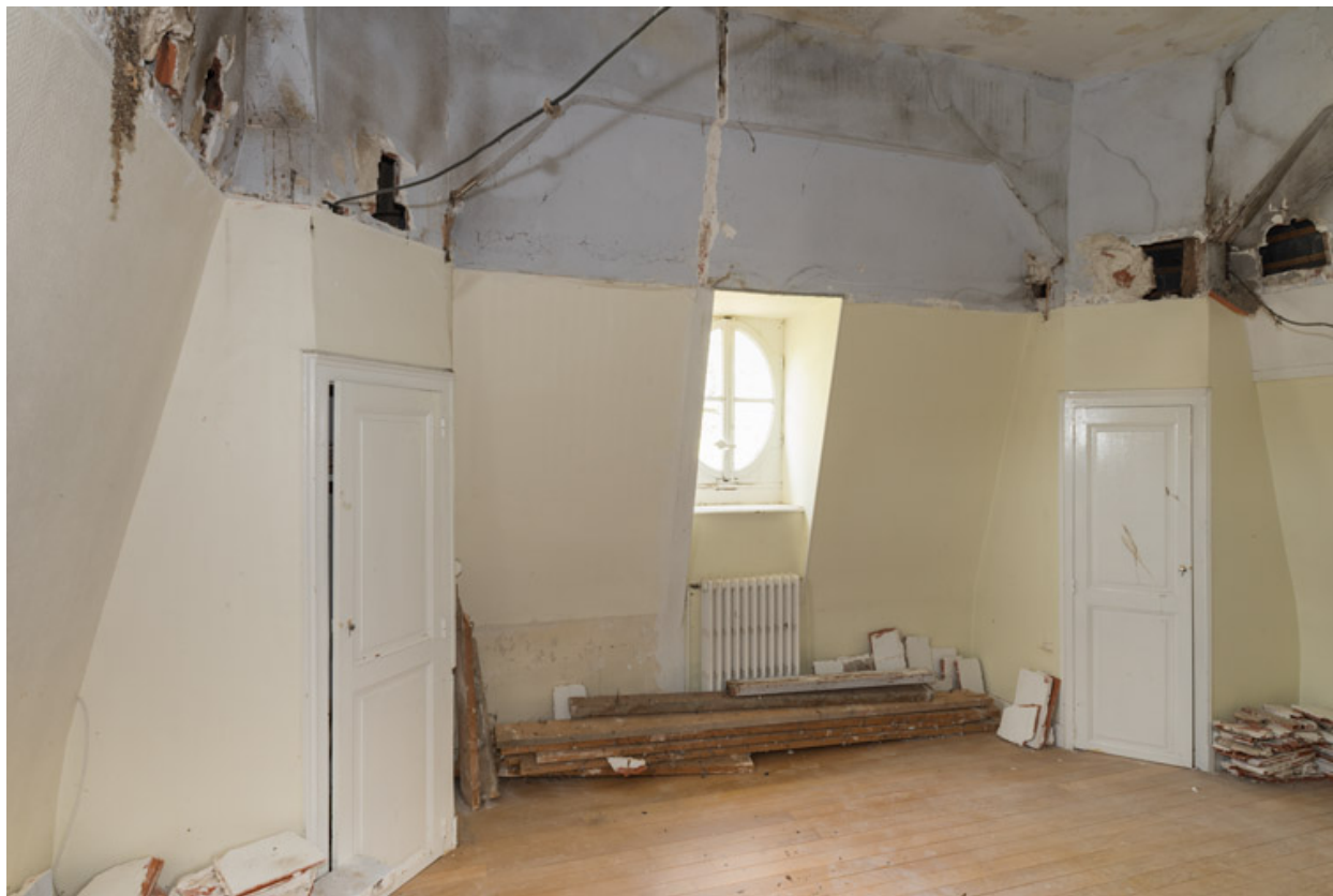
Étage de comble du pavillon nord, ancienne chambre.
