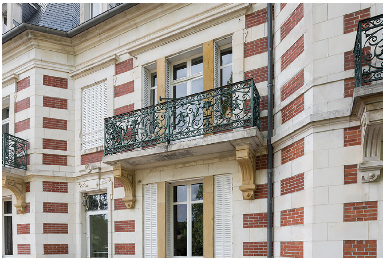
Balcon de la chambre de toilette au premier étage.
