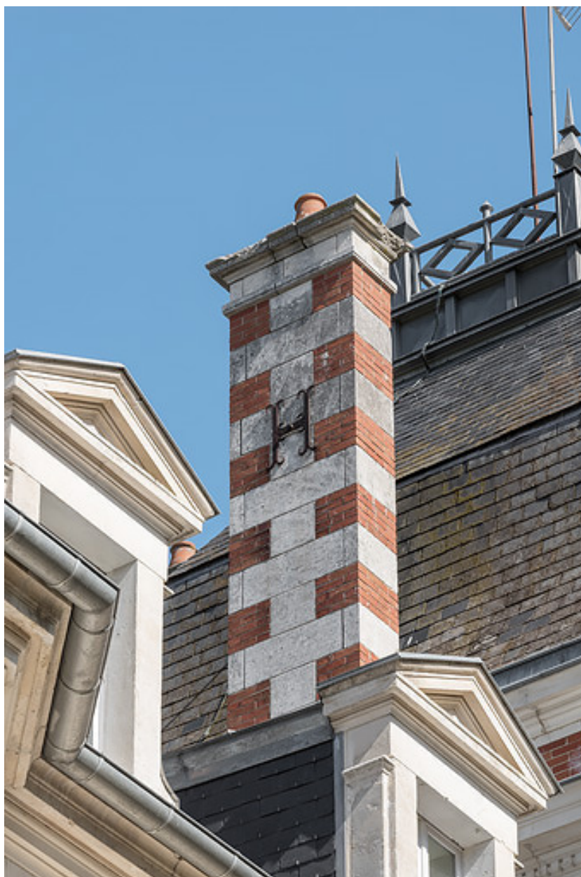
Cheminée avec ancre de tirant métallique au chiffre d'Henriette Mathé ("H").
