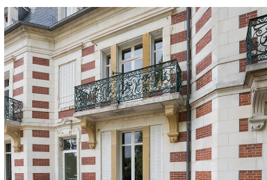
Balcon de la chambre de toilette au premier étage. Phot. Pierre-Marie Barbe-Richaud IVR26_20195800655NUC4A
