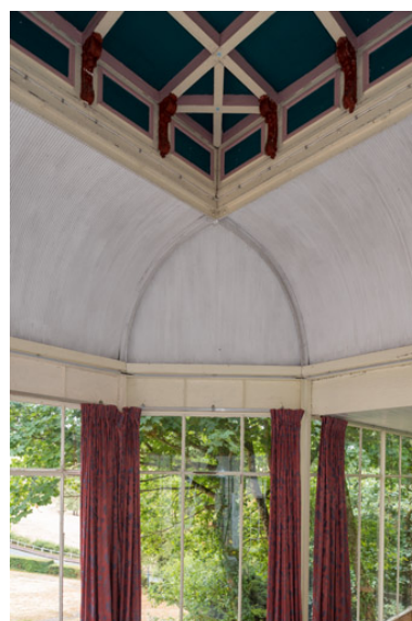
Jardin d'hiver, détail du couverture (voussure). Phot. Pierre-Marie Barbe-Richaud IVR26_20195800601NUC4A
