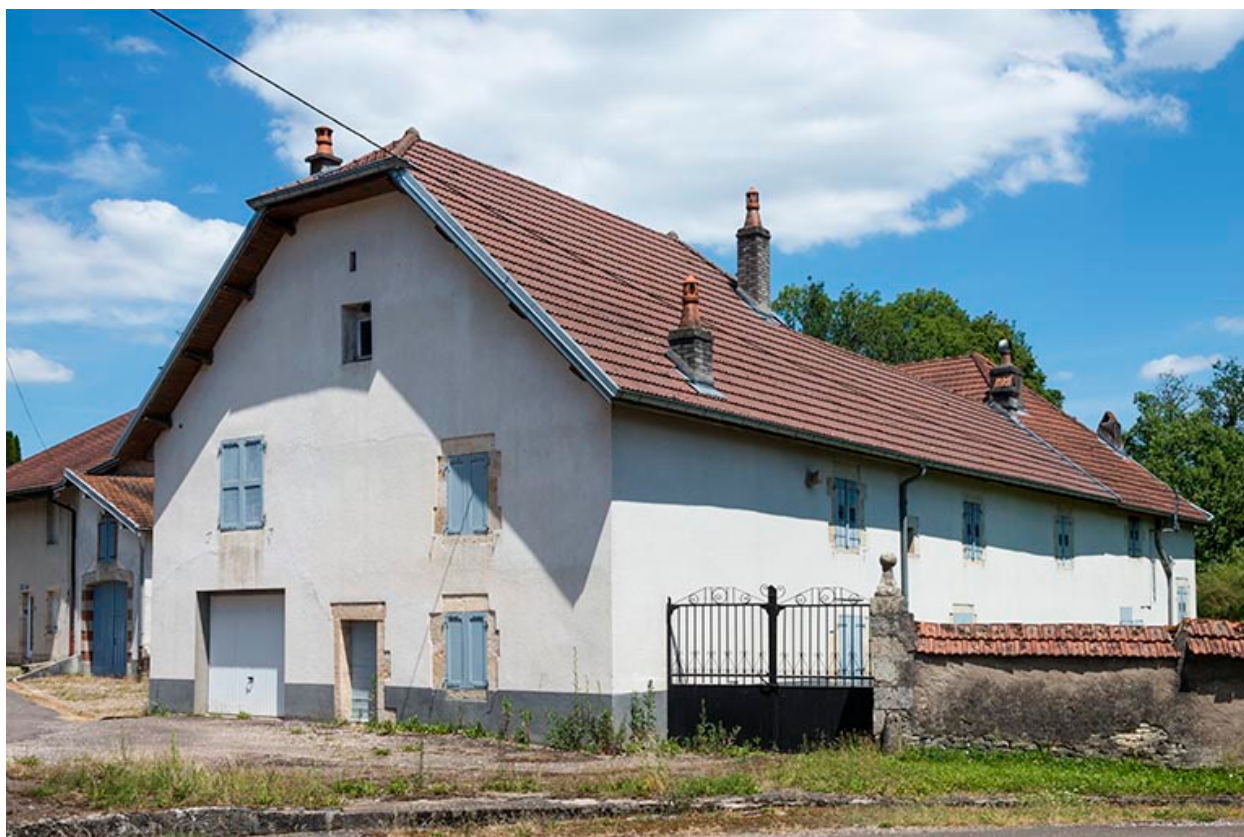
Vue sur la partie sud.
