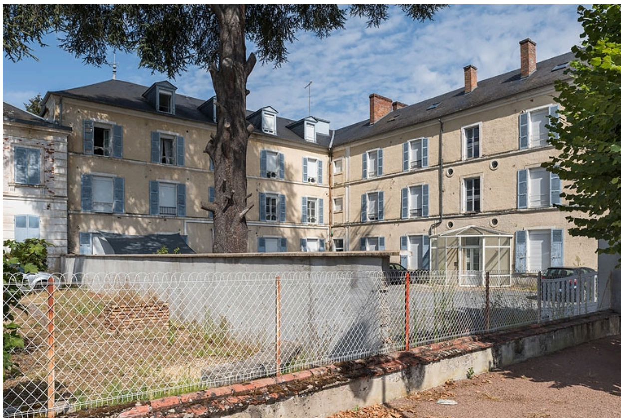
Façade sud du corps principal et façade est de l'aile en retour, vue en 2020.
