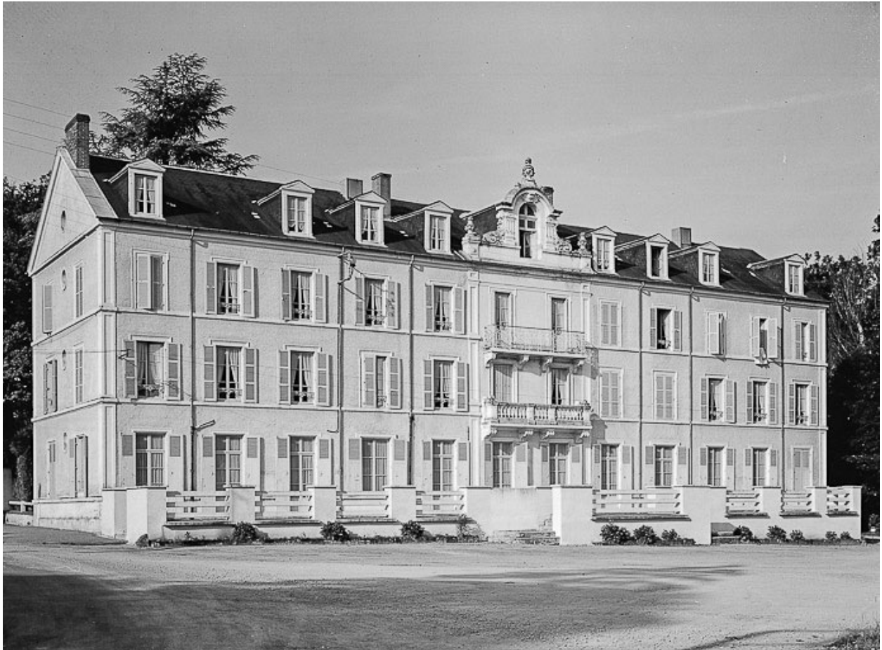
Façade nord du corps principal, vue de 1984.
