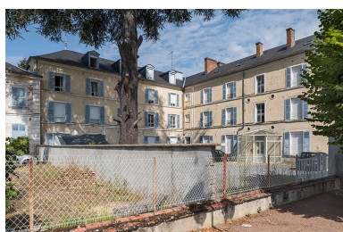
Façade sud du corps principal et façade est de l'aile en retour, vue en 2020. Phot. Pierre-Marie Barbe-Richaud IVR26_20205800579NUC4A
