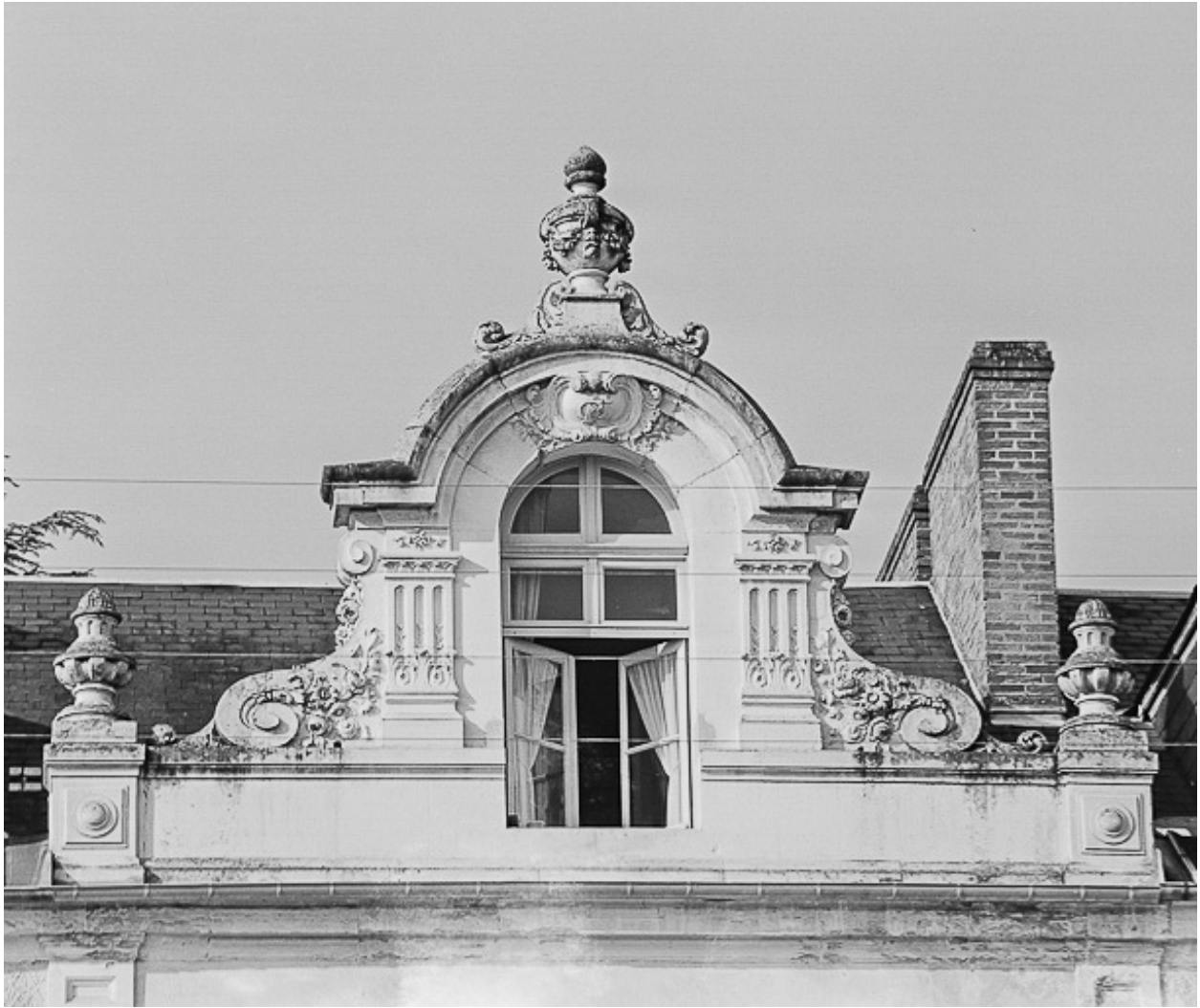
Lucarne centrale de la façade nord du corps principal, vue de 1984.
