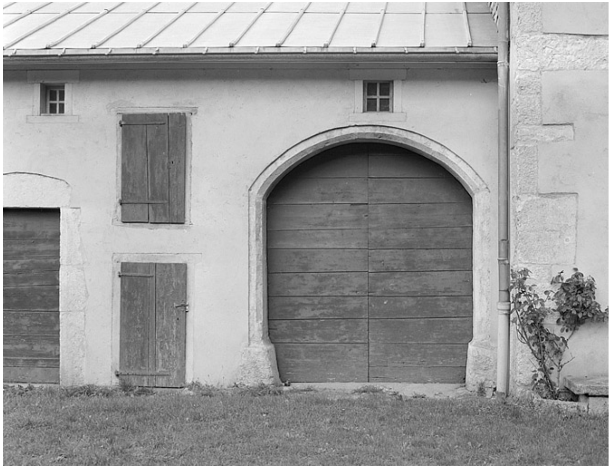
Porte d'accès aux communs.
