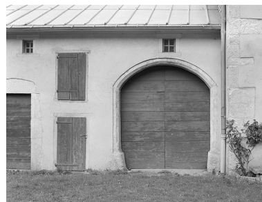
Porte d'accès aux communs. Phot. Jérôme Mongreville IVR43_19963900980X
