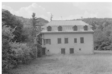
Face nord-est. Phot. Jérôme Mongreville IVR43_19963900975X
