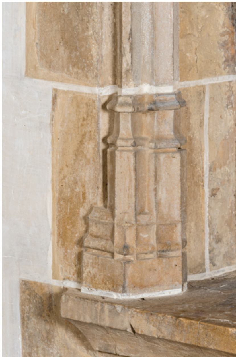
Détail : bases prismatiques des piédroits.
