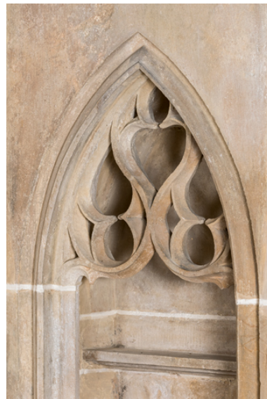
Détail : remplage de l'arc.
